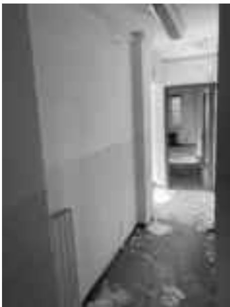
Piano terra- corridoio
