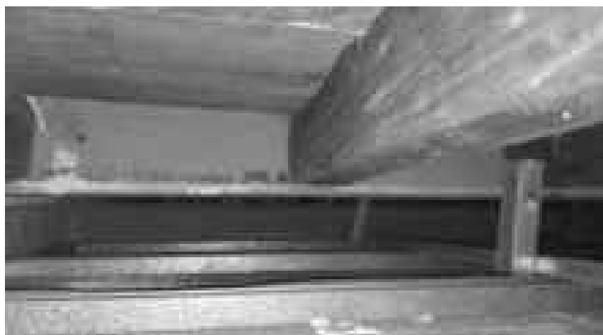
Foto 23 e 23bis: Dettagli solaio di calpestio del piano primo in carpenteria metallica e travetti in legno (corpo centrale) – Saggi S6 e S6'
