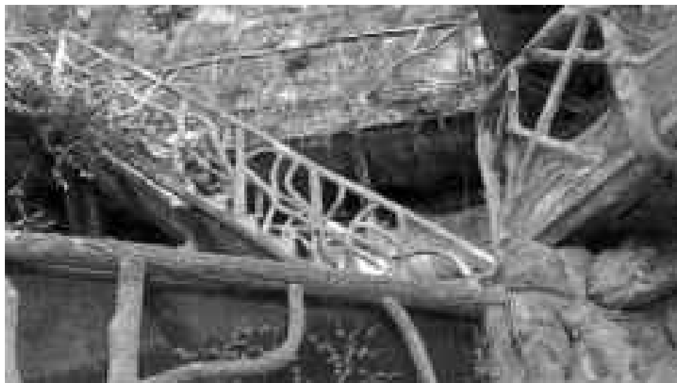
Foto49: Particolare della scaletta di accesso al locale posto a piano -1
