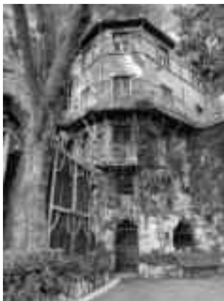
Fig.2 Facciata della Casa del Giardiniere
