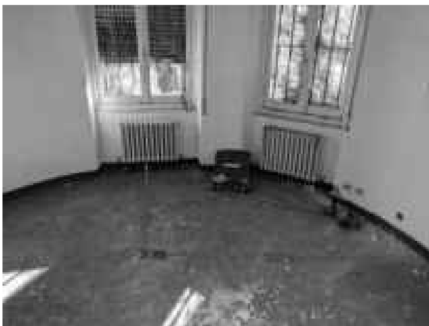
Figura 18 – Posizione indagine R3 – Stanza a destra spalle all'ingresso, zona lunetta
