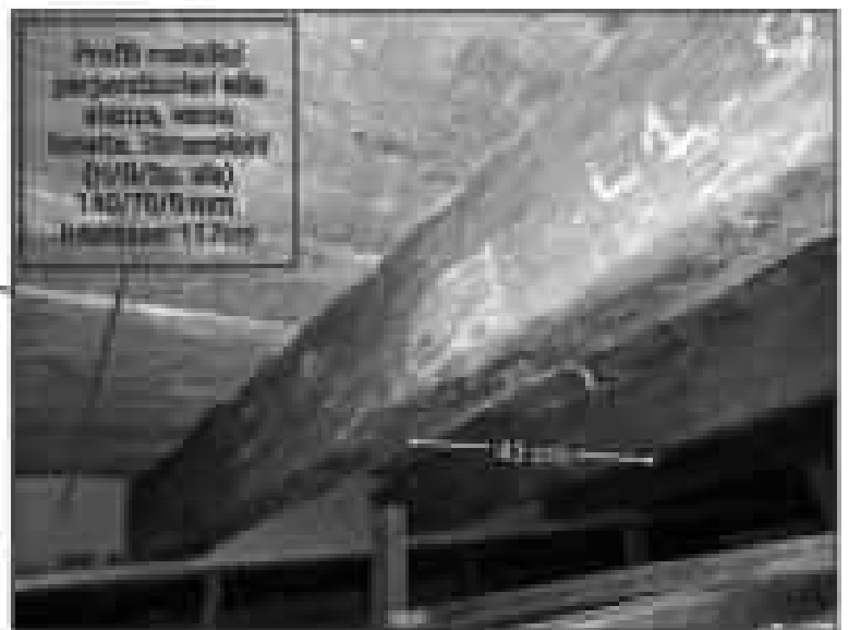
Completamento materiale. Assenza di degrado biologico interno
