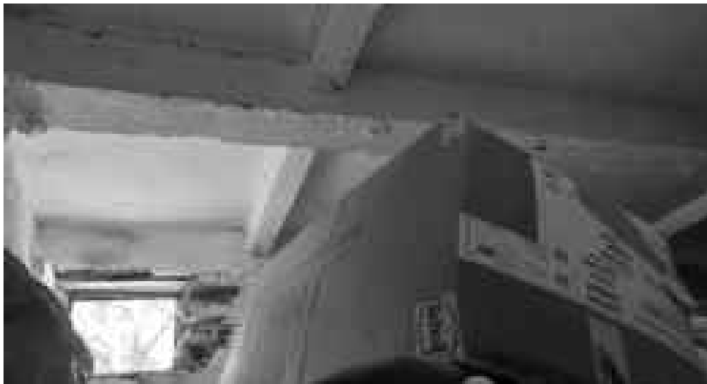
Foto28: Copertura piana con travi in acciaio rivestite e soletta soprastante in c.a.(punto di indagine S5)
