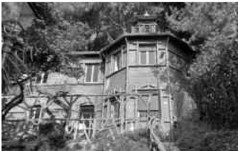
Foto34: Facciata dell'edificio che si affaccia su piazza Corvetto
