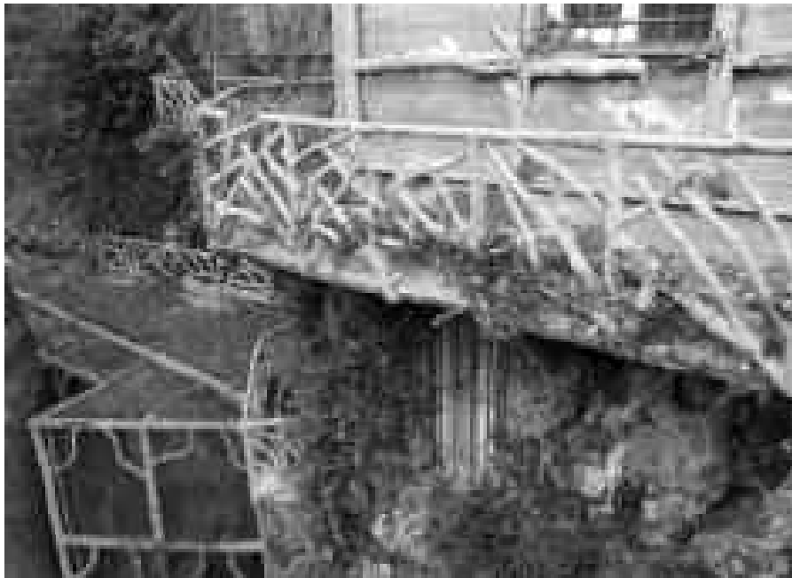
Foto42: Ringhiera in cls effetto legno del ballatoio
