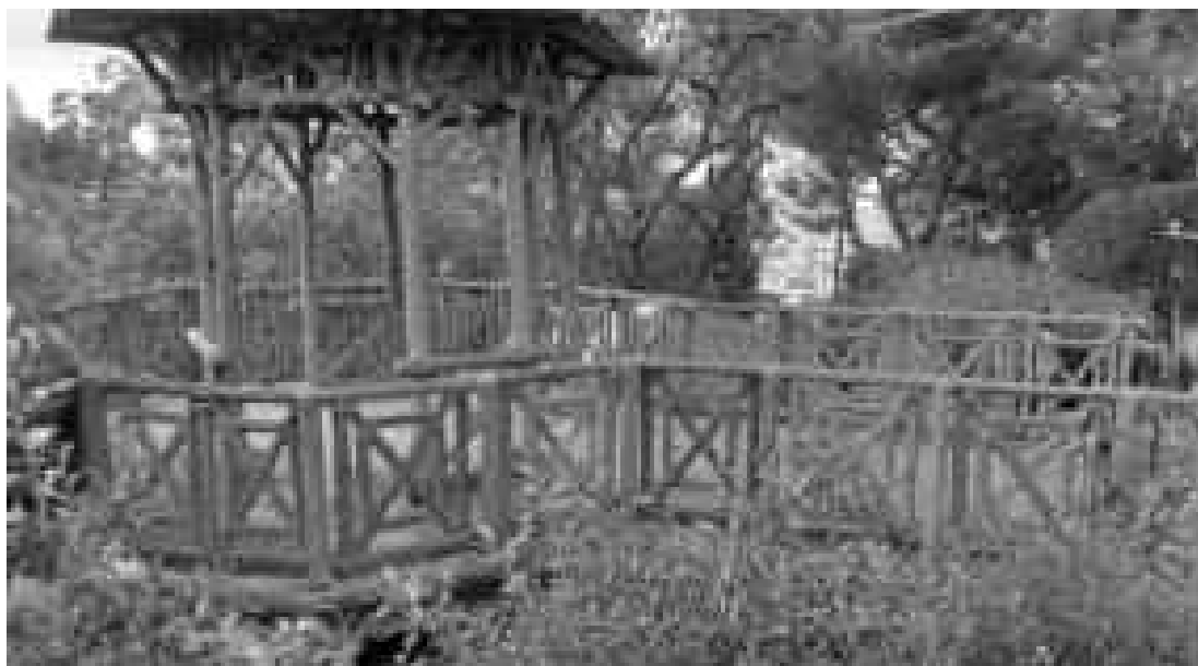
Foto45: Belvedere superiore sulla porzione piana della copertura
