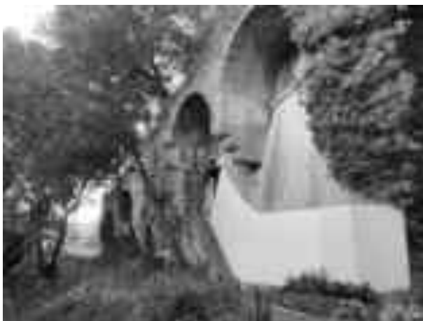
fig.1,2,3 arcate di sostegno alla scalinata
