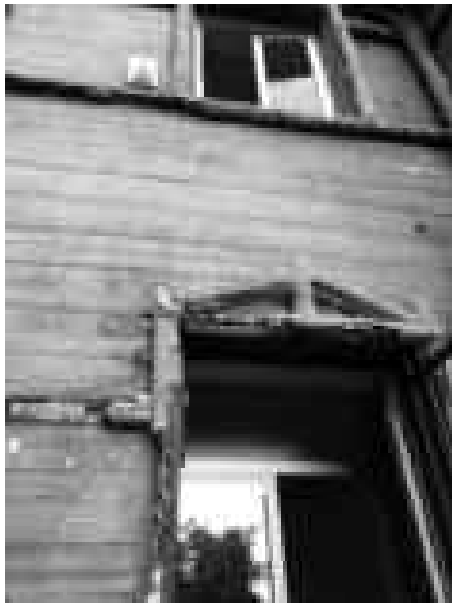
Foto36: Particolari dei decori della facciata in cls rinforzato 'effetto legno' e intonaco di facciata ammalorato
