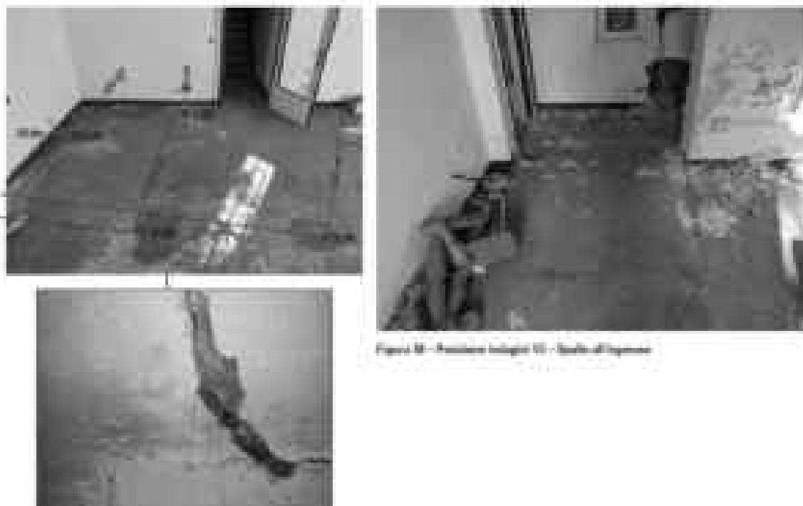
Foto21: Indagini a pavimento per identificazione della volta (punto indagini V1, V2, V3, V4, V5)
