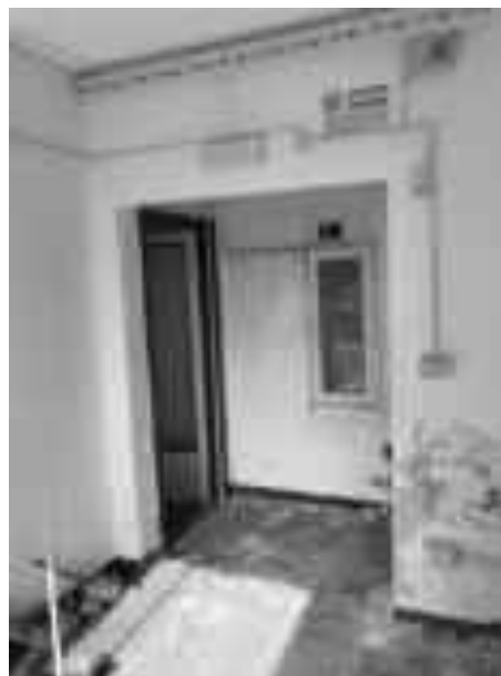
Piano terra- ingresso- varco su corridoio
