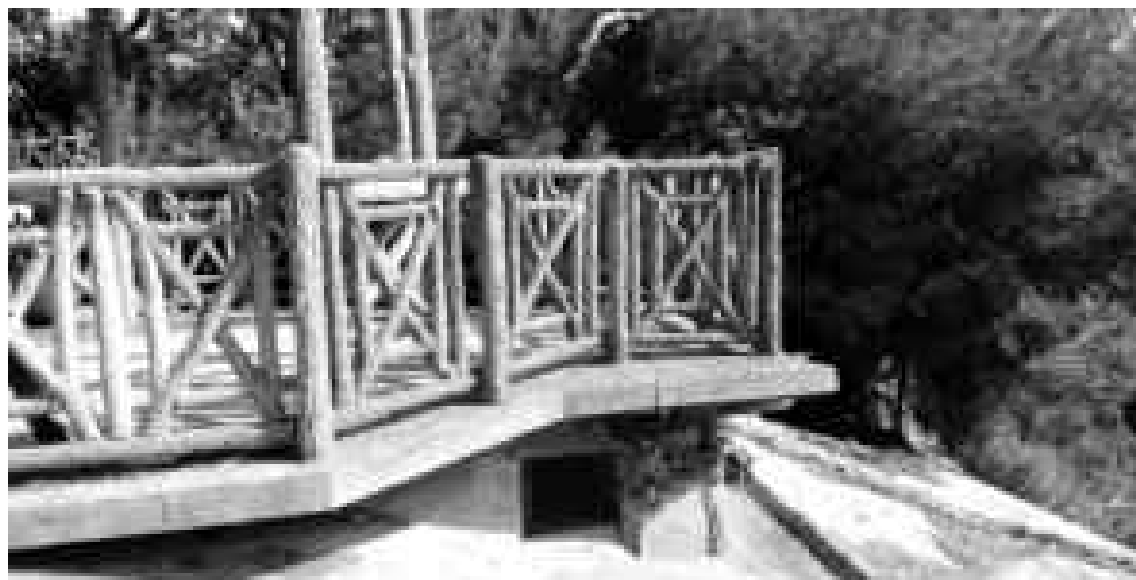
Foto47: Dettaglio della ringhiera del belvedere
