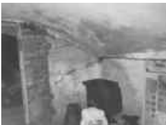
Locale posto al piano -1
