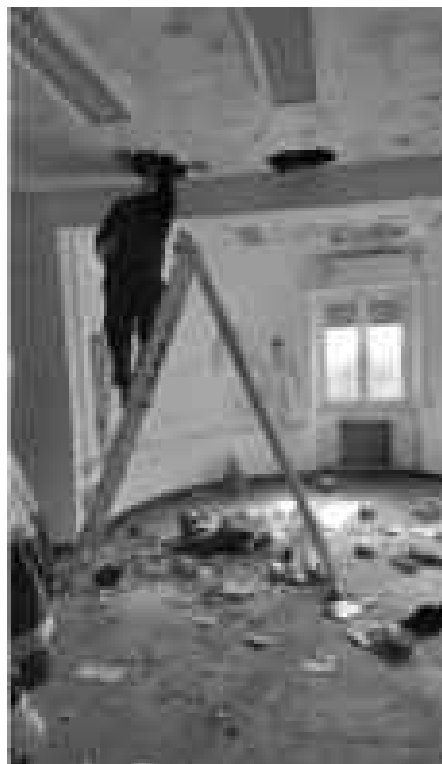
Foto27: Apertura controsoffitto a piano primo per visionare la copertura (saggio S7)
