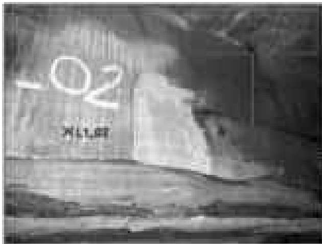
Completamento materiale. Assenza di degrado biologico interno
