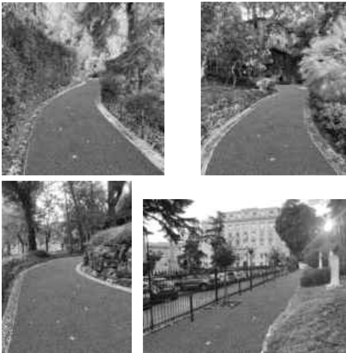
Fig.1 Rendering dei viali interni del Parco, nuova pavimentazione in cls architettonico drenante.
