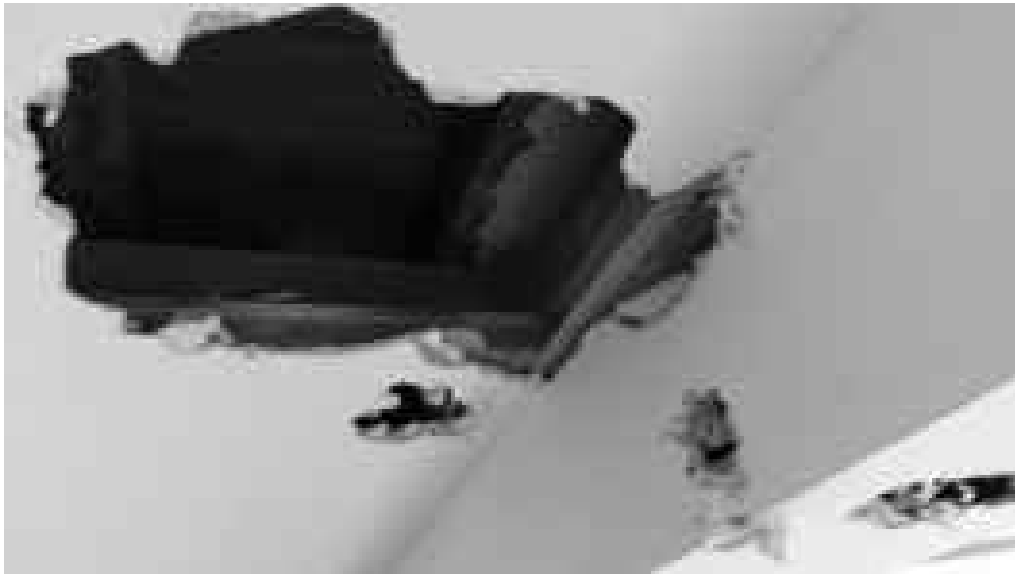
Foto22: Apertura controsoffitto per saggi S6 e S6'
