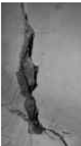
Foto14: Apertura nella volta a botte in pietrame
