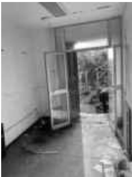
Piano terra - ingresso
