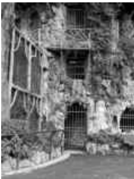
Porzione della facciata in rocciatu
