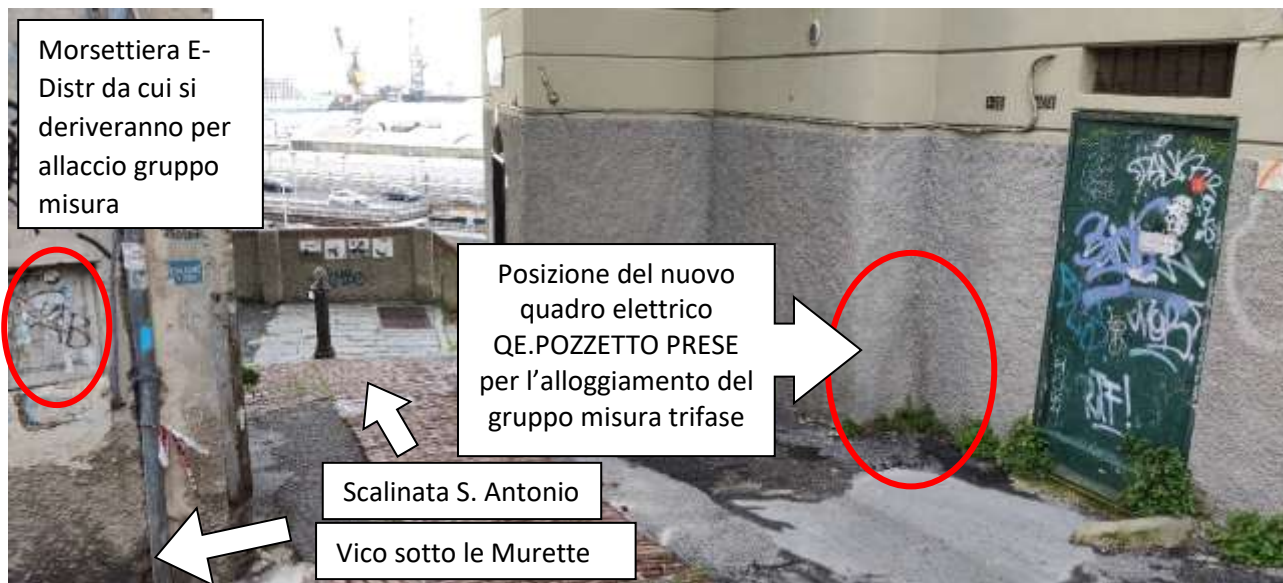
Figura 7 – Posizione del nuovo armadio per quadro elettrico QE.POZZETTO PRESE e per l'alloggiamento del gruppo misura trifase
