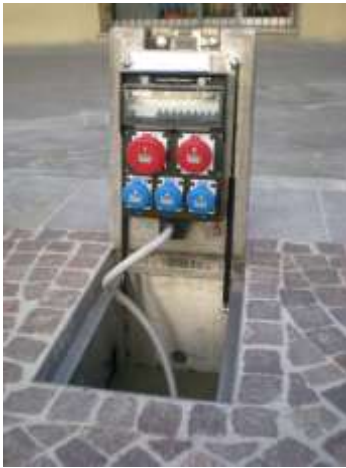
Figura 12 – Pozzetto prese in posizione aperta ed esempio indicativo quando chiuso con passaggio all'esterno dei cavi garantito (Fonte GIFAS)
