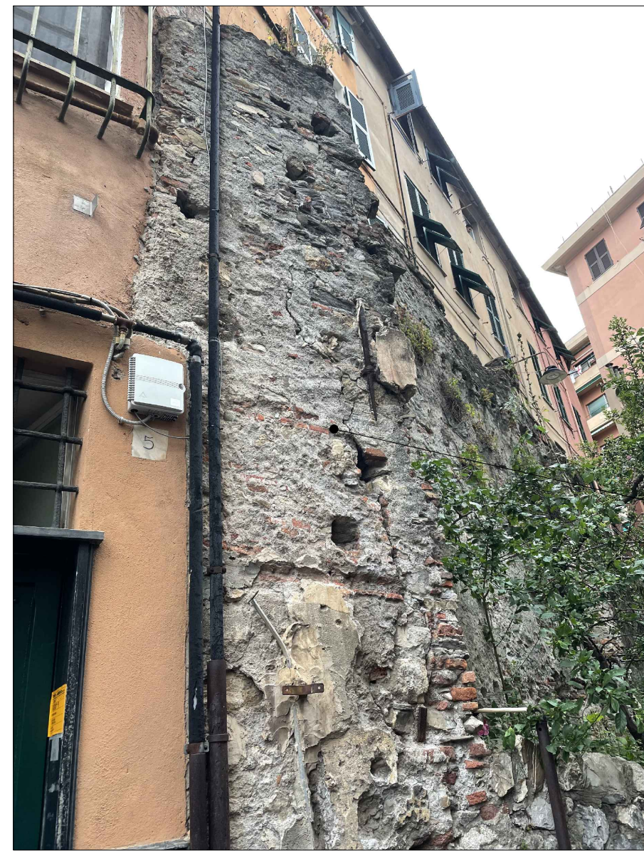
elemento verticale in muratura mista
