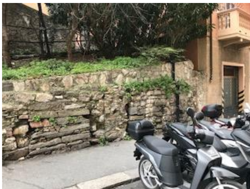
Foto 11: Muratura alla base di vico San Salvatore con retrostante aiuola con paramento in muratura sul fronte
