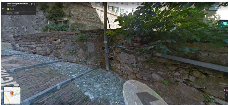
Foto 17: Primo tratto murario verso Campopisano di Salita della Montagnola
