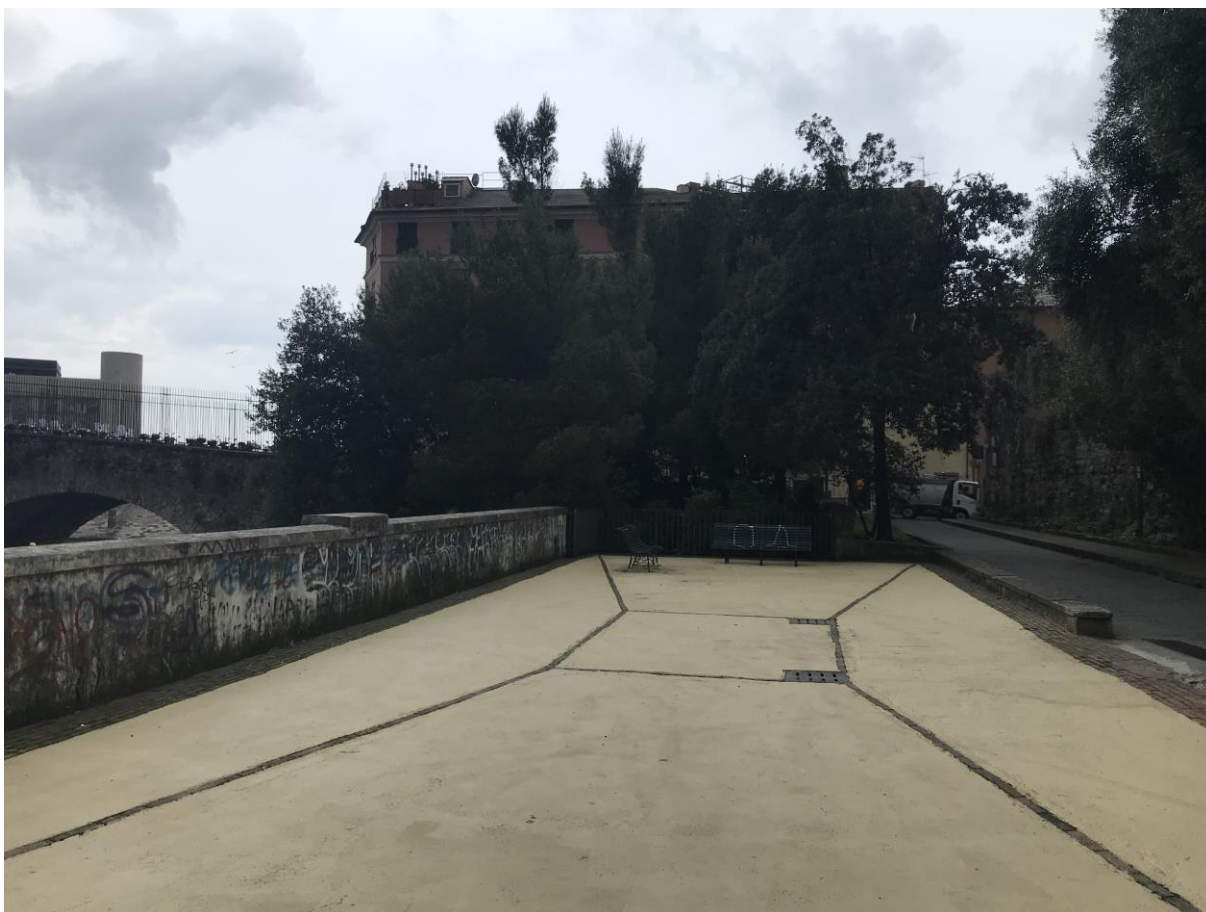
Foto 10 – Percorsi interni ai Giardini Baltimora lungo via del Colle
