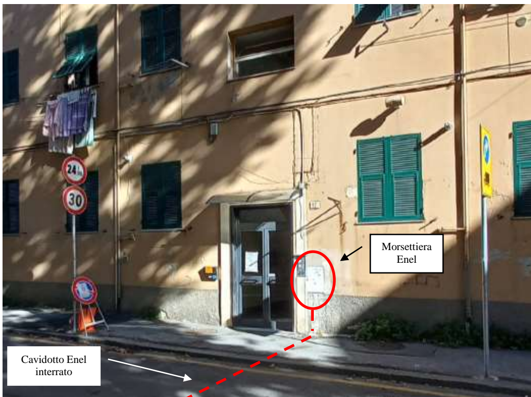
Figura 13 – Punto di Derivazione da morsettiera Enel al civico 12
