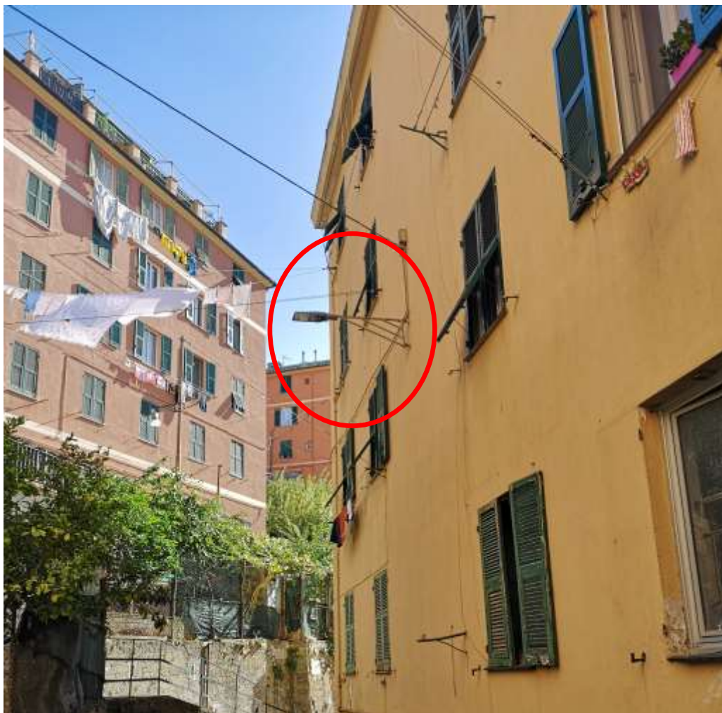
Figura 5 – Altro esempio di posizionamento indicativo a parete a sbraccio negli spazi liberi tra le finestre dell'edificio
