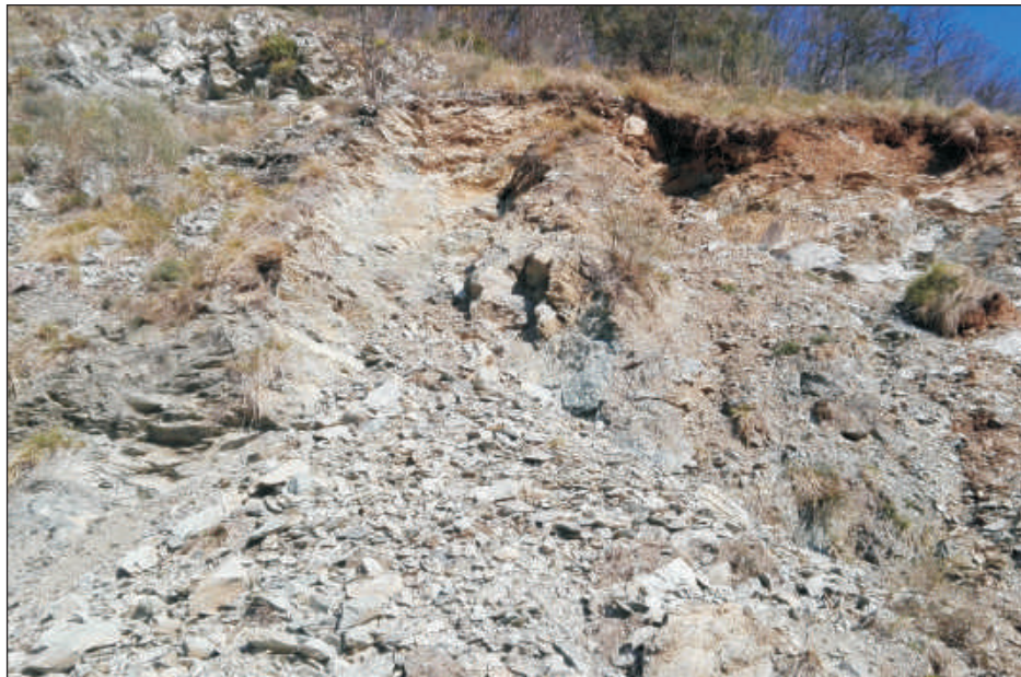
FOTO 3: Dettaglio scarpata settore sud dissesto 1 vista da Salita Tuvio
