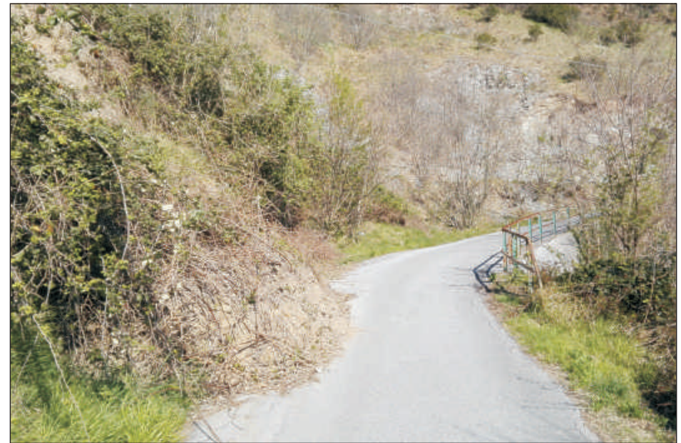
FOTO 6: Panoramica zona di accumulo dissesto 2 vista da via S. Pietro ai Prati
