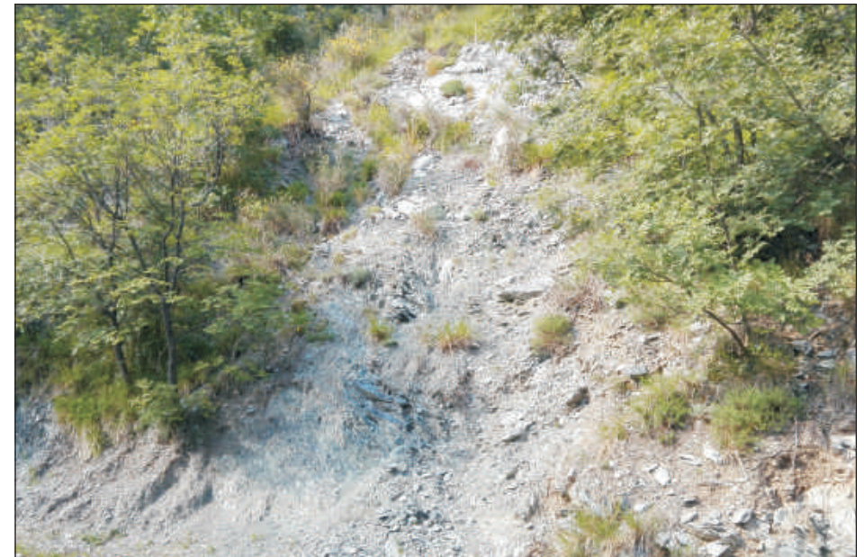
FOTO 4: Dettaglio scarpata settore nord dissesto 1 vista da Salita Tuvio
