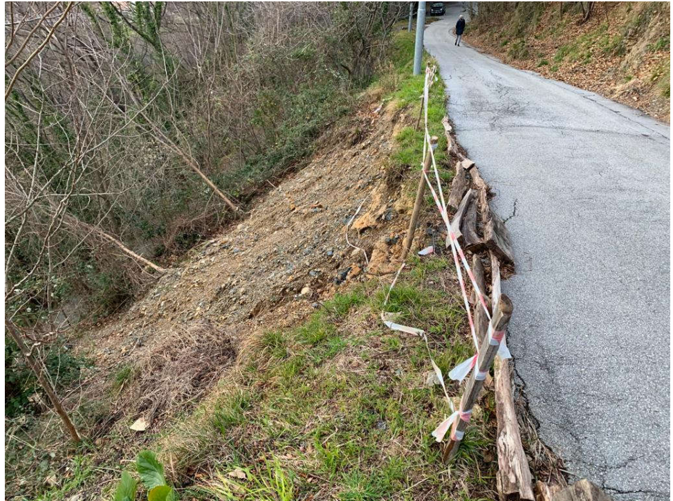
Foto 3 - frana da via San Pietro ai Prati
