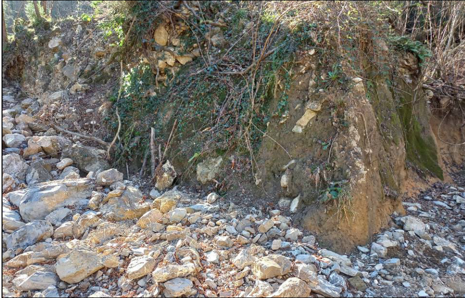
Foto 6: Condizioni alveo stato attuale, P61-P66, sponda sx in corrispondenza dell'immissione di un Rio senza nome.
