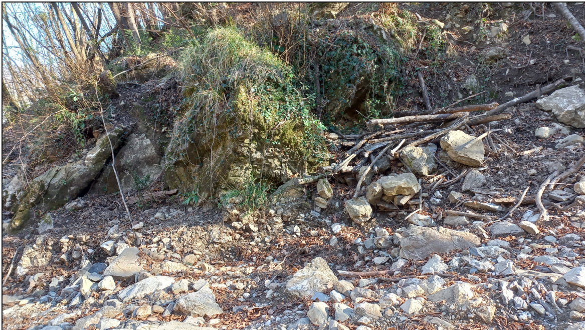
Foto 5: Condizioni alveo stato attuale, tra P52-P59, sponda dx
