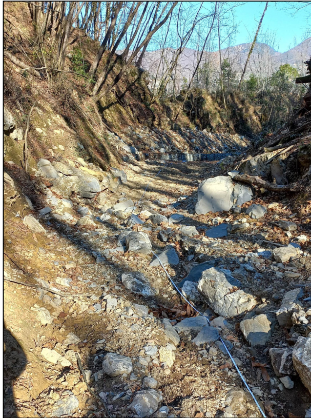
Foto 7: Condizioni alveo stato attuale, P80-P100. Al fondo si intravede l'inizio del settore oggetto dei lavori di cui al precedente Lotto1
