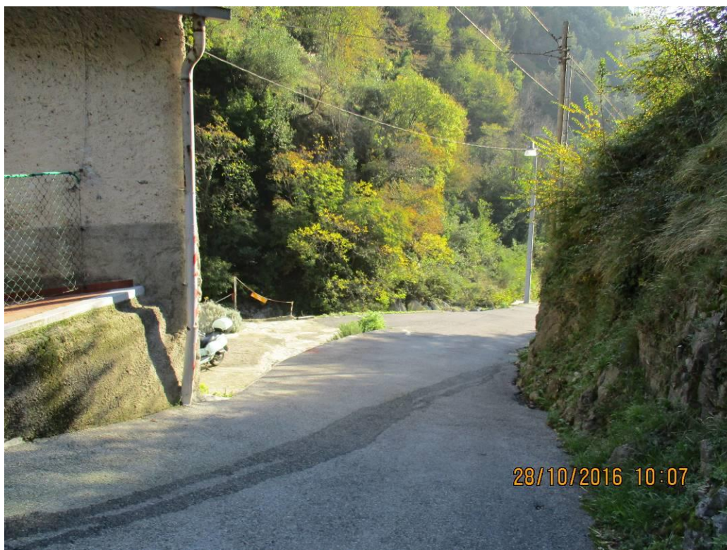
Figura 10: Via Gneo, vista da monte verso valle.
