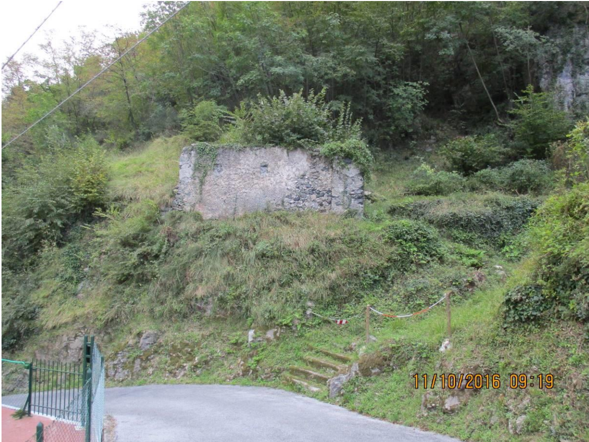
Figura 12: Porzione di versante in corrispondenza dell'antica fornace. Si nota la totale mancanza di opere di regimazione
