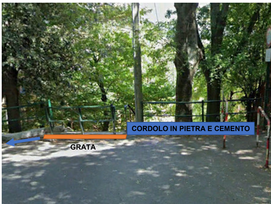
Figura 5: Inquadramento generale a monte scala di collegamento via San Pantaleo-Via Carso
