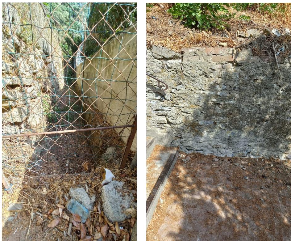
Figura 7: A sinistra dettaglio intercapedine, a destra muro fronte pozzetto
