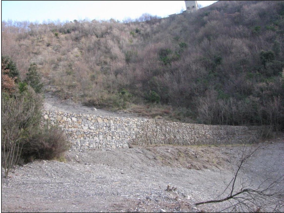
Figura 62 La briglia superiore realizzata in gabbioni in pietrame recentemente ripristinata dalla Società Italcementi
