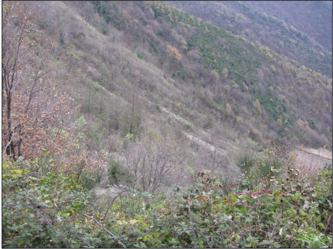
Figura 12 la scarpata sottostante la cava è costituita da un accumuli di materiale detritico di cava: si nota la presenza di vegetazione più giovane e la forte pendenza.
