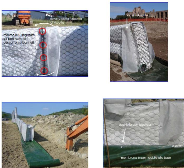
Figura 25: esempio di fasi di posa in opera del sistema a pannelli drenanti
