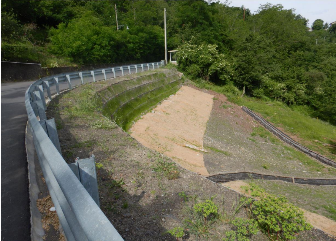
Figura 7: esempio di intervento con terre rinforzate eseguito dalla Direzione Idrogeologia e Geotecnica, Espropri e Vallate del Comune di Genova
