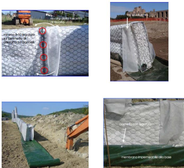
Figura 18: esempio di fasi di posa in opera del sistema a pannelli drenanti
