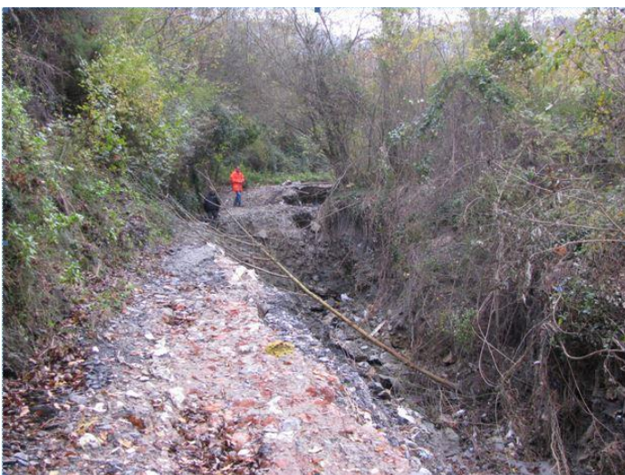
Figura 17: il tratto mediano della pista sterrata che risale la valletta interessata da solchi di erosione superficiale
