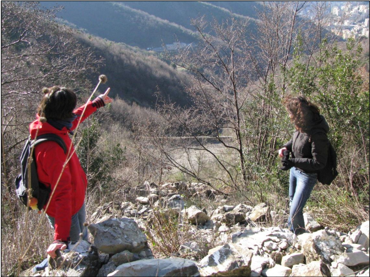
Figura 64 Zona precedente vista dall'alto verso il fondovalle: si notano i blocchi lapidei instabili
