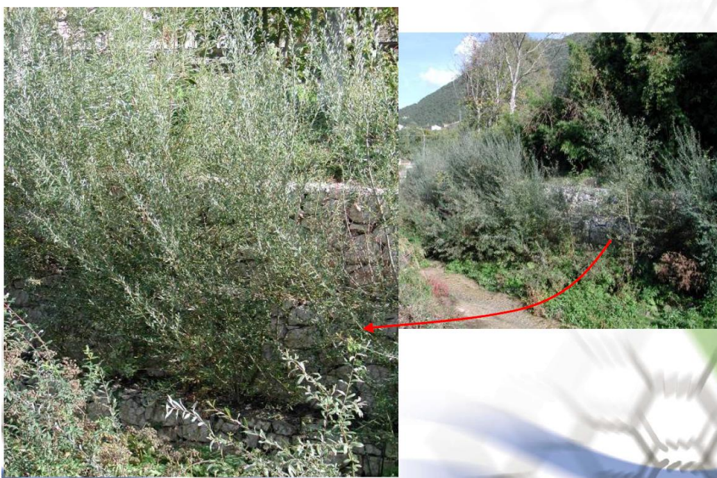
Figura 27: esempio di gabbioni rinverditi
