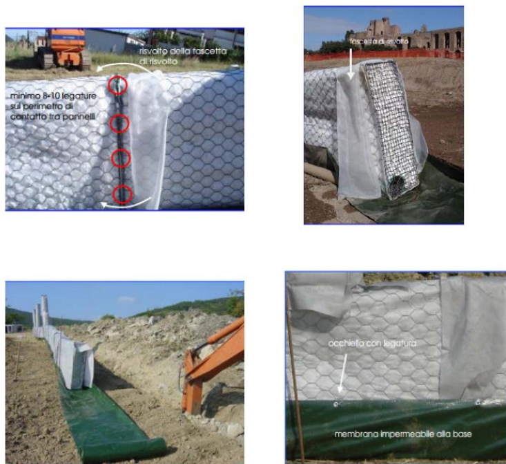
Figura 7: esempio di fasi di posa in opera del sistema a pannelli drenanti
