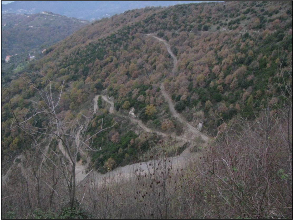
Figura 4: la pista sterrata di servizio della Italcementi spa che dalla cava Forte Ratti scende alle briglie sul versante destro del Fosso del Coniglio
