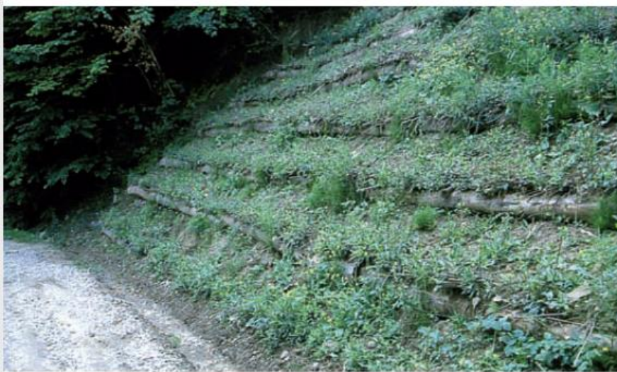
Figura 31: aspetto della grata viva una volta iniziato il rinverdimento
