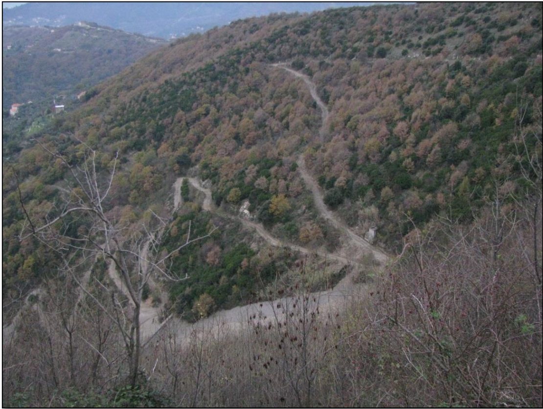
Figura 53: la pista sterrata di servizio della Italcementi spa che dalla cava Forte Ratti scende alle briglie sul versante destro del Fosso del Coniglio
