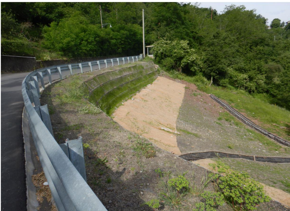
Figura 14: esempio di intervento con terre rinforzate eseguito dalla Direzione Idrogeologia e Geotecnica, Espropri e Vallate del Comune di Genova
