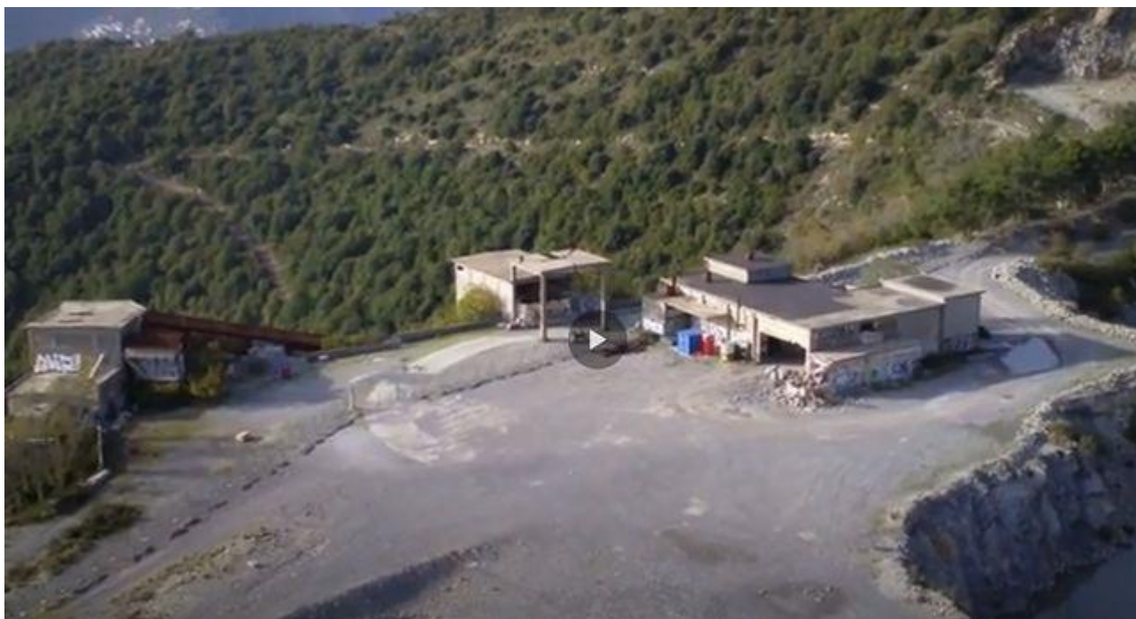
Figura 17: edifici da demolire
