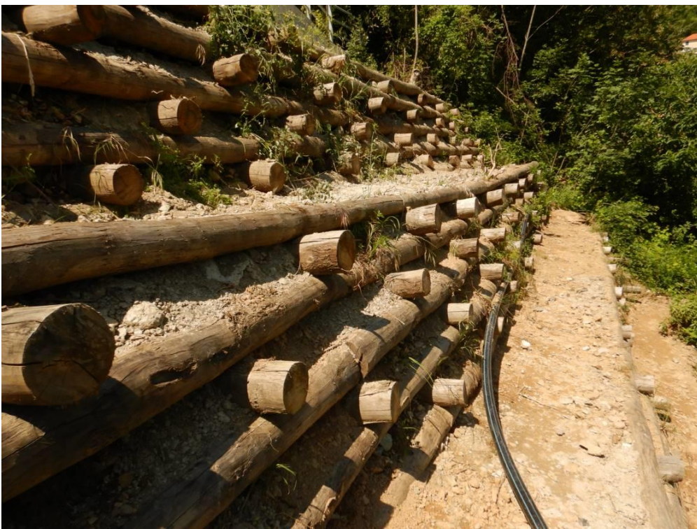
Figura 24: alcune immagini relative alla realizzazione di un apalificata viva a doppia parete realizzata dalla Direzione Idrogeologia e Geotecnica, Espropri e Vallate del Comune di Genova
