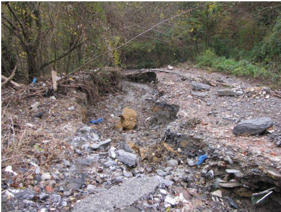
Figura 10: il tratto mediano della pista sterrata che risale la valletta interessata da solchi di erosione superficiale
