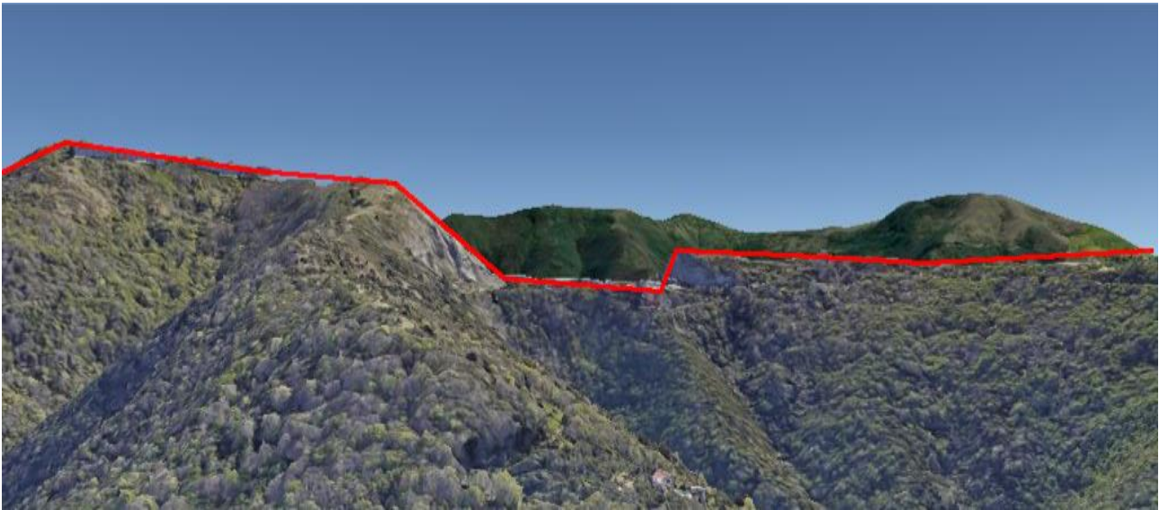
Figura 8: il taglio del crinale in corrispondenza della cava Monte Ratti
