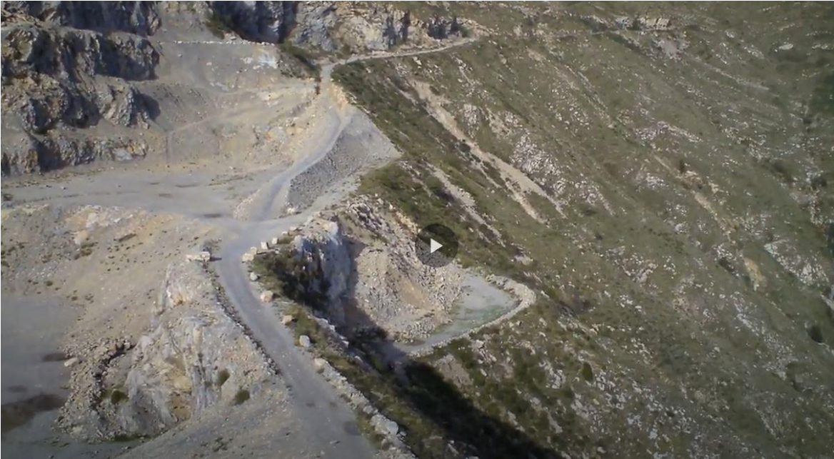
Figura 81: il versante in sponda destra dell'alto bacino del Rio Nasche con fenomeni di erosione diffusa
