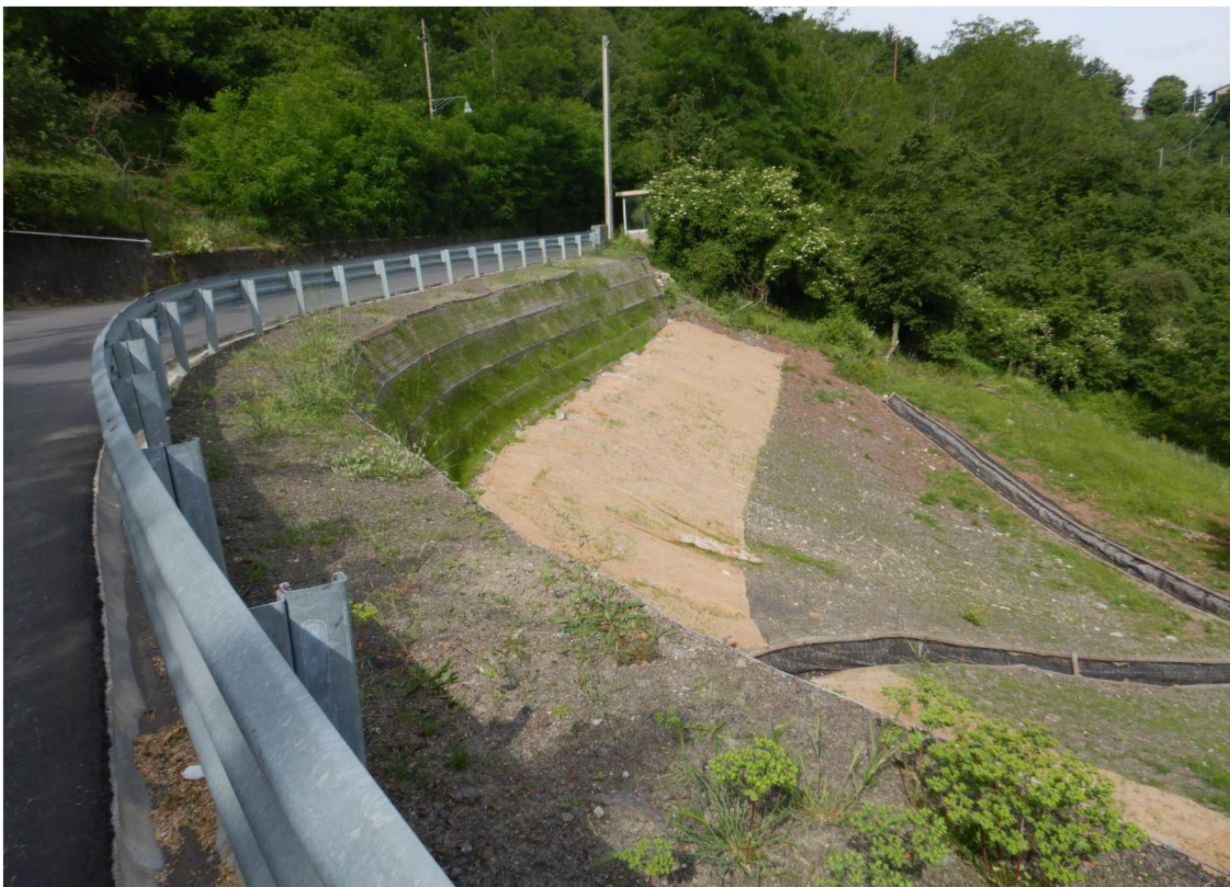
Figura 22: esempio di intervento con terre rinforzate eseguito dalla Direzione Idrogeologia e Geotecnica, Espropri e Vallate del Comune di Genova
