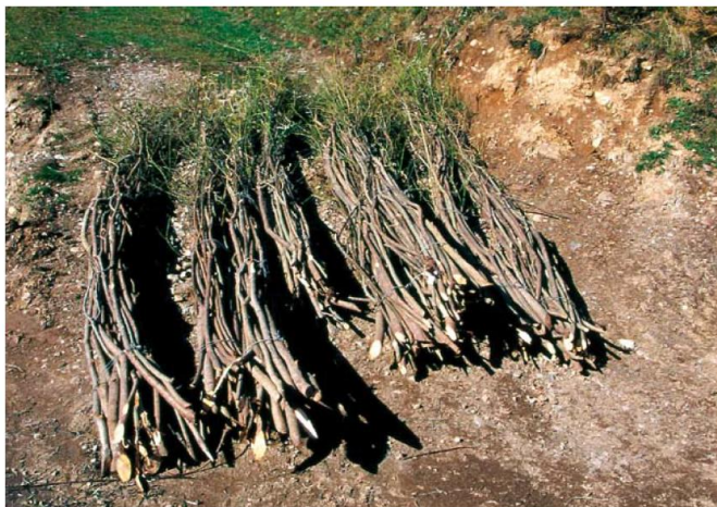
Figura 10: gruppo di fascine preparate e pronte per la messa in opera
