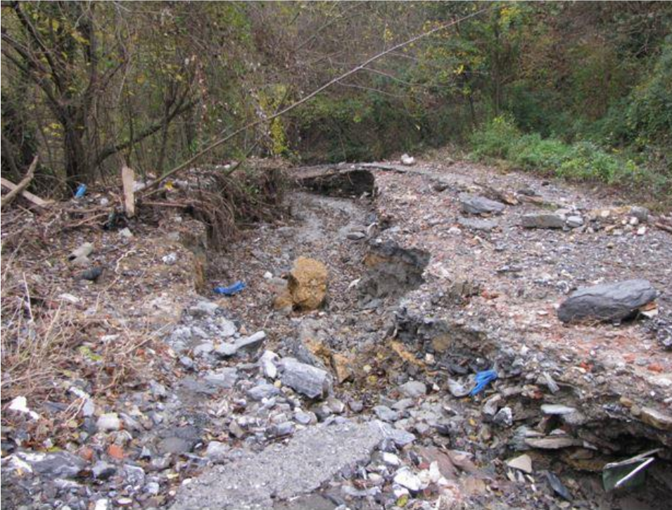
Figura 17: il tratto mediano della pista sterrata che risale la valletta interessata da solchi di erosione superficiale
