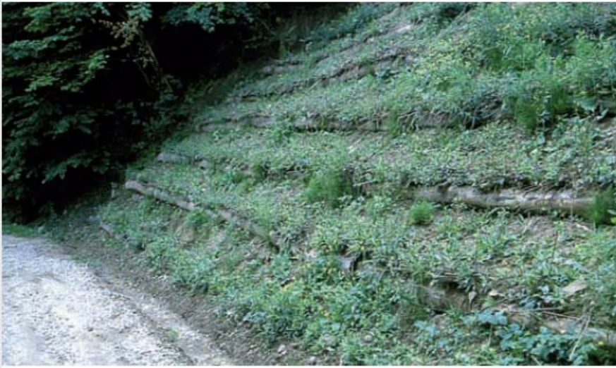
Figura 74: aspetto della grata viva una volta iniziato il rinverdimento
