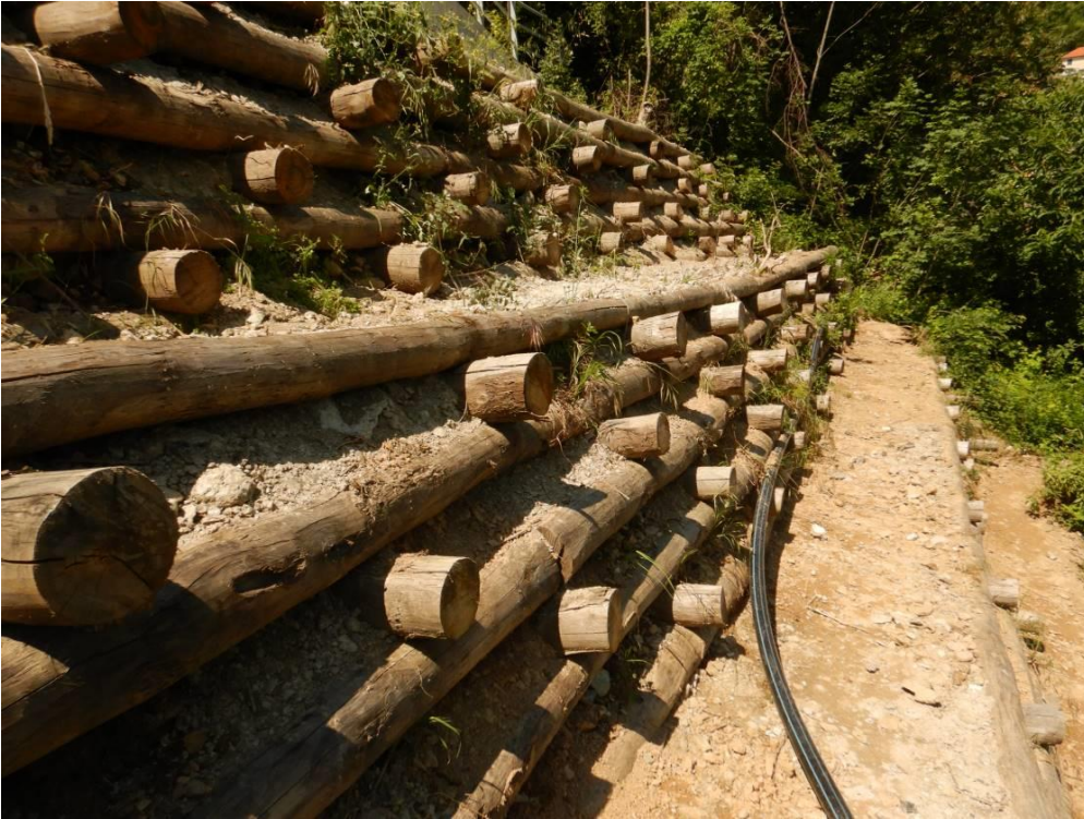
Figura 31: alcune immagini relative alla realizzazione di un apalificata viva a doppia parete realizzata dalla Direzione Idrogeologia e Geotecnica, Espropri e Vallate del Comune di Genova
