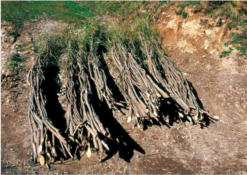
Figura 77: gruppo di fascine preparate e pronte per la messa in opera
