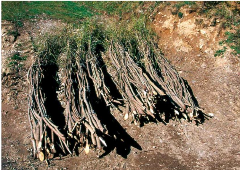
Figura 34: gruppo di fascine preparate e pronte per la messa in opera
