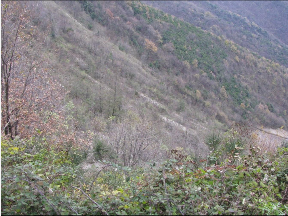
Figura 61 la scarpata sottostante la cava è costituita da un accumuli di materiale detritico di cava: si nota la presenza di vegetazione più giovane e la forte pendenza.
