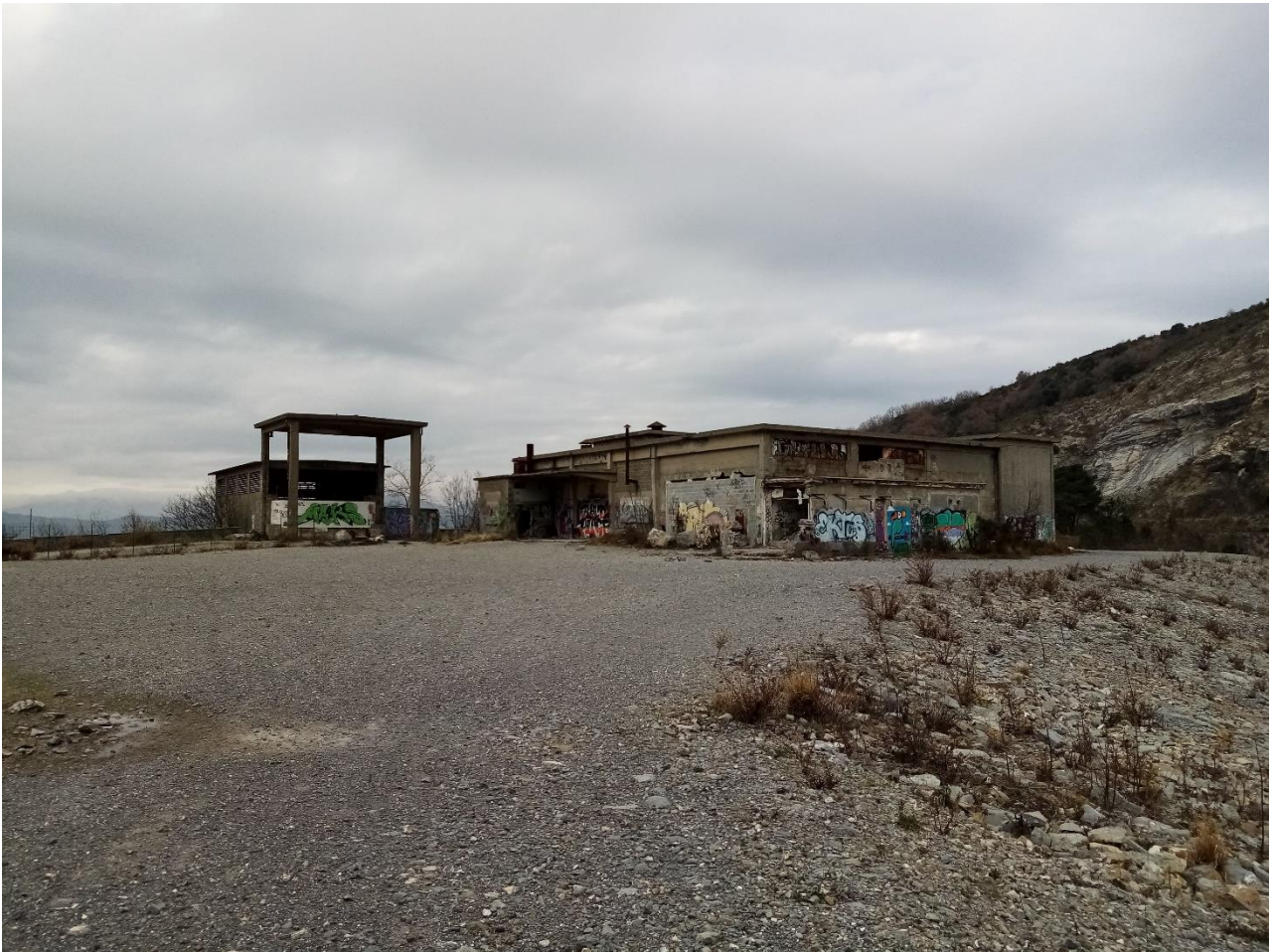
Edifici attività di cava in disuso
