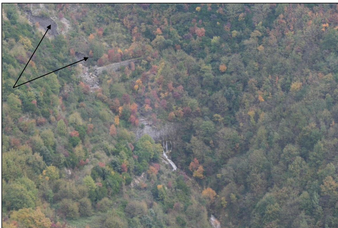
Figura 9 Foto scattate in volo di ricognizione dopo l'evento alluvionale del novembre 2011. Dettaglio dell'evento franoso che ha causato il crollo parziale della briglia di monte lungo l'asta Fosso del Coniglio. A monte della briglia si notano i profondi solchi erosivi (frecce) causati dall'erosione di fondo e laterale delle acque di piena.
