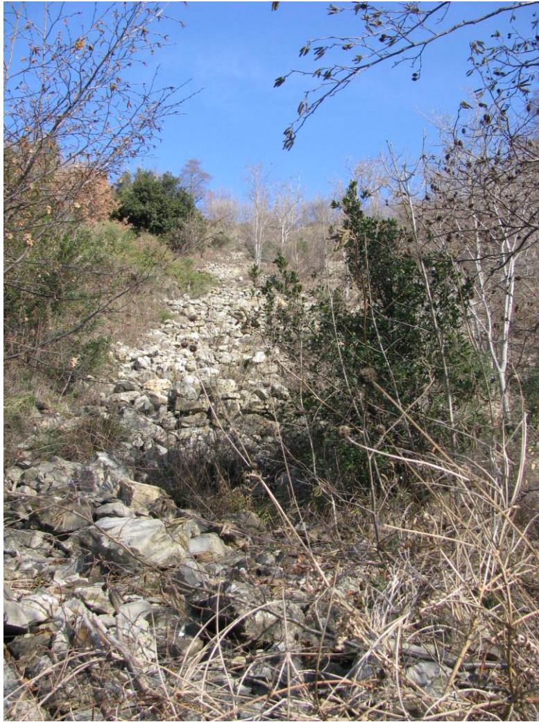
Figura 14 A monte della briglia superiore in gabbioni, anticamente erano state realizzate delle briglie in pietrame a salire verso la cava; nel tempo queste sono in gran parte collassate e attualmente costituiscono accumuli instabili che, in occasione di precipitazioni considerevoli, sono mobilizzati e danno luogo a frane in roccia.
