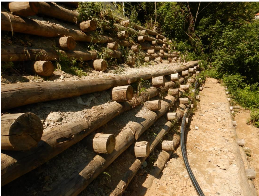
Figura 29: alcune immagini relative alla realizzazione di una palificata viva a doppia parete realizzata dalla Direzione Idrogeologia e Geotecnica, Espropri e Vallate del Comune di Genova
