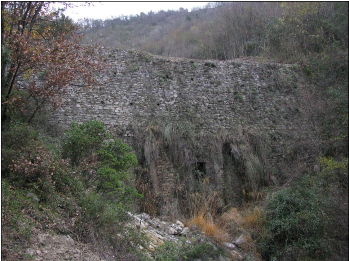
Figura 69 Il paramento della diga intermedia visto dal basso
