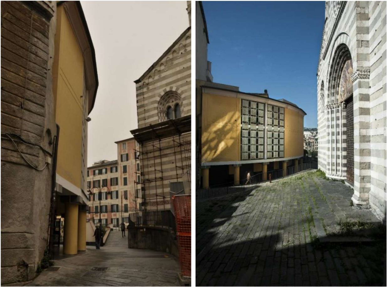
Figura 4 – Foto dello stato di fatto, esterni
