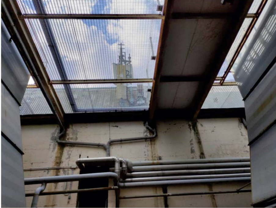
Punto di passaggio ipotizzato per trasporto macchine al piano 17, previa rimozione di grigliato metallico
