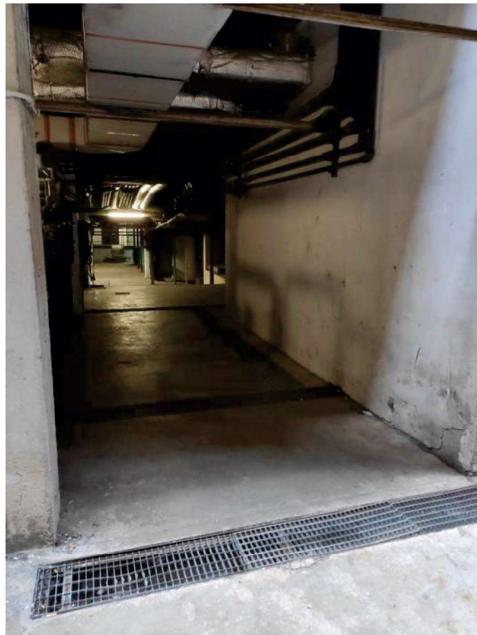
Accesso pedonale al piano -4 per installazione Unità di trattamento aria a servizio della sala regia
