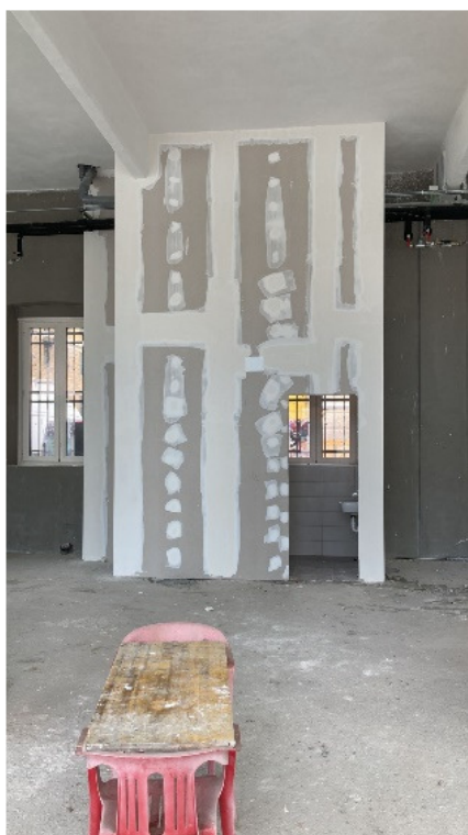
Figura 2: il servizio realizzato all'interno dell'unità 6 braccio nord
