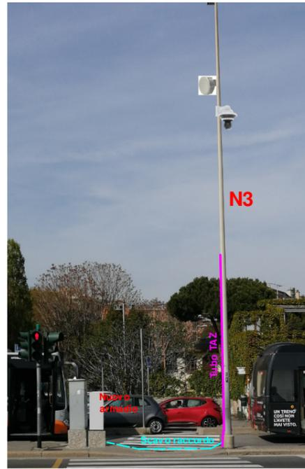
Percorso cavi interni a cavidotto interrato esistente con eventuale scavi e tubo di raccordo da pozzetti a palo e da pozzetti ad armadio
