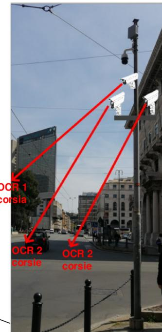
Telecamere da fissare sul palo della videosorveglianza esistente con staffa a sbalzo di 50cm per lato per le due telecamere da 5Mpx. Cablaggio da realizzare interno al palo e in cavidotto esistente fino all'armadio apparati videosorveglianza esistente.
