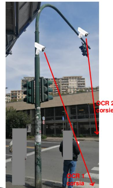
Telecamere da fissare su palo semaforo. Cablaggio interno al cavidotto semaforico proveniente dal lato opposto della strada
