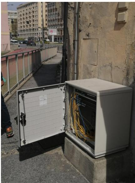
Foto quadro fibra ottica e punto installazione nuovo armadio
