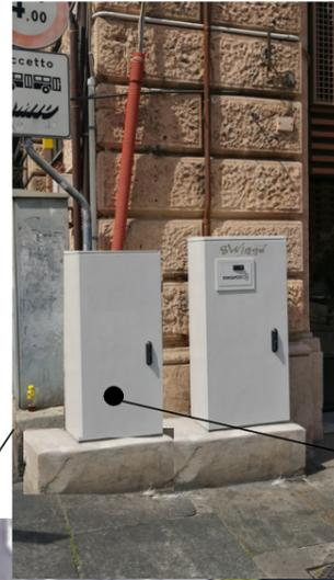
Nuovo armadio apparati da installare su nuovo basamento. Corrente elettrica da armadio semaforico esistente. Fibra ottica a carico del committente.
