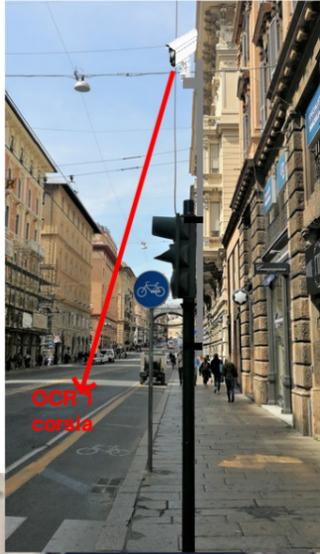
Telecamere da fissare sul palo semaforo con prolunga installata con staffe palo-palo. Prolunga da verniciare colore verde come palo esistente. Cablaggio da realizzare interno al cavidotto semaforico proveniente dal cunicolo sottostrada fino all'armadio da installare all'angolo via XXSettembre / via Fiume
