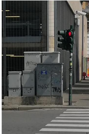
Zona armadi esistenti da sfruttare per posa apparati. Transito cavi in condutture semaforiche esistenti
