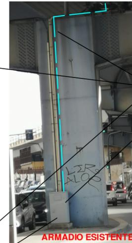
Percorso cavi in tubo armato nel tratto verticale e in tubo protettivo diflex in tutto il tratto orizzontale fino alla telecamera
