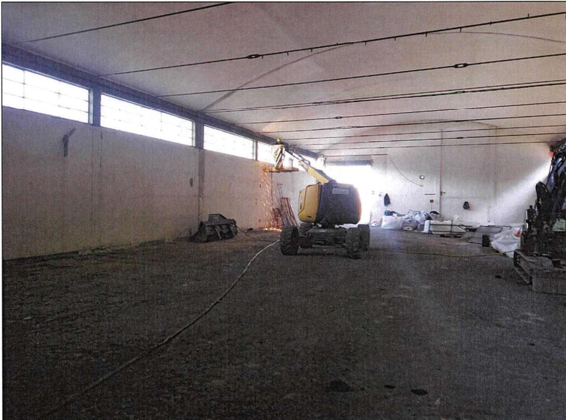
**Foto 06.B – Rimozione del telaio metallico dei serramenti all'interno del Padiglione M**
