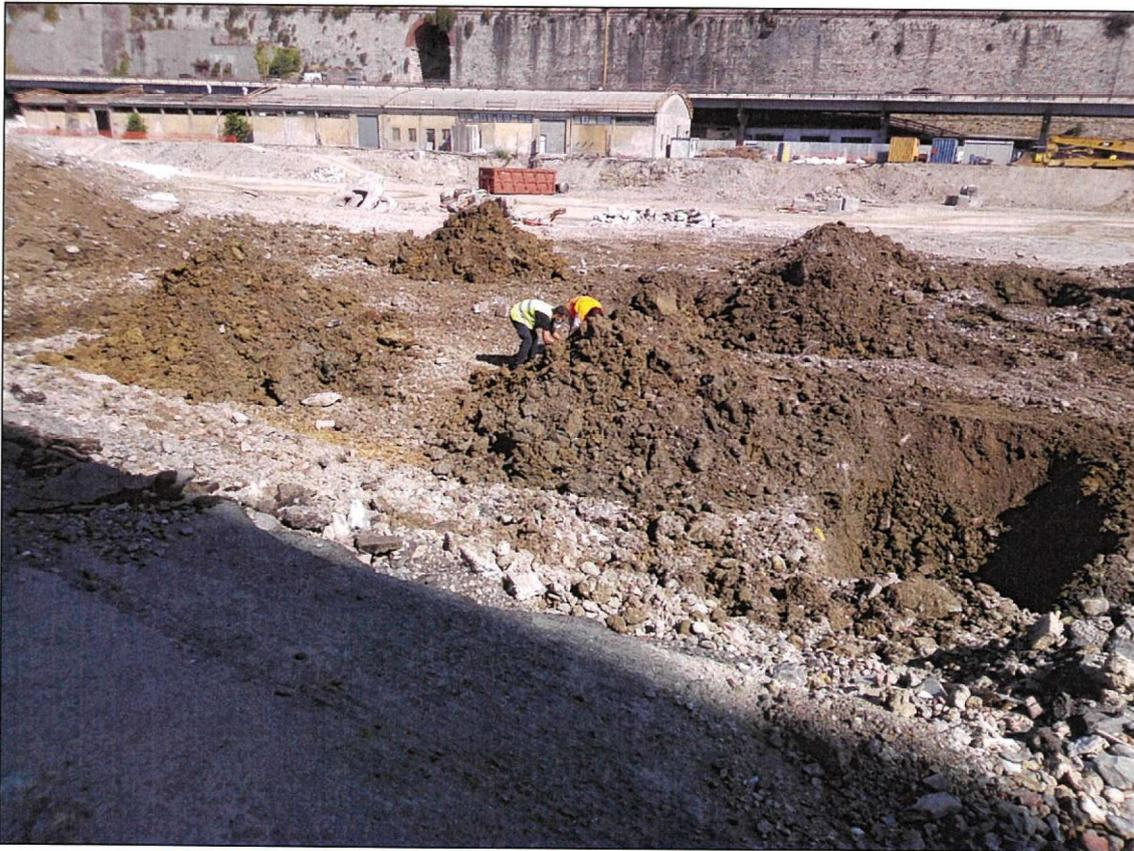
**Foto 08.B – Prelievo campioni di materiale di scavo per esecuzione delle analisi in laboratorio**
