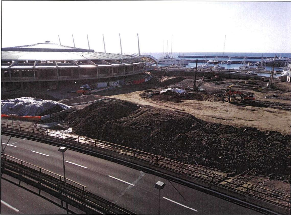
Foto 05 – Operazioni di scavo a sistemazione area per successiva realizzazione del “canaletto”
