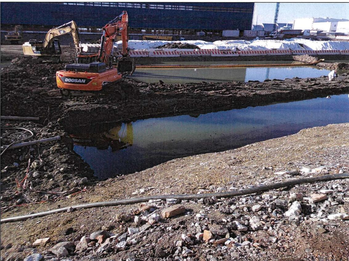
Foto 16 – Operazioni di bonifica dagli idrocarburi dell'”hot spot” (porzione di ponente)
