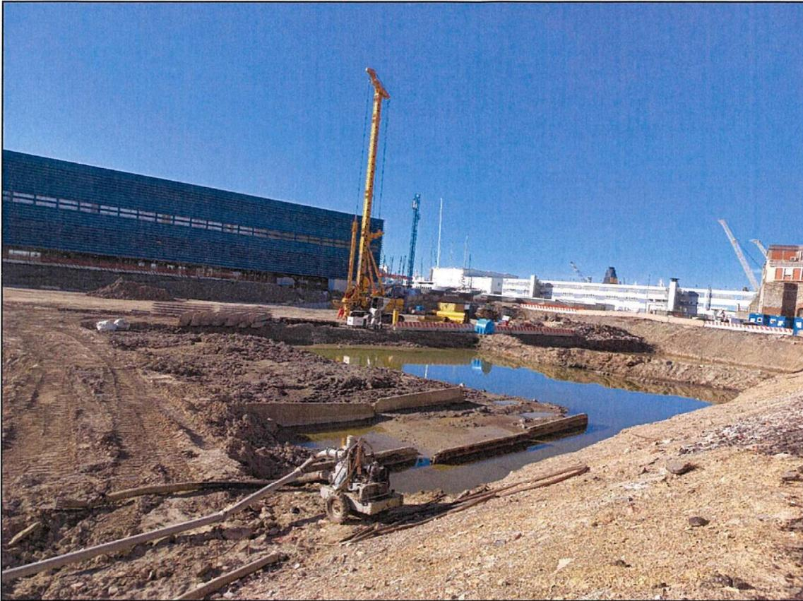
Foto 15 - Operazioni di bonifica dagli idrocarburi dell'“hot spot” (porzione di ponte)
