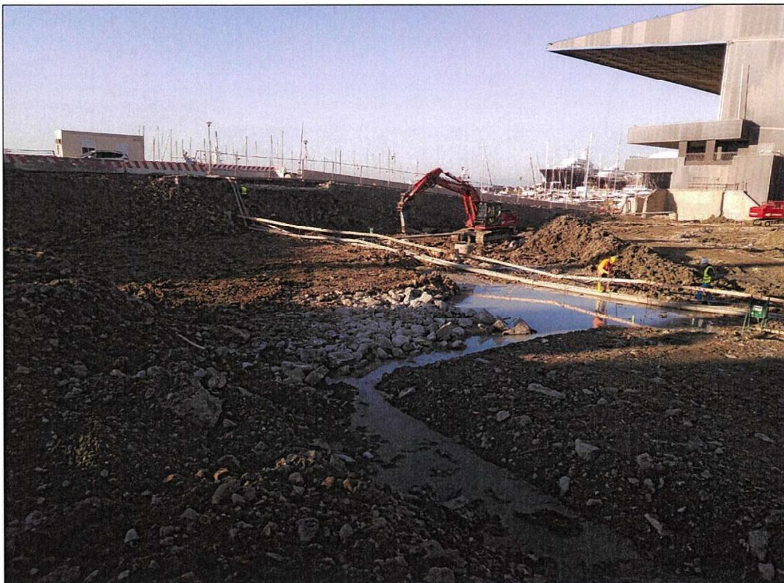
Foto 08 – Operazioni di scavo a sistemazione area per successiva realizzazione del “canaletto”
