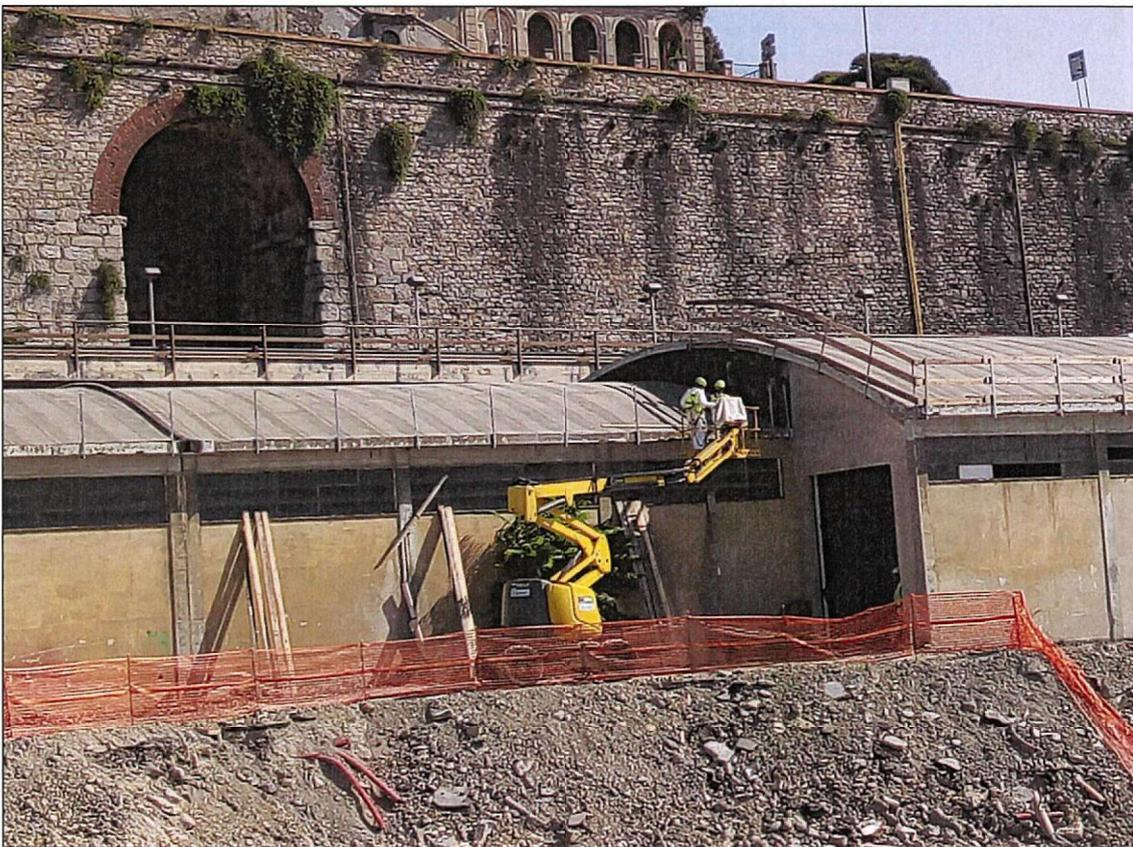
**Foto 08.A – Montaggio parapetto provvisorio sulla copertura del Padiglione M**
