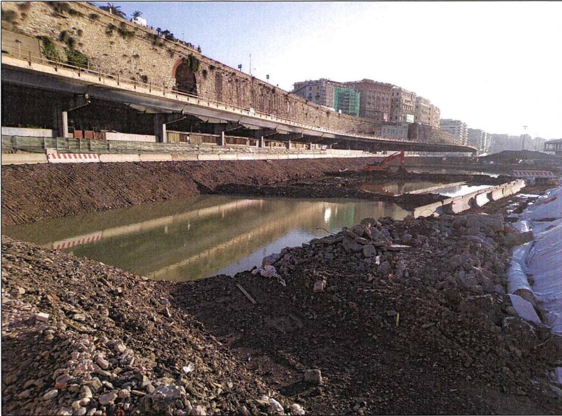
Foto 11 - Operazioni di bonifica dagli idrocarburi dell'hot spot (porzione di ponte)
