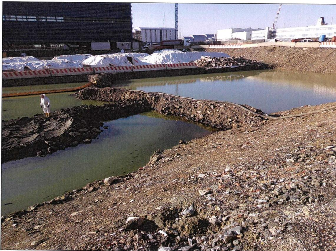
Foto 18 – Operazioni di bonifica dagli idrocarburi dell'”hot spot” (porzione di ponente)
