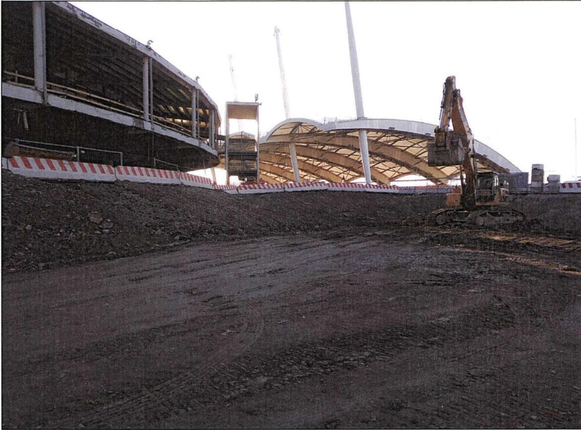
Foto 07 – Operazioni di scavo a sistemazione area per successiva realizzazione del “canaletto”
