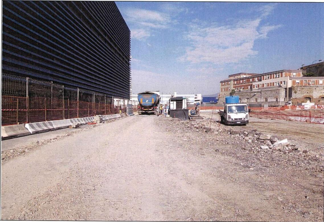
Foto 03.B – Trasporto del materiale terroso su camion con sosta su impianto di pesatura
