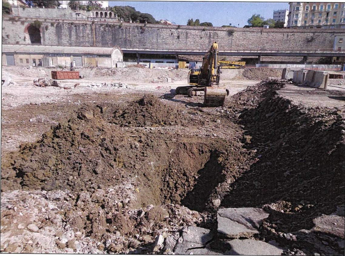
**Foto 07.B – Scavo con pala metallica per campionatura del materiale terroso**
