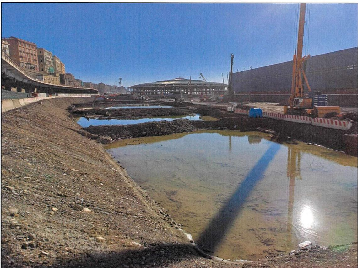
Foto 10 - Operazioni di bonifica dagli idrocarburi dell'”hot spot” (vista verso levante)
