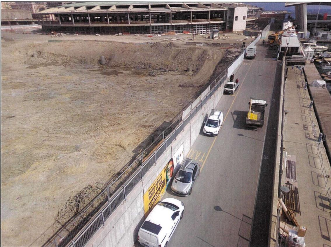
**Foto 14 – Recinzione metallica utilizzata anche per la predisposizione di teli antipolvere**
