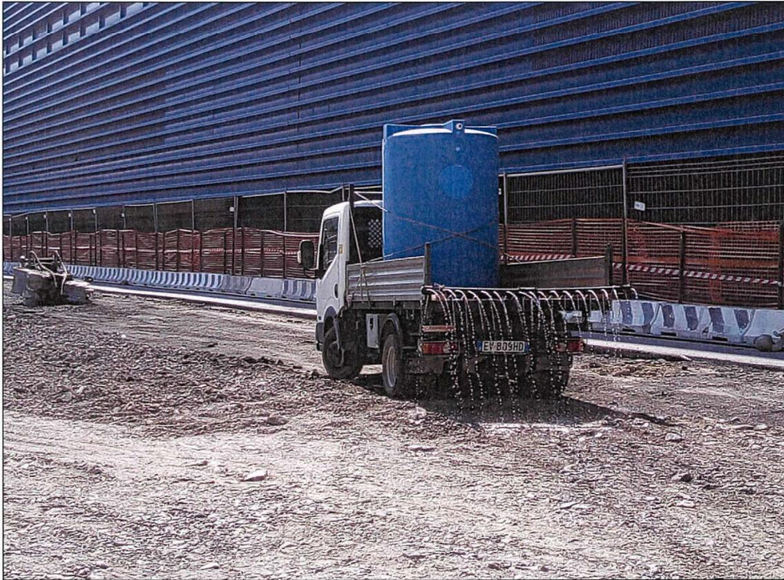
Foto 03.A – Sistema mobile di innaffiamento del materiale terroso installato su autocarro
