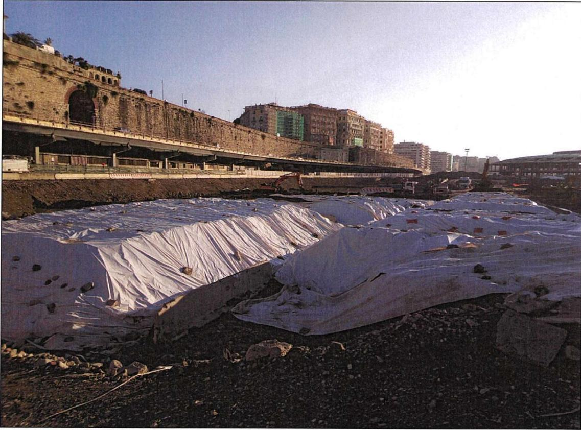
**Foto 09 – Stoccaggio dei cumuli di terreno in attesa dell'esito delle analisi Arpal**
