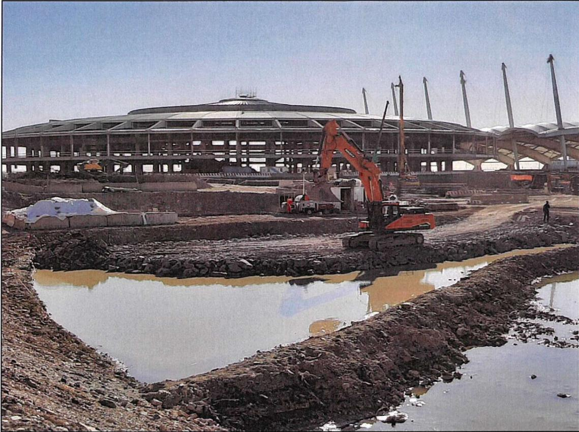
**Foto 11 - Operazioni di bonifica dagli idrocarburi dell'hot spot (porzione di levante)**
