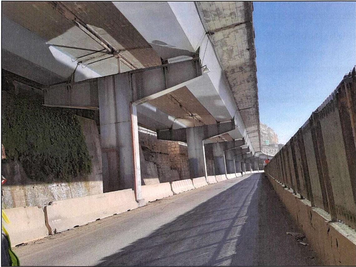
Foto 01 – Barriera tipo “new jersey” tra i piloni della Sopraelevata lungo Via dei Pescatori
