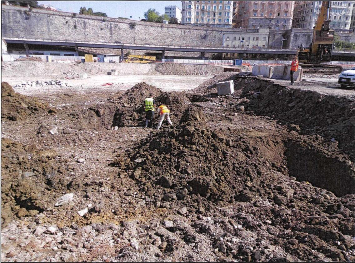
Foto 09.B – Prelievo campioni di materiale di scavo per esecuzione delle analisi in laboratorio
