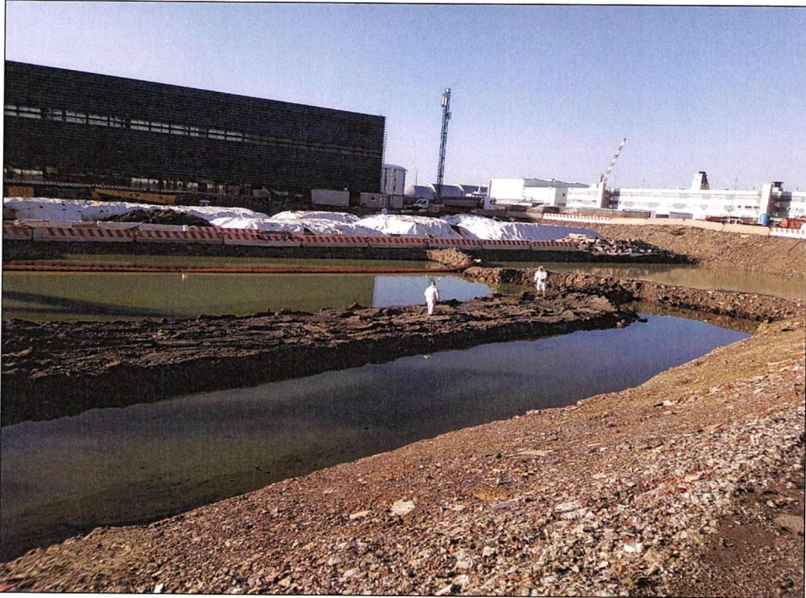
Foto 17 – Operazioni di bonifica dagli idrocarburi dell'”hot spot” (porzione di ponente)
