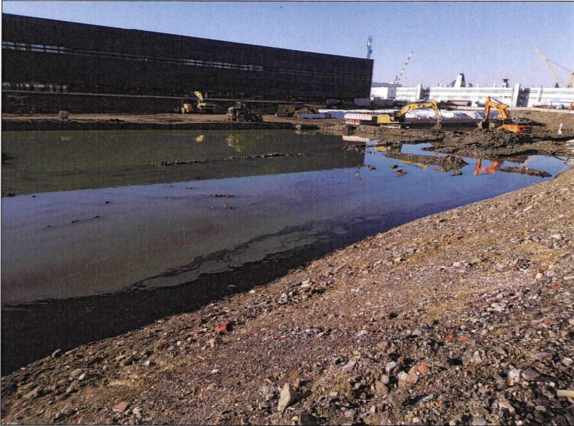
Foto 15 - Operazioni di bonifica dagli idrocarburi dell'”hot spot” (porzione di levante)
