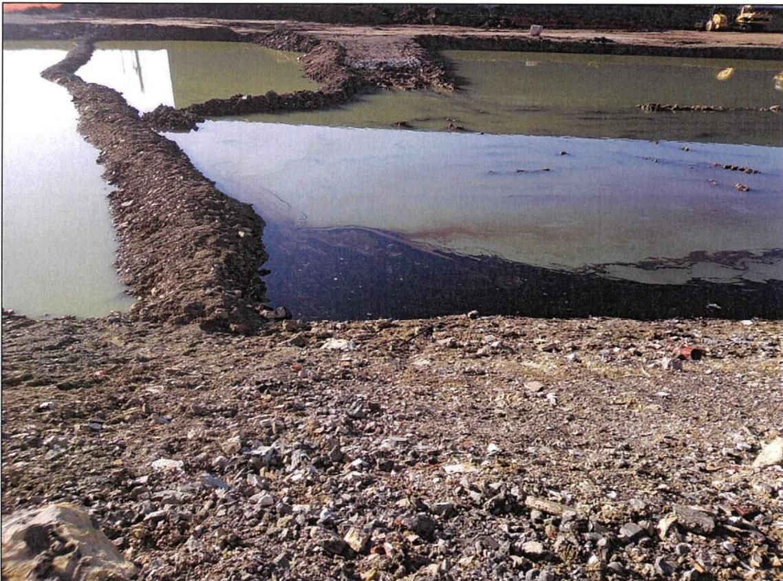
Foto 14 – Operazioni di bonifica dagli idrocarburi dell'”hot spot” (porzione di levante)
