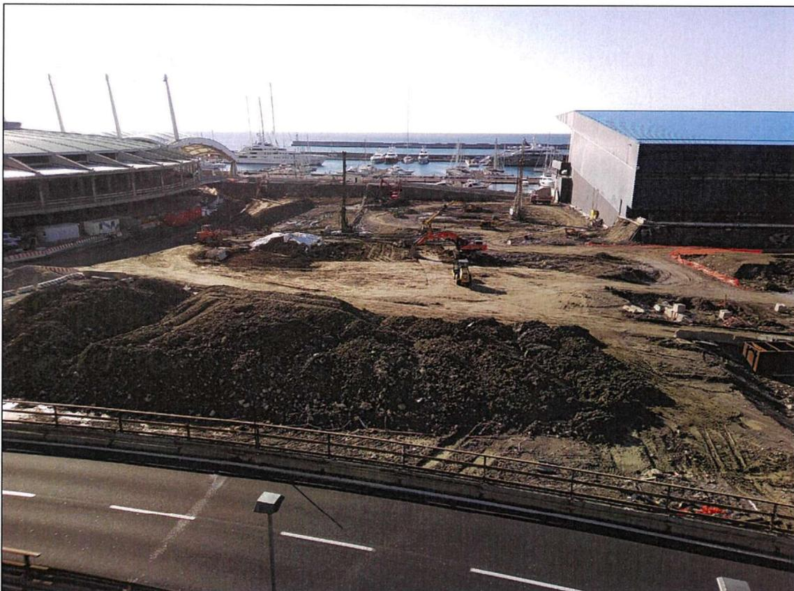
Foto 06 – Operazioni di scavo a sistemazione area per successiva realizzazione del “canaletto”
