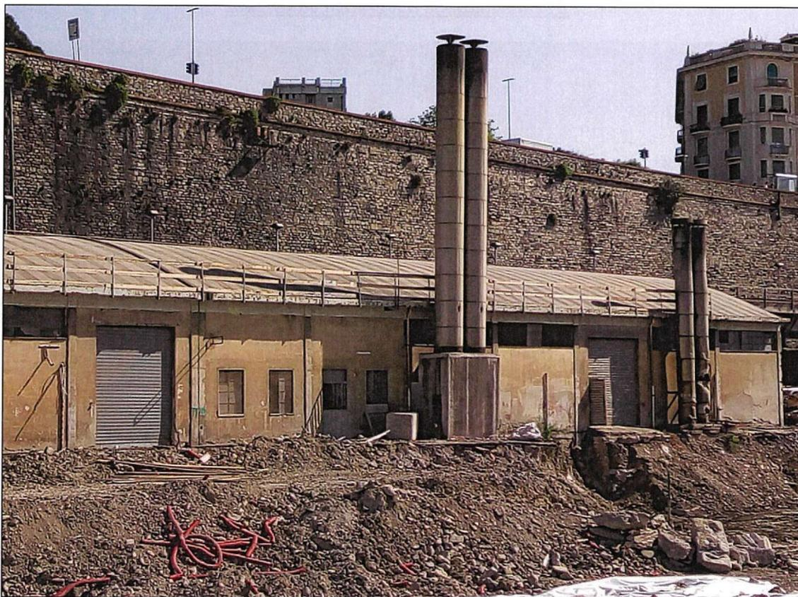
**Foto 09.A - Parapetto provvisorio installato sulla copertura del Padiglione M**
