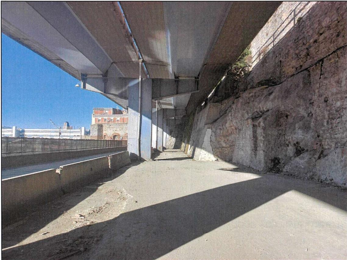
Foto 02 – Barriera tipo “new jersey” tra i piloni della Sopraelevata lungo Via dei Pescatori
