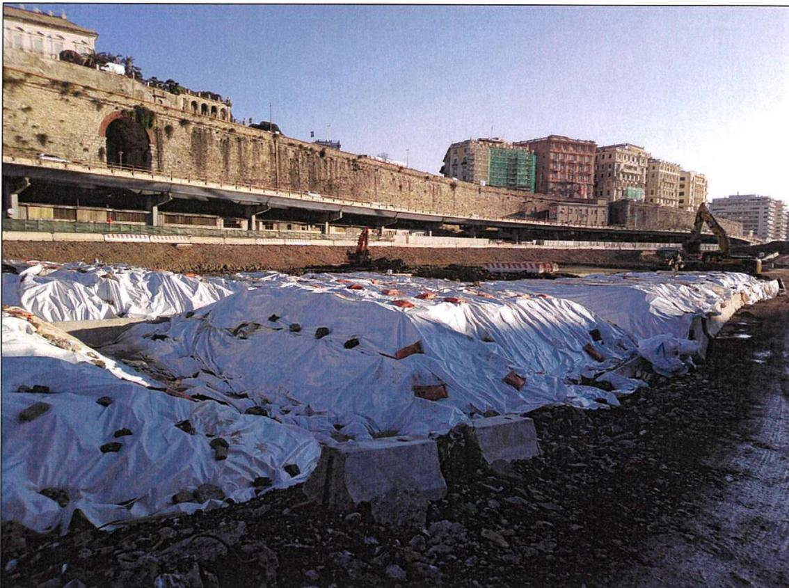
**Foto 10 - Stoccaggio dei cumuli di terreno in attesa dell'esito delle analisi Arpal**
