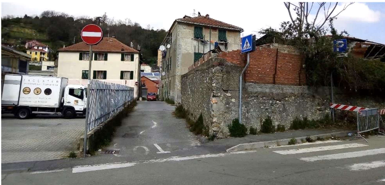
Figura 11 - Vista da via Baracchino (prima della messa in sicurezza da parte della Direzione Facility Management)
