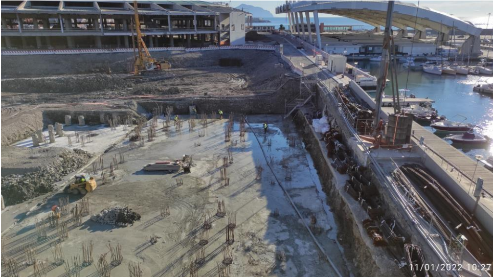
Figure 4 - Condizioni di Cantiere a inizio gennaio 2022.
