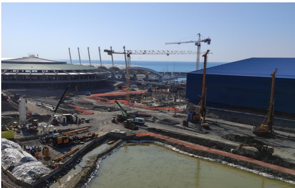
Figure 5 - veduta area cantiere di levante (angolo Canale Principale/Canaletto). si evidenzia la complessa viabilità condivisa tra Appaltatore e Operatori privati in area Canali e il condizionamento causato dalla 2 gru a torre del lotto 2.3 interferenti con l'antenna
