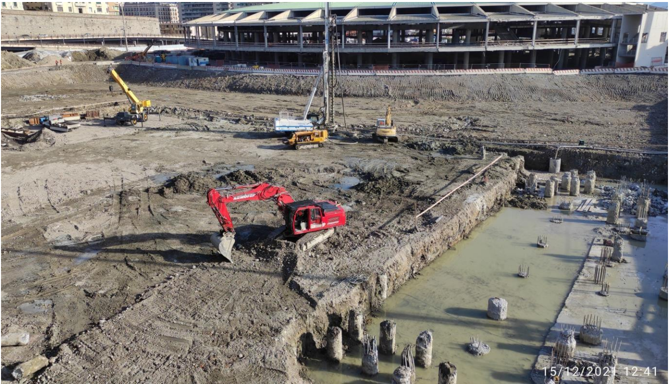
Figure 3 - Cantiere Lotto 2.3 con avanzamento pali di fondazione a perimetro interferenti con tiranti paratia Canaletto
