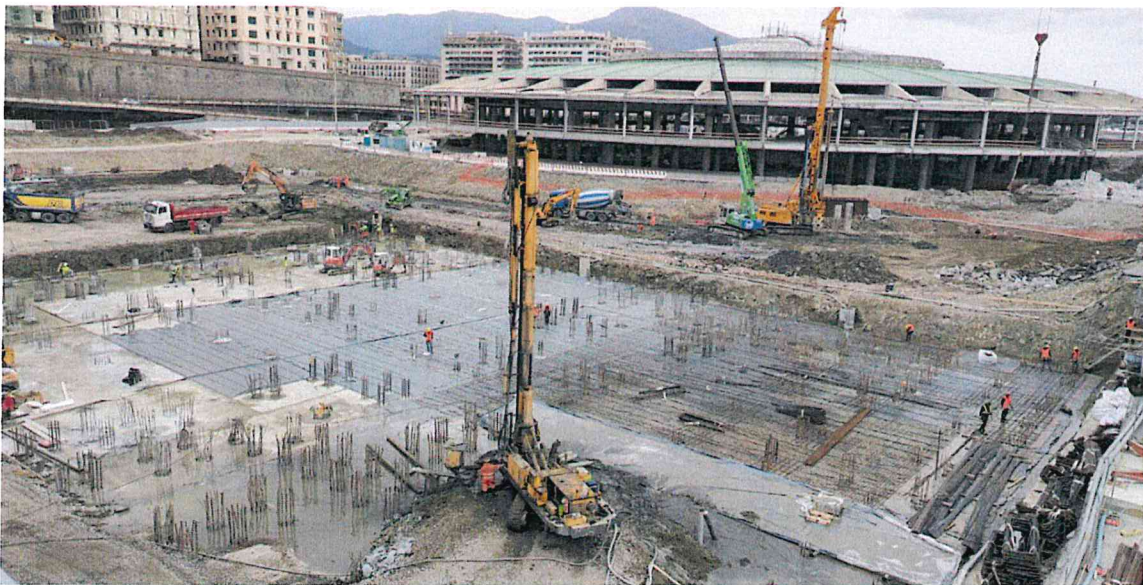
interferenze cantiere lotto 2.3 / canaletto
