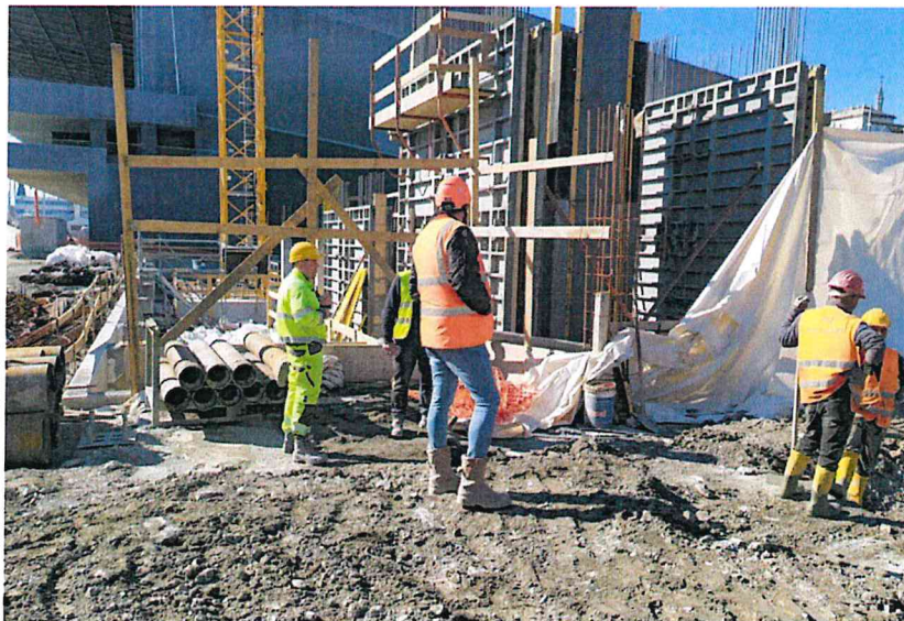
interferenze tra macchina operatrice per esecuzione pali D400 pozzo ponente bypass impianti e cantiere lotto 2.3 (si noti la vicinanza delle strutture in CA elevazione facenti parte il lotto 2.3 con le opere di perforazione eseguite da ICOP per il pozzo impianti ponente)
