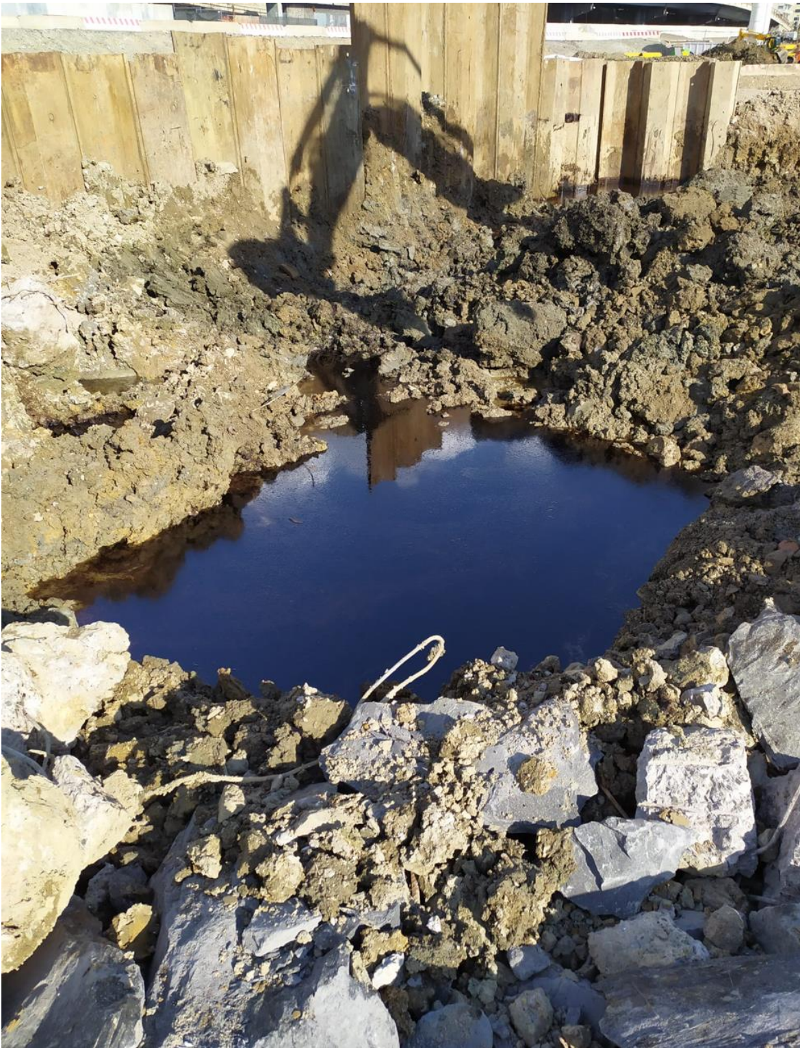
Figura 2 - palancole di delimitazione lotto 2.2a
