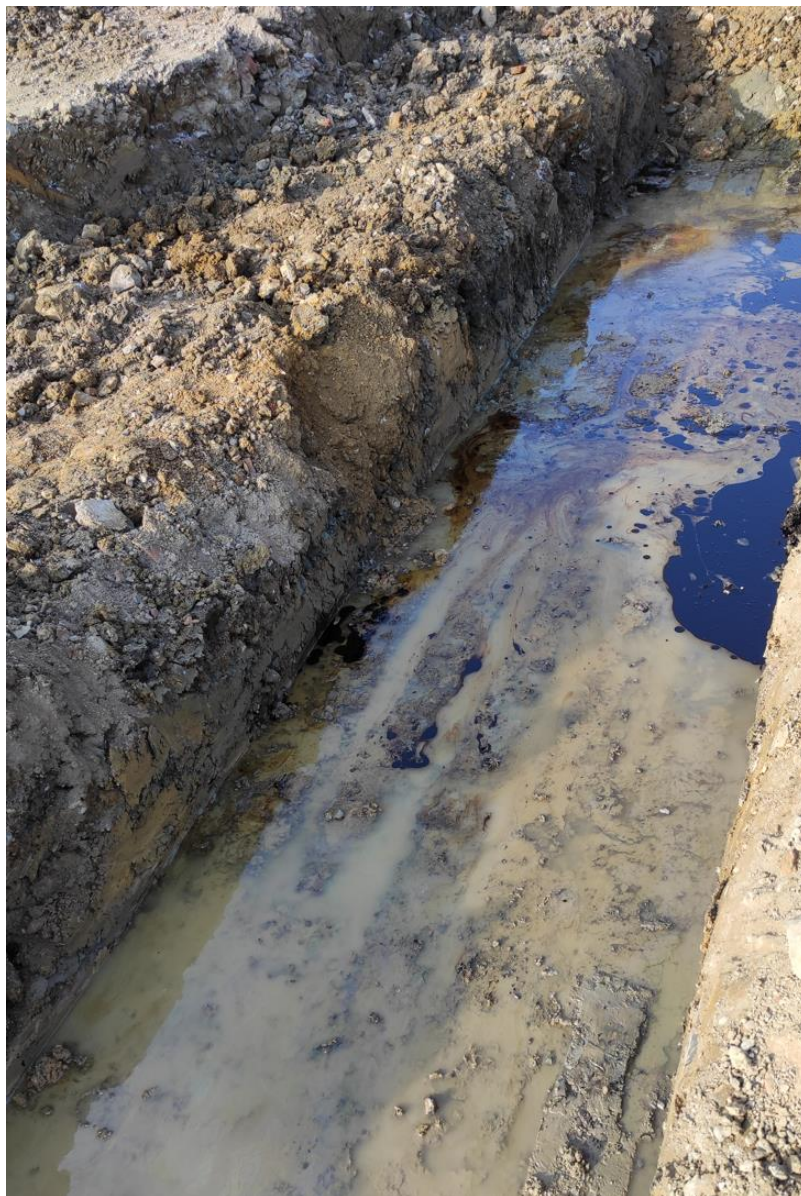
Figura 1 - rinvenimento idrocarburi in corso dello scavo corea guida pali secanti breve tratto paratia nord canale principale
