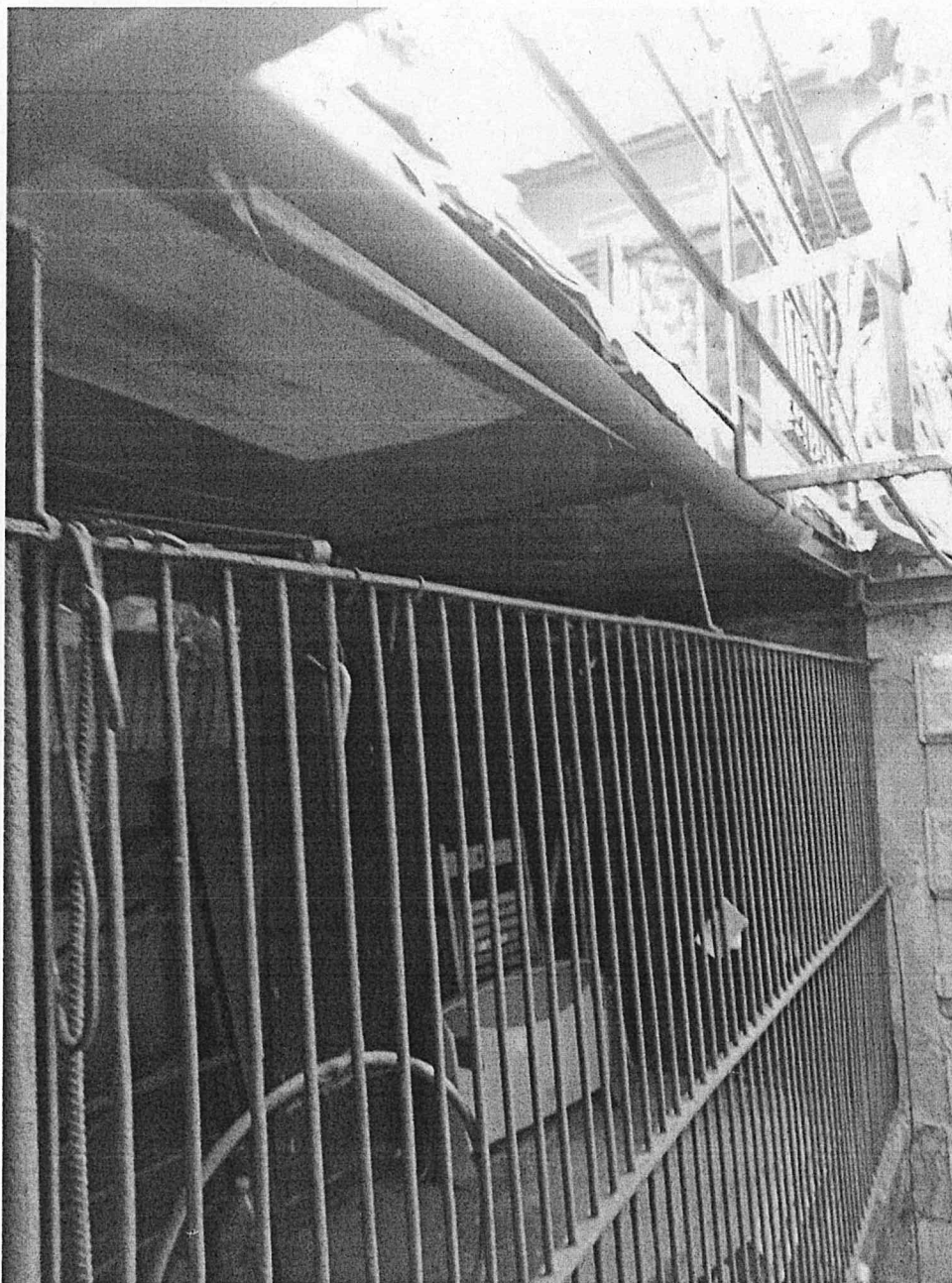
Intradosso solaio di copertura magazzino
