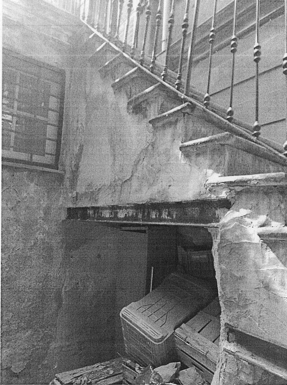
Scala di accesso a piano primo
