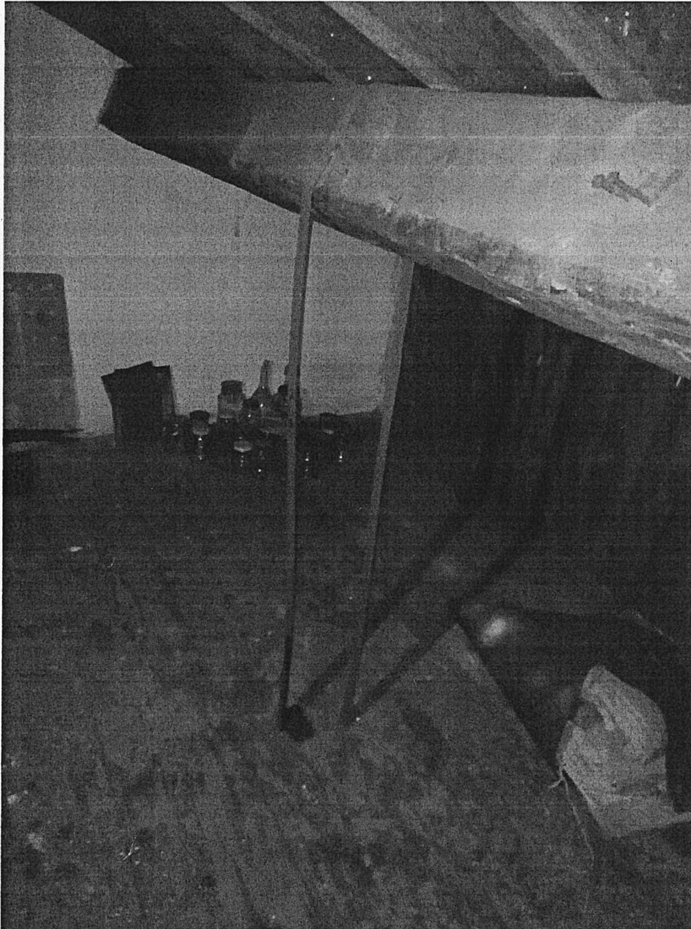
Piano Sottotetto - catena lato ovest
