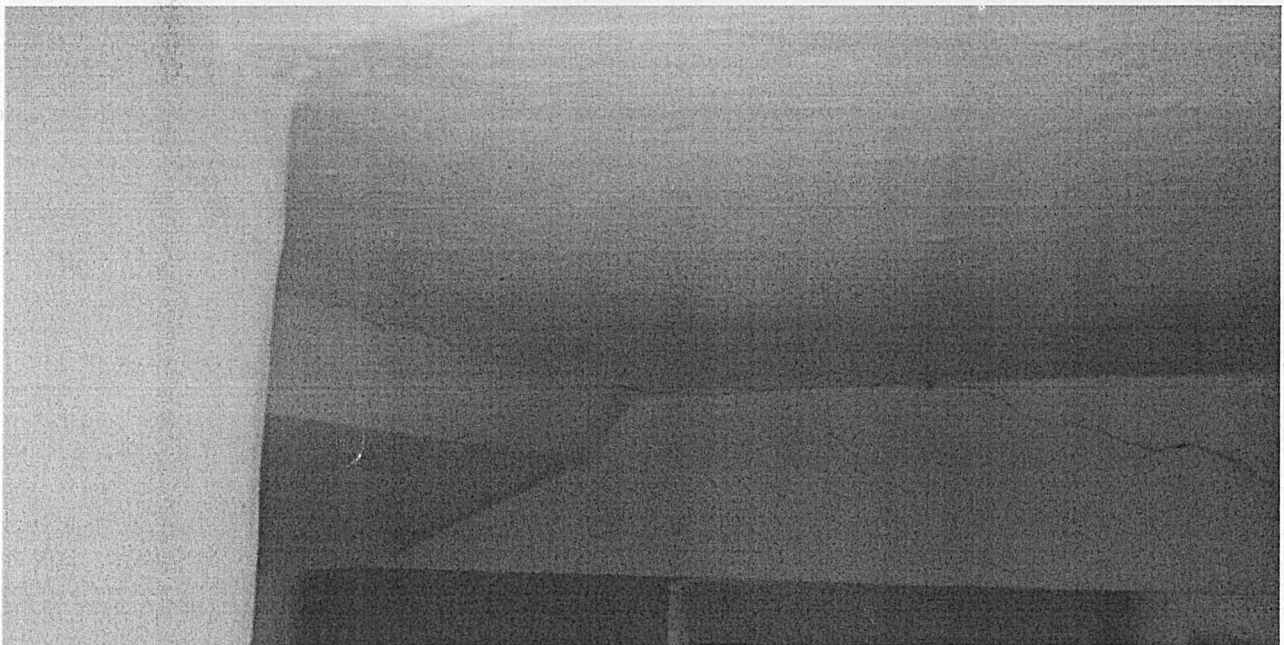
Piano Primo - Lesioni strutturali
