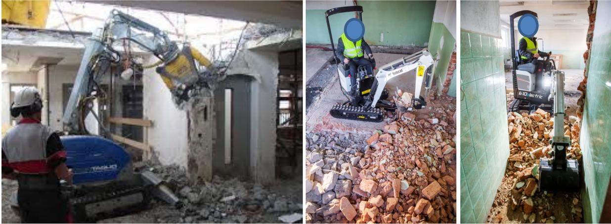
*Esempi di demolizioni interne con macchine operatrici*
