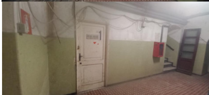
Figura 18 e 19 – Foto Connettivo ingresso principale Piano Terra
