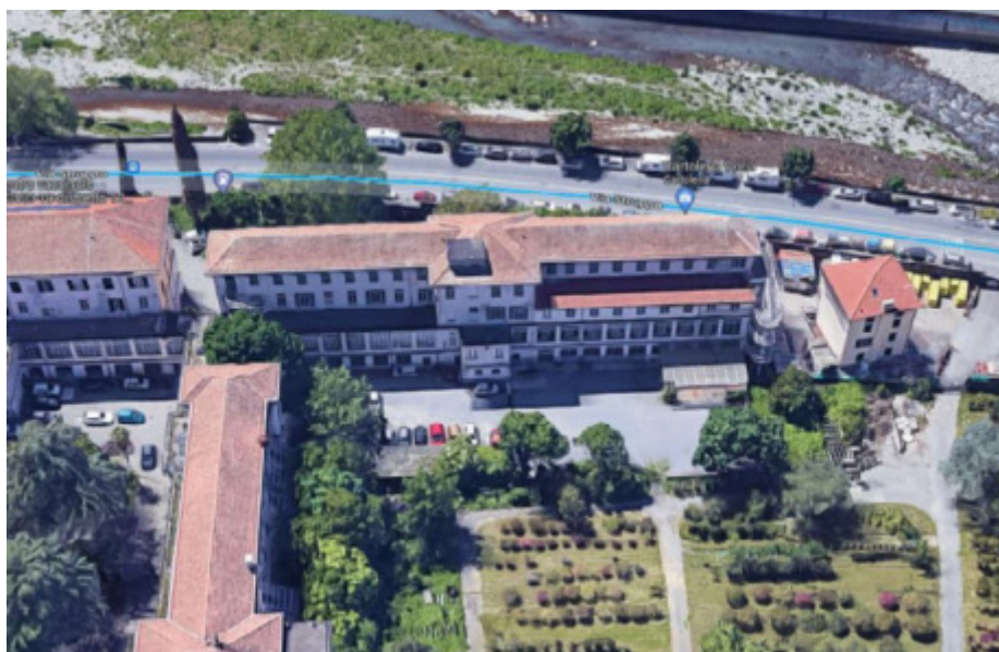
Figura 11 – Veduta aerea prospetto posteriore lato Nord
