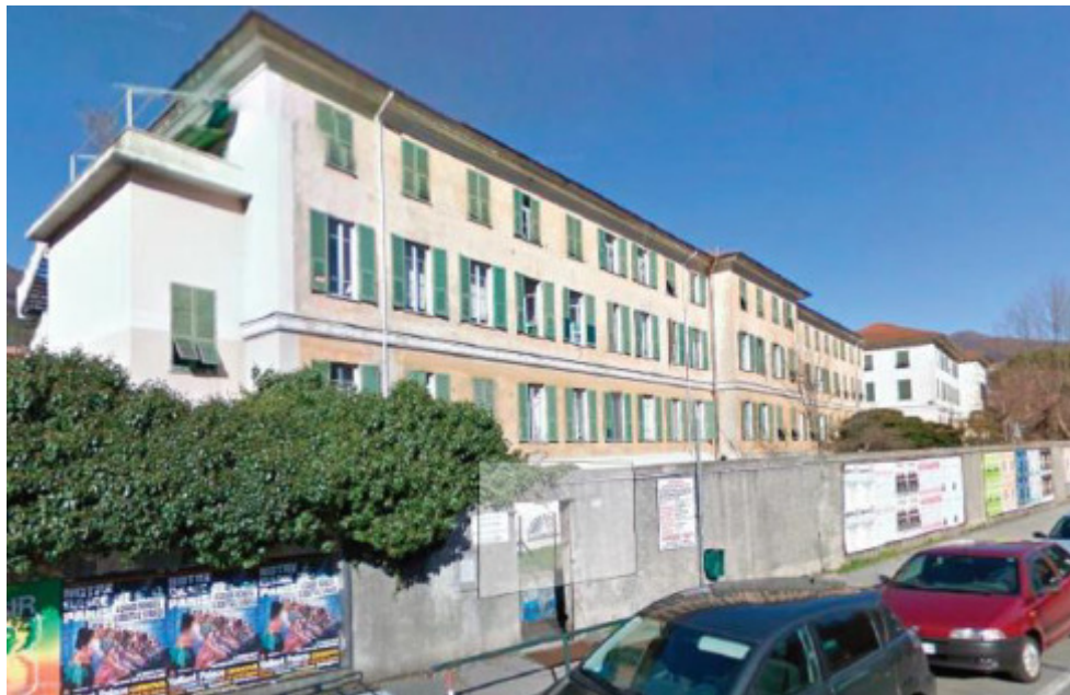
Figura 13 – Veduta prospetto principale su via Struppa ala ovest sede scolastica
