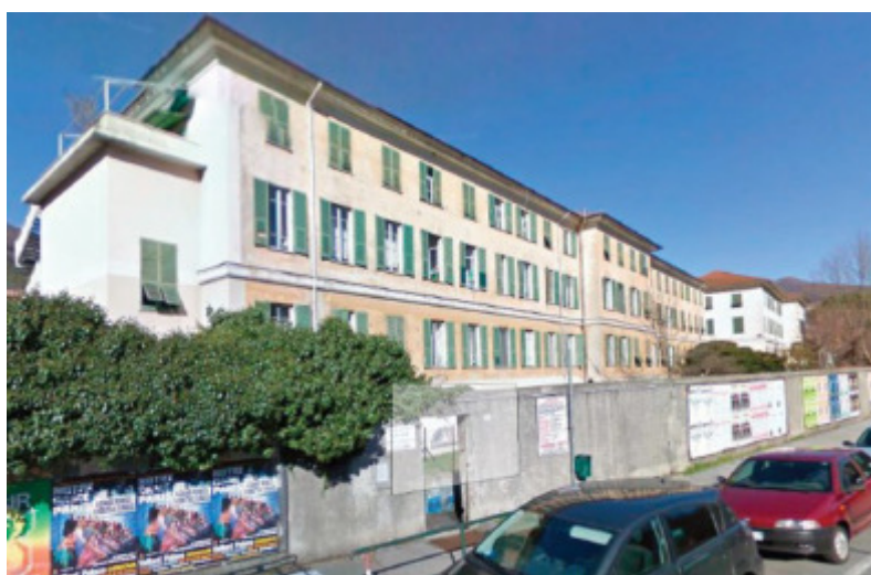
Figura 27 – Veduta prospetto principale su via Struppa ala ovest sede scolastica
