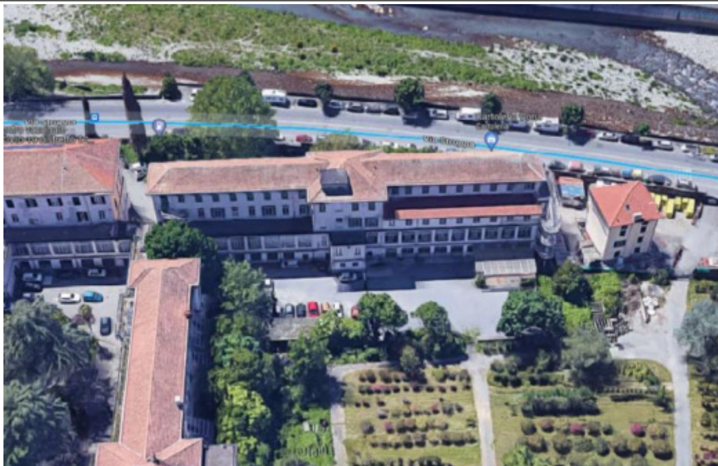
Figura 11 – Veduta aerea prospetto posteriore lato Nord
