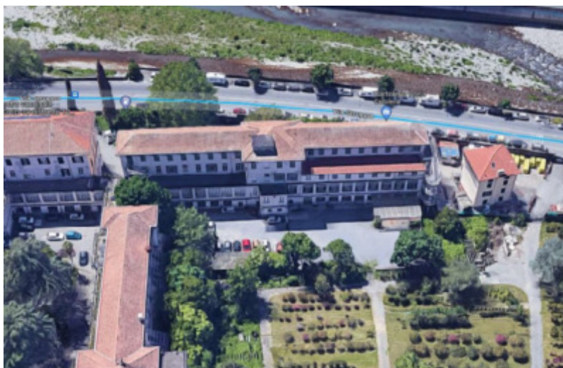
Figura 25 – Veduta aerea prospetto posteriore lato Nord
