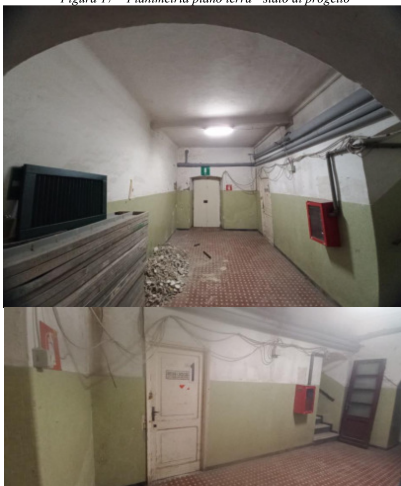
Figura 18 e 19 – Foto Connettivo ingresso principale Piano Terra
