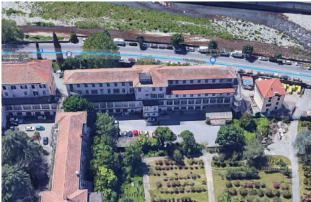
Figura 11 – Veduta aerea prospetto posteriore lato Nord
