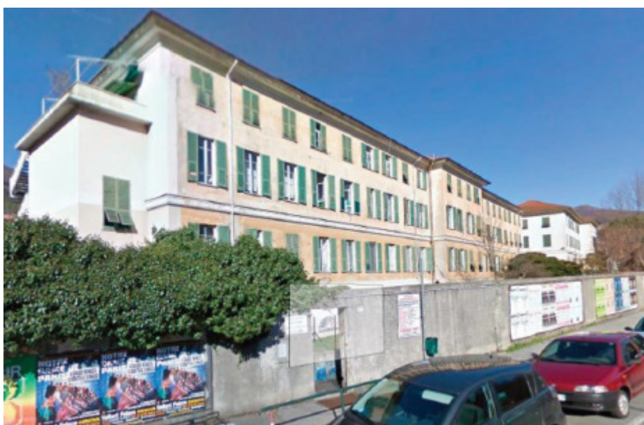
Figura 13 – Veduta prospetto principale su via Struppa ala ovest sede scolastica
