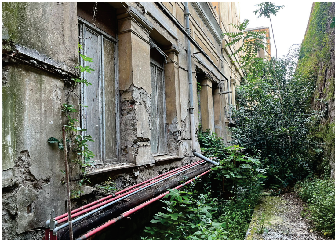
Fig. 2 – Vista del distacco ove è prevista l'installazione del nuovo impianto (a destra il muraglione di contenimento su Via Nizza).
