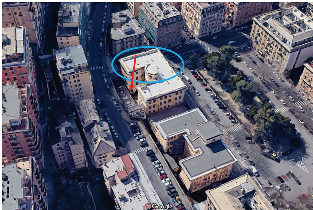
Fig. 1 – Vista 3D (fonte: Google Maps) dell'area di intervento e del comparto limitrofo. In azzurro il fabbricato ove sono localizzati i locali oggetto del presente progetto, la freccia rossa individua il sito previsto per l'installazione dell'unità esterna del nuovo impianto di climatizzazione
