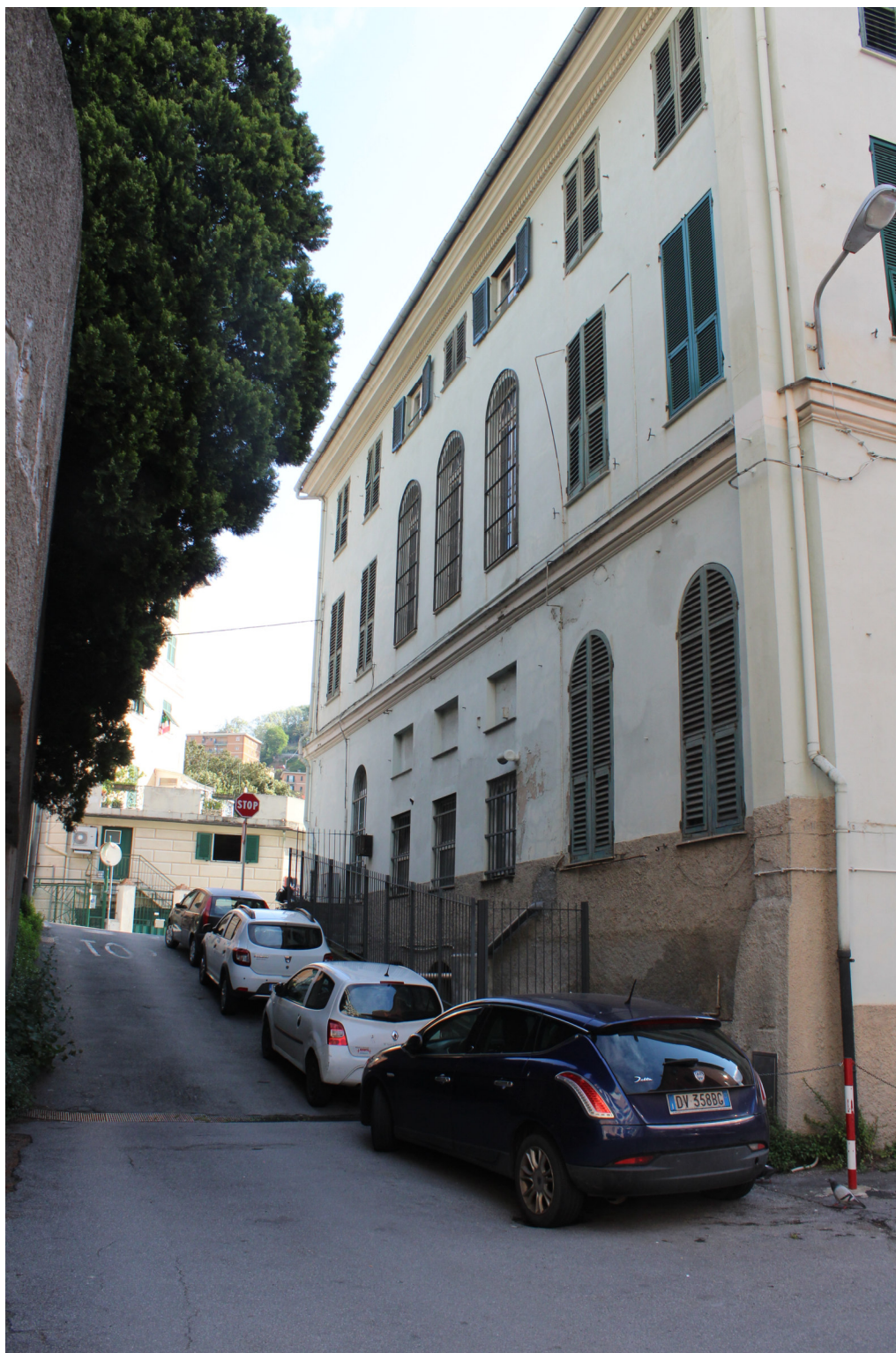
Foto n. 3 – Prospetto laterale ovest
