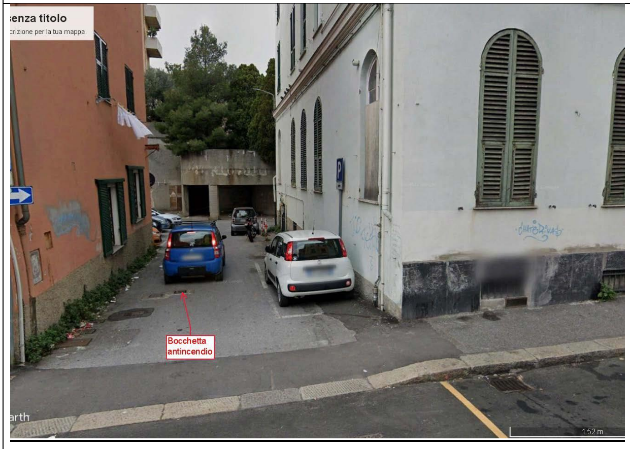
Figura N°5: localizzazione bocchetta antincendio (lotto 2)
