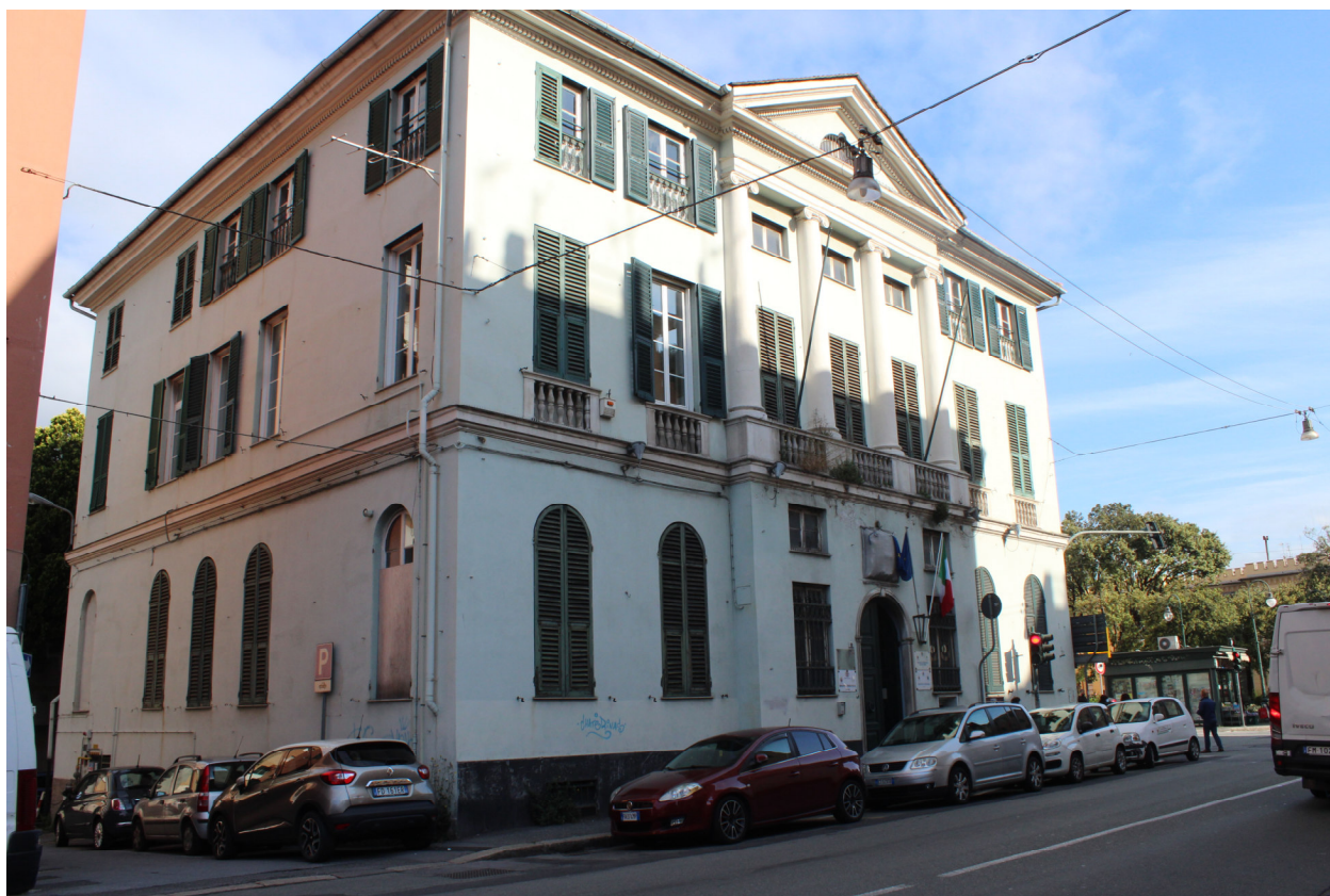
Foto n. 1 – Prospetto principale su Via Pastorino
