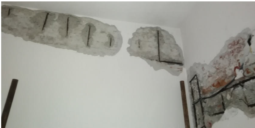
Struttura vista dall'interno
