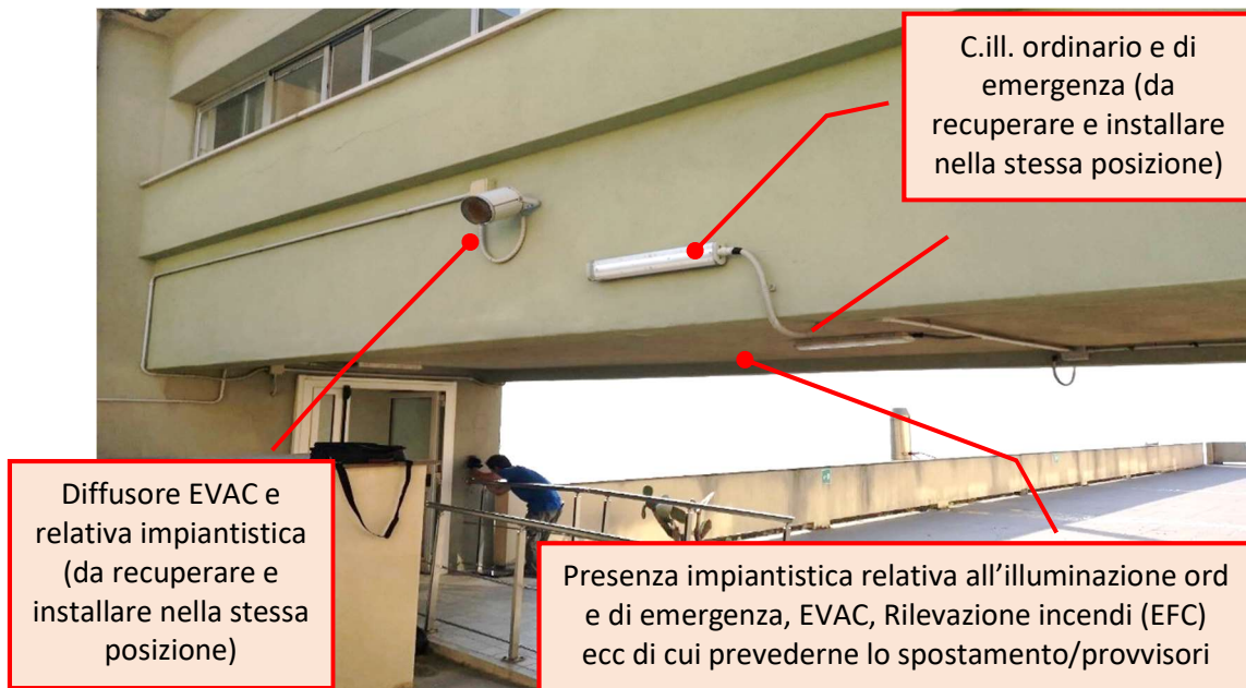
Figura 10 – Terrazzo piano secondo - Vista esterna laterale passerella lato monte
