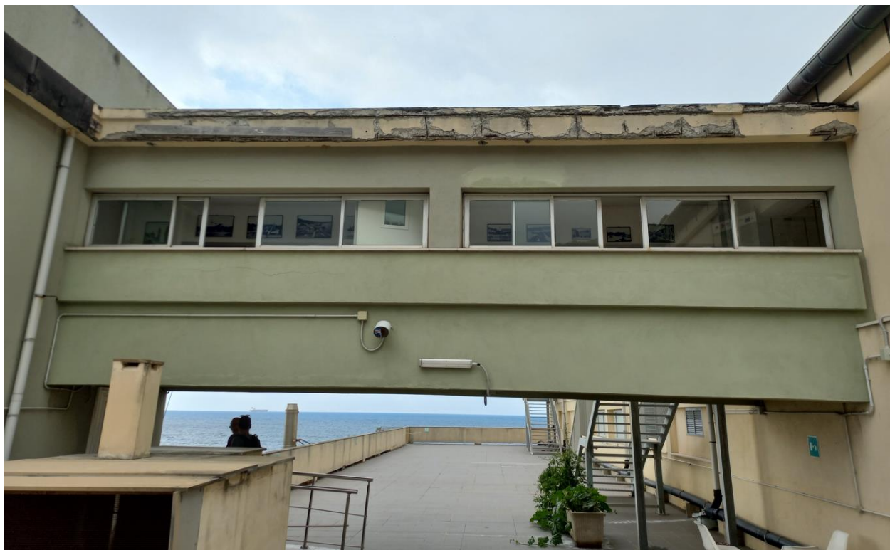
Foto 11 Vista prospetto Nord della struttura della passerella di collegamento con biblioteca
