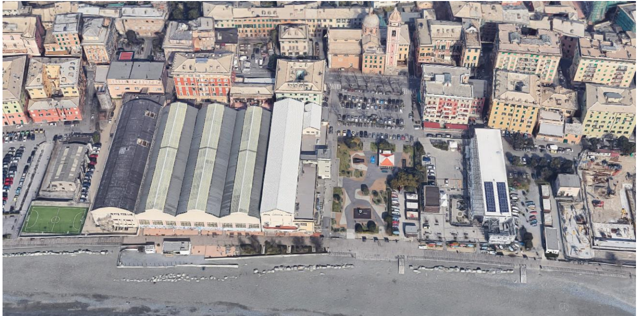
Foto 1 –Vista aerea dell'immobile
