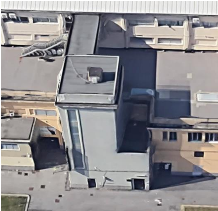
Foto 6 –Vista aerea da EST dettaglio prospetto corpo scala esistente
