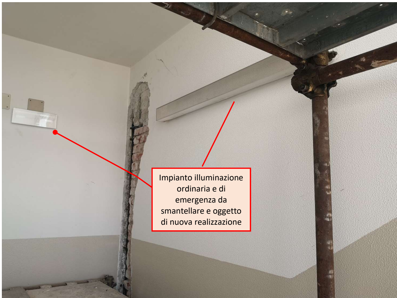
Figura 15 – Vano scale rampe
