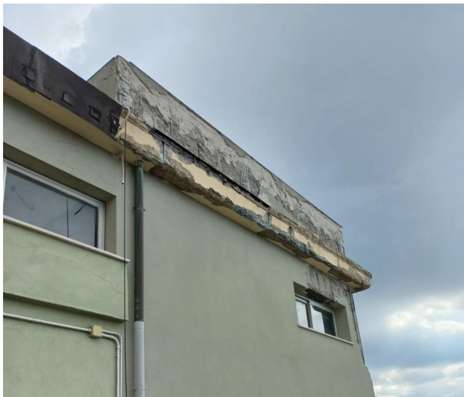
Foto 7 – 8 Vista da Sud prospetto corpo scala esistente – dettaglio stato manutentivo cornicione
