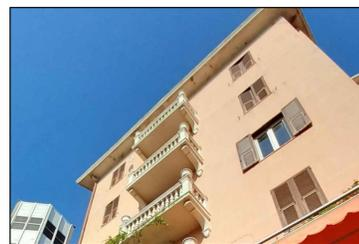
Dettagli fotografici dell'immobile particolari della tipologia da mantenere dei balconi con mensole, delle balaustre a colonnine dei balconi e della terrazza e la tipologia delle finestre con persiane alla genovese
