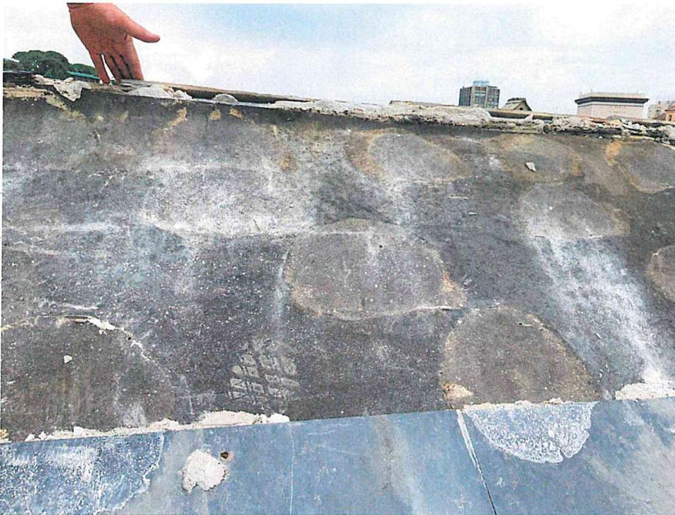
Nel seguito si evidenzia la generalizzata perdita di continuità del giunto di sigillatura con conseguente esposizione all'azione del vento ed agenti atmosferici.
