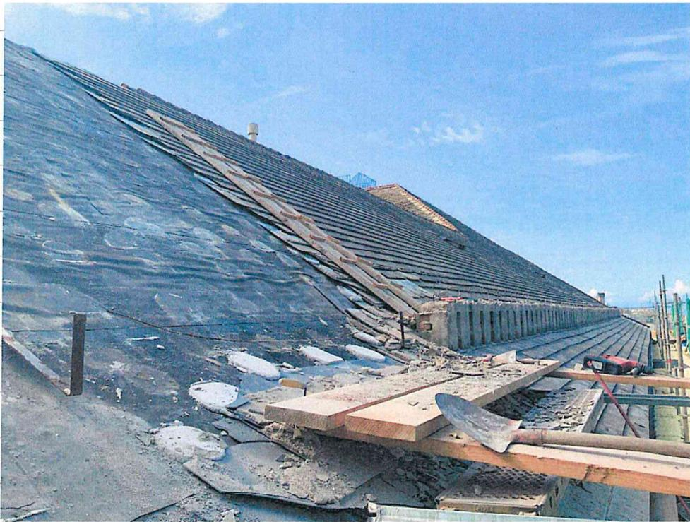
Le immagini scattate durante le fasi di demolizione che hanno interessato la falda di ponente evidenziano lo schema di posa del manto di copertura in abbadini di ardesia alla genovese, lastre di 57x57x0,4 cm circa. Gli abbadini sono fissati al solaio in latero cemento da un chiodo per ciascuno e malta di calce che occupa il primo terzo assicurando almeno in origine una sigillatura sufficiente ad impedire l'infiltrazione dell'acqua piovana anche in presenza di forte stravento.
