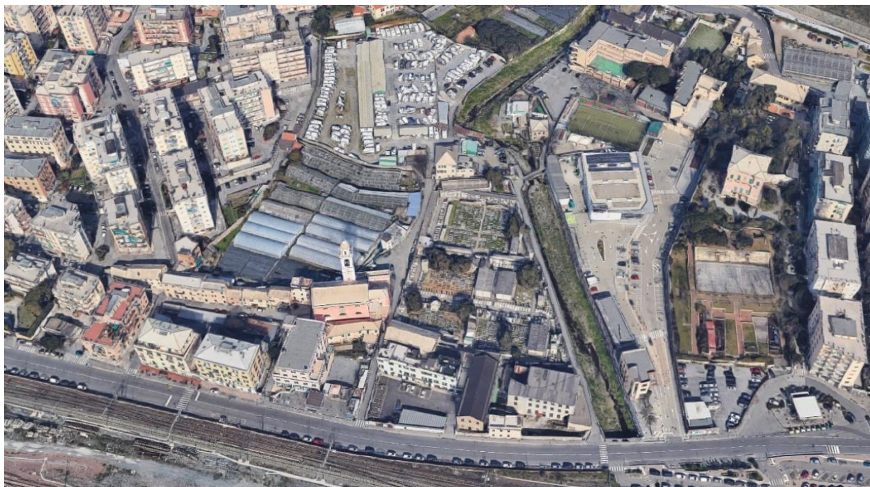
Foto1 – Area oggetto d'intervento
