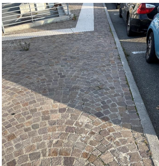
Marciapiede di Via Pra', lato mare
