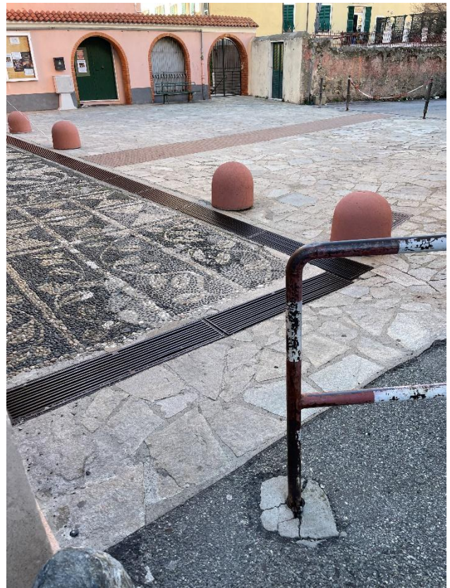
Dettaglio pavimentazione: rissêu e palladiana
