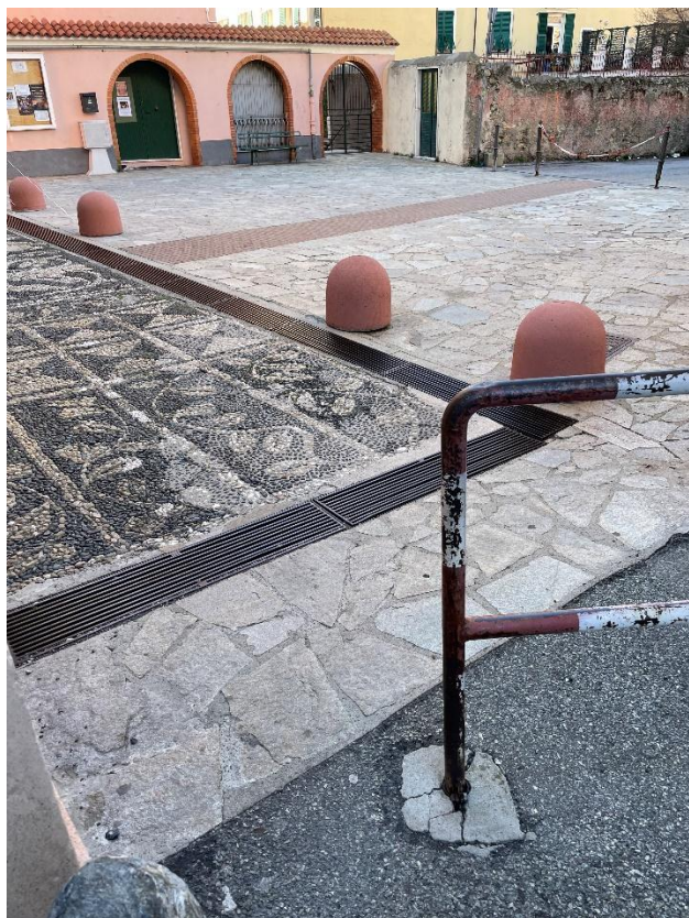
Dettaglio pavimentazione: rissê e palladiana
