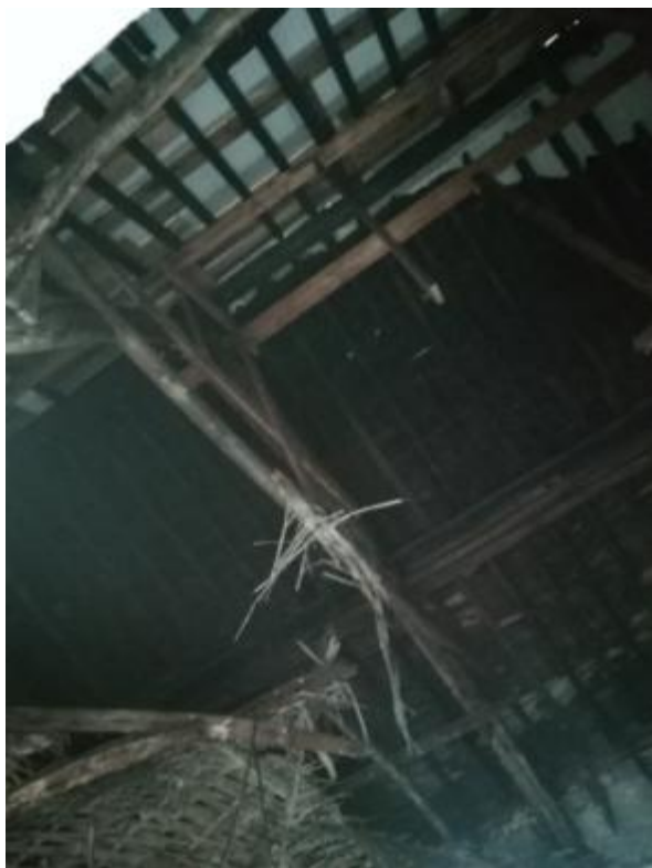
Collasso di parte della copertura e delle volte di controsoffitto a livello dell'ultimo piano
