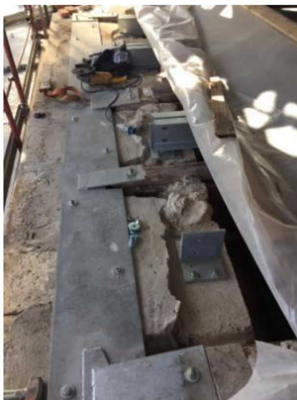
Tipologico intervento per realizzazione cordolo con piatto in acciaio
