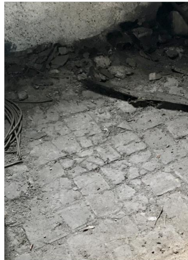
PAVIMENTI IN PIASTRELLE DI COTTO
