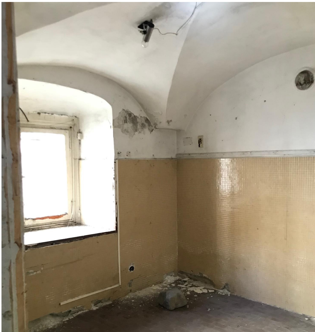
Fig. 20 Il vano al primo ammezzato in cui sarà posizionata la scala di emergenza
