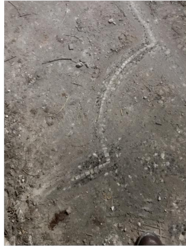
PAVIMENTI IN GRANIGLIA DI MARMO UNIFORMI O CON BORDURA (solo P01_stanza 15)
