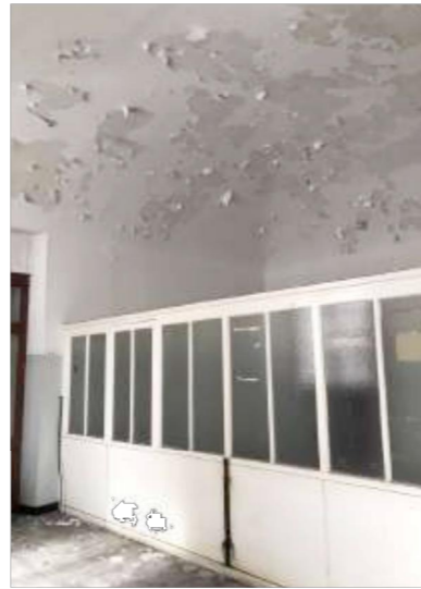
UMIDITA' DI RISALITA ESFOLIAZIONE DI PITTURE
