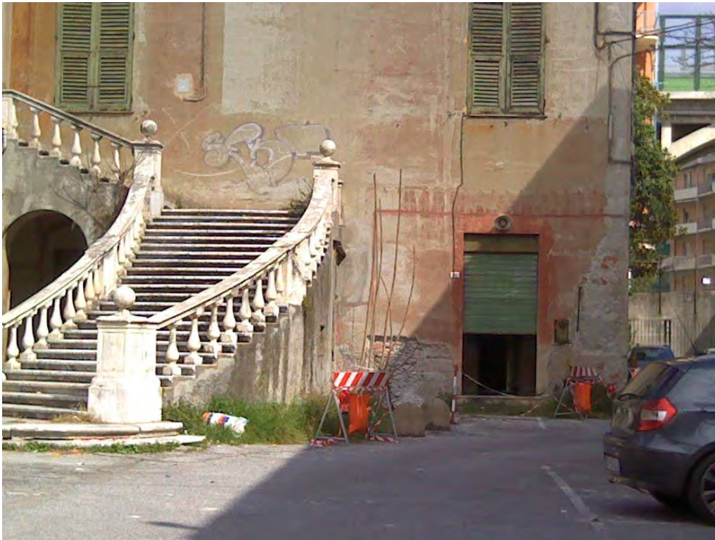
Foto DC_2552 – Facciata principale
