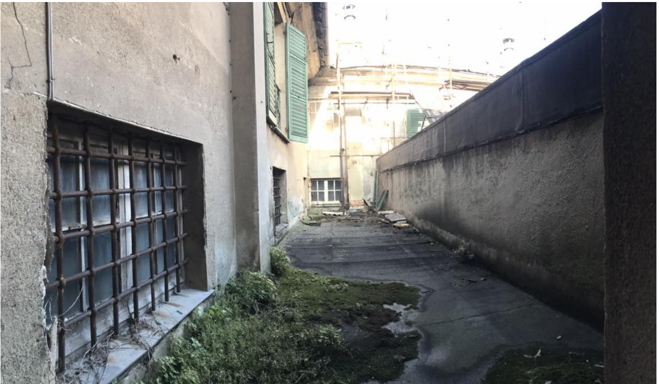
Fig. 15 La 'vasca' a cielo aperto chiusa tra il volume originale della villa ed il salone maggiore settecentesco..
