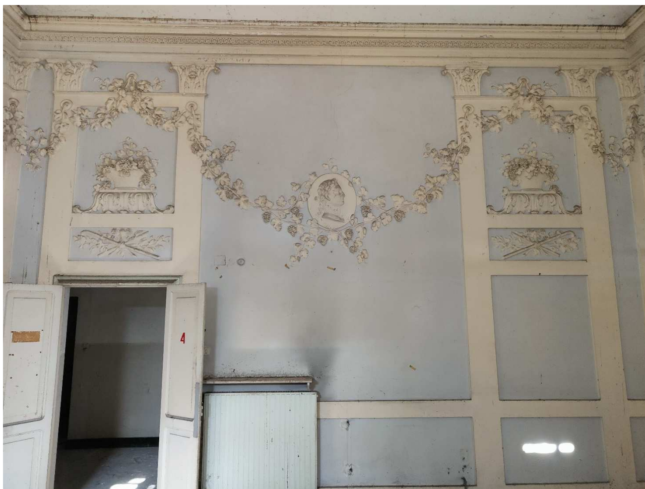
Figura 3.3 – Vista locali con impianto a radiatori
