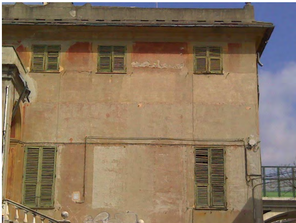
Foto DC_2548 – Facciata principale
