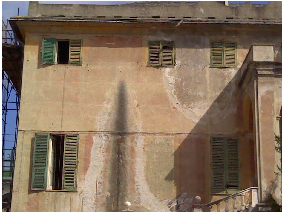
Foto DC_2542 – Facciata principale
