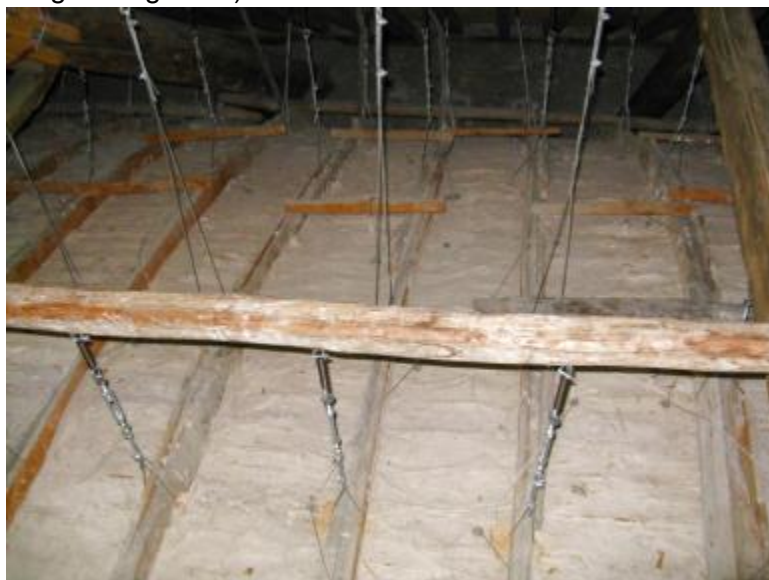
Tipologico applicazione pendini in acciaio sulle costolature della volta in camorcanna
