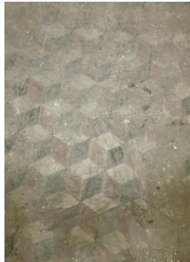
PAVIMENTI IN CEMENTINE ESAGONALI ALLA GENOVESE CON DISEGNO GEOMETRICO
