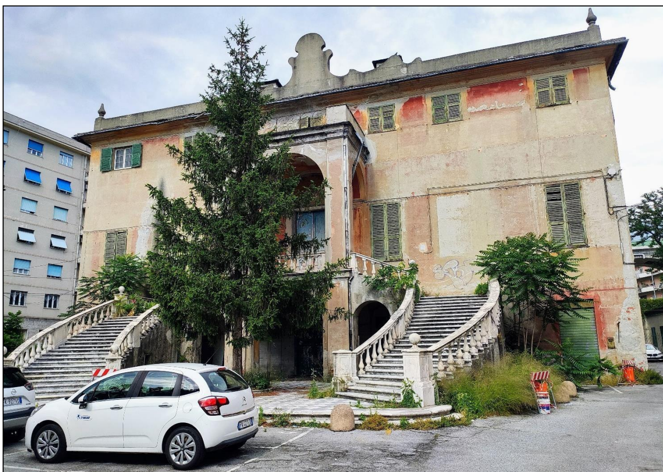
Vista esterna del fabbricato in oggetto
