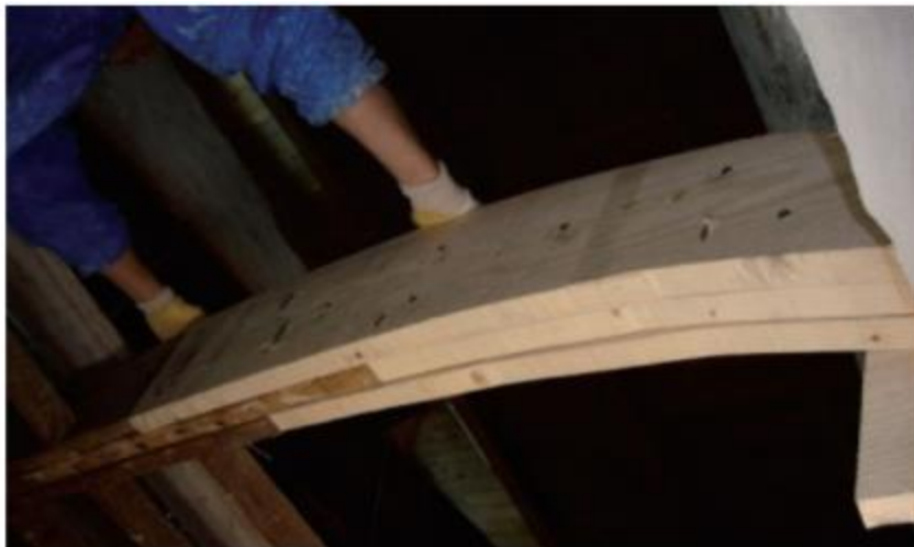
Ricostruzione di testata in legno ammalorata con elementi lignei accoppiati
