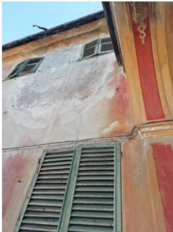
Lesioni sulla facciata Ovest, a ridosso di alcune aree sottoposte a dilavamento
