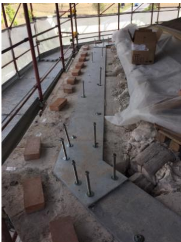
Tipologico intervento per realizzazione cordolo con piatto in acciaio
