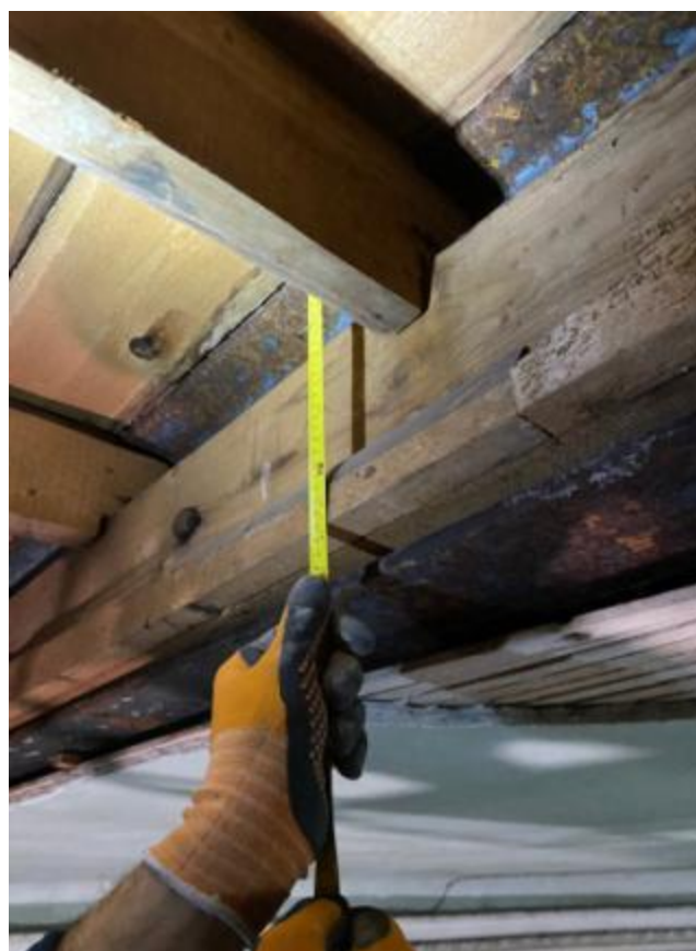
Misurazioni eseguite in loco
