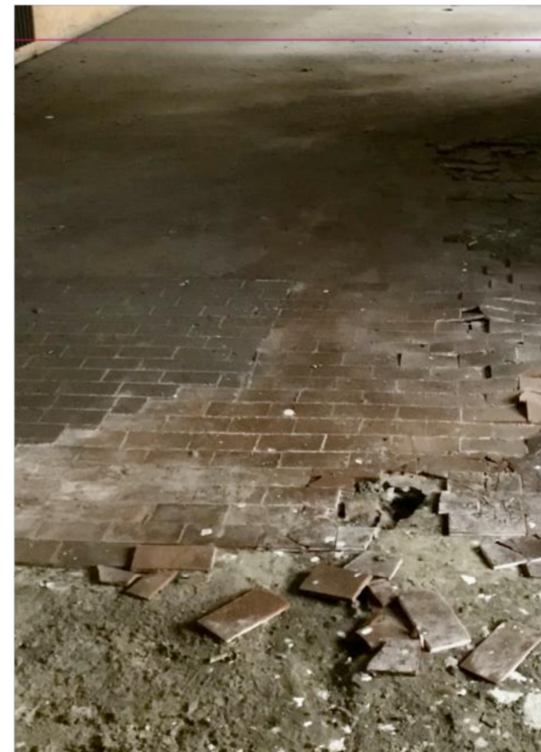
PAVIMENTI IN PIASTRELLE DI KLINKER ROSSO DA CM 8X15
