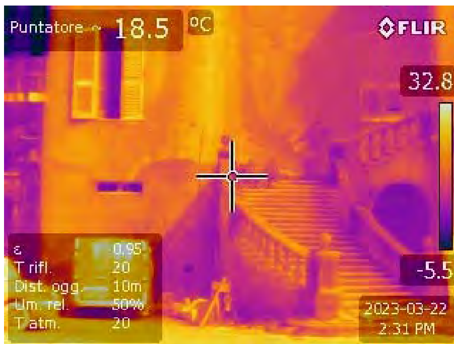
Foto IR_2543 – Il termogramma non evidenzia particolari disomogeneità del paramento murario.
