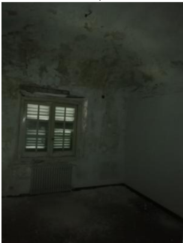
Infiltrazioni che interessano le volte in camorcanna al secondo piano, sia sul fronte Est che su quello Ovest
