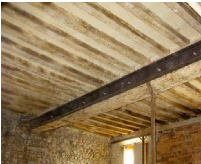
Esempi di rinforzo orditura principale con profili in acciaio accoppiati
