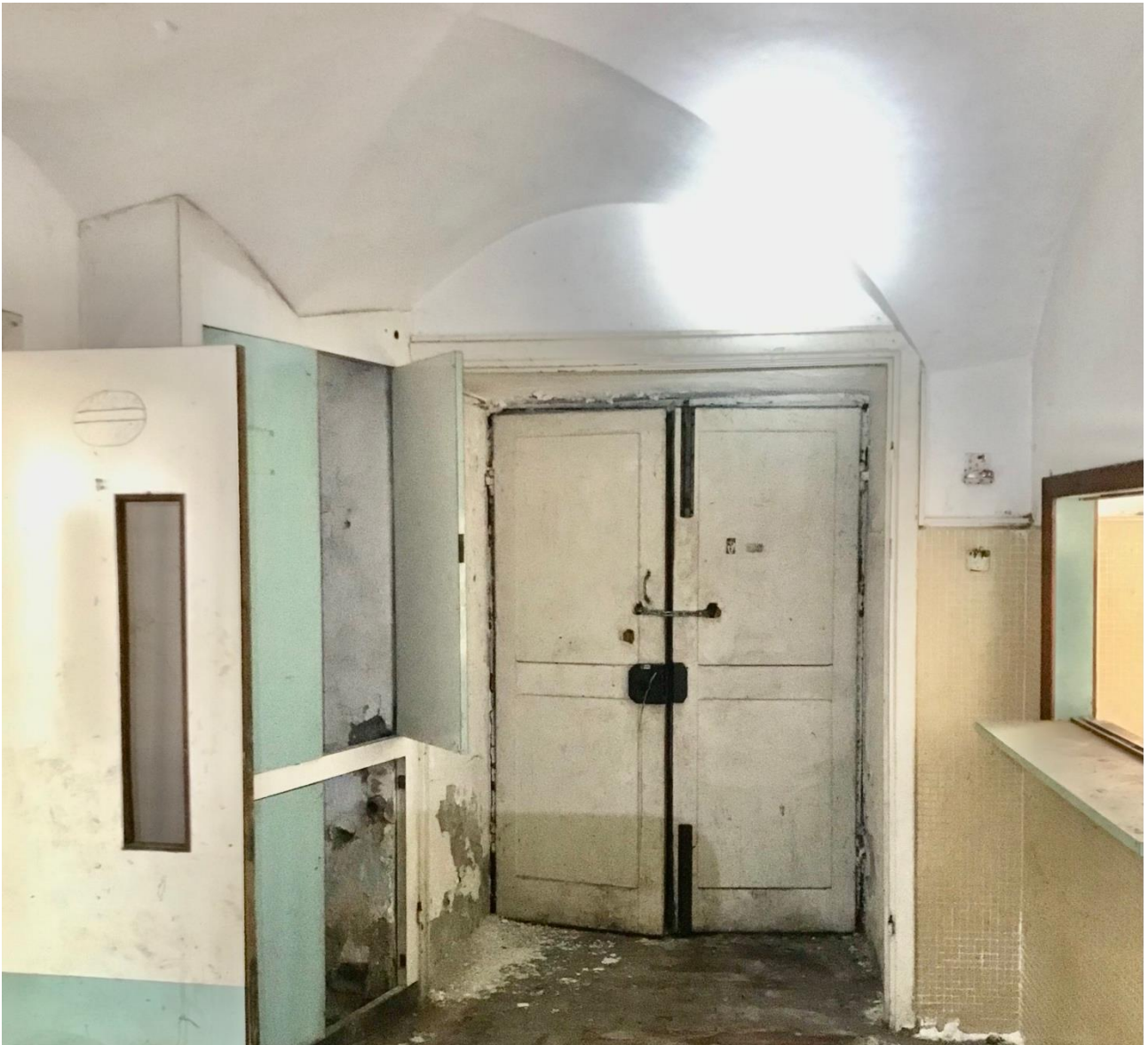
Fig. 18 - 19 Il fianco lungo via Vezzani con la porta tamponata da ripristinare come uscita di sicurezza
