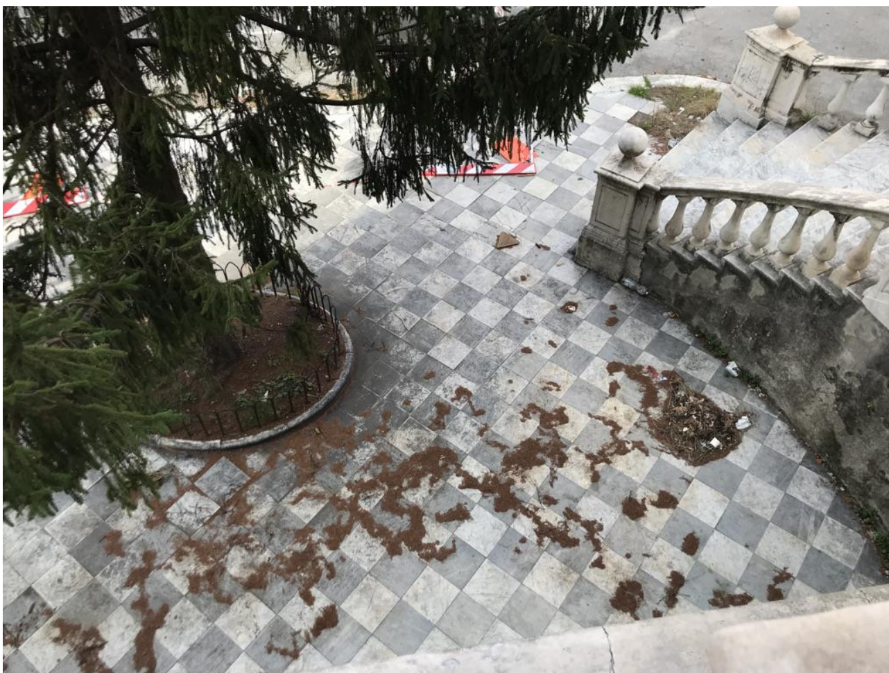
Fig. 11 La pavimentazione tra i due bracci dello scalone esterno.
