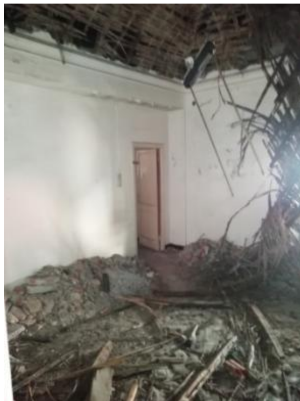
Collasso di parte della copertura e delle volte di controsoffitto a livello dell'ultimo piano
