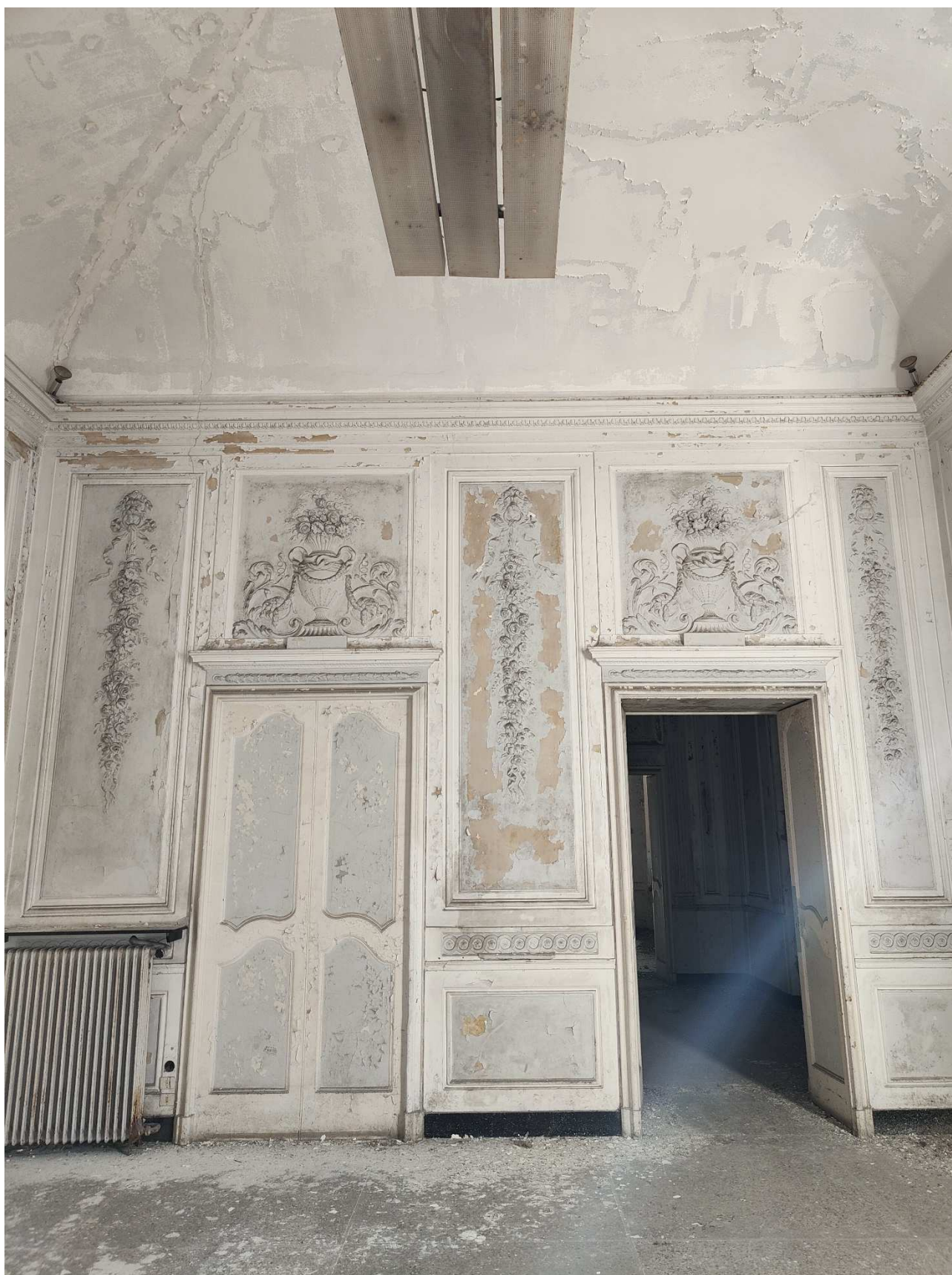
Figura 3.2 – Vista locali con impianto a radiatori
