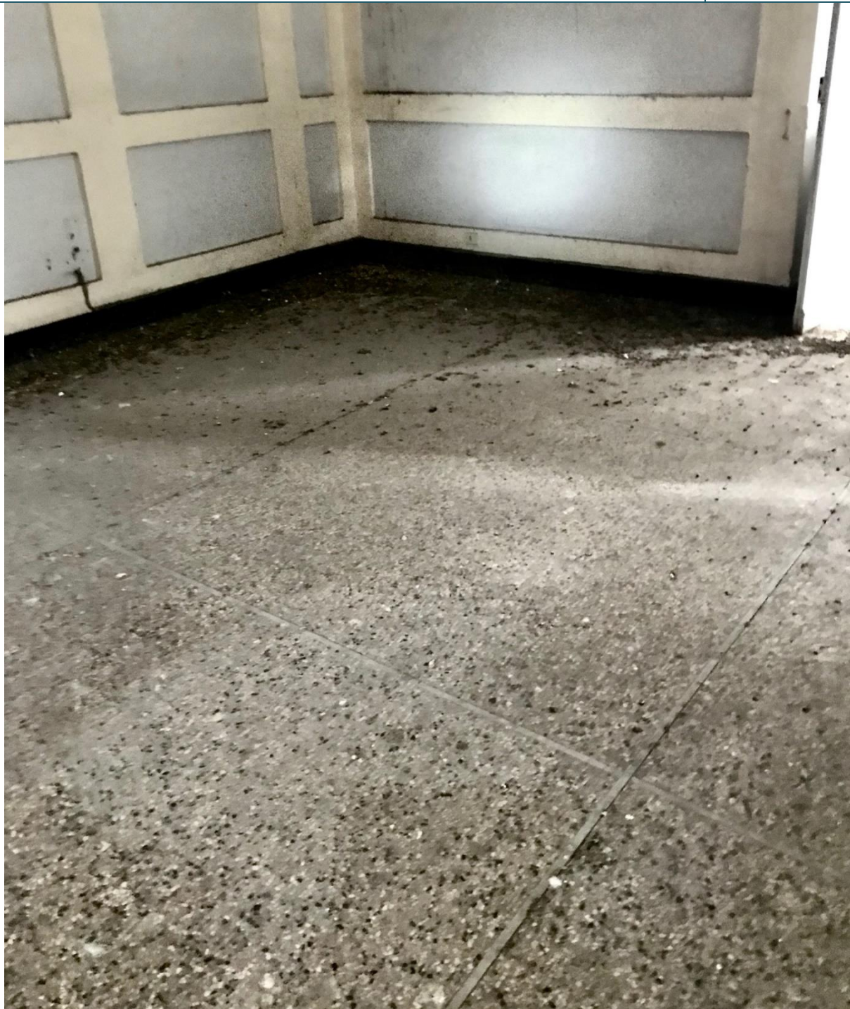
Fig. 12 Pavimentazione in graniglia uniforme, riquadrata da listelli in marmo bianco databile attorno agli anni '30 del '900.
