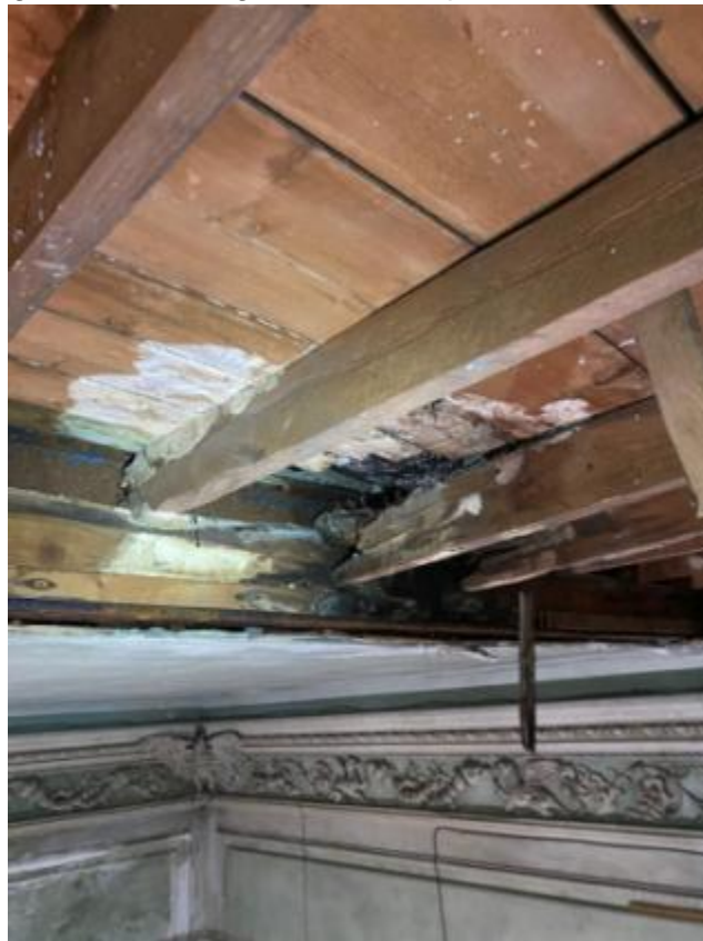
Crollo di porzione del controsoffitto del salone e dettaglio sul grado di danneggiamento delle orditure lignee
