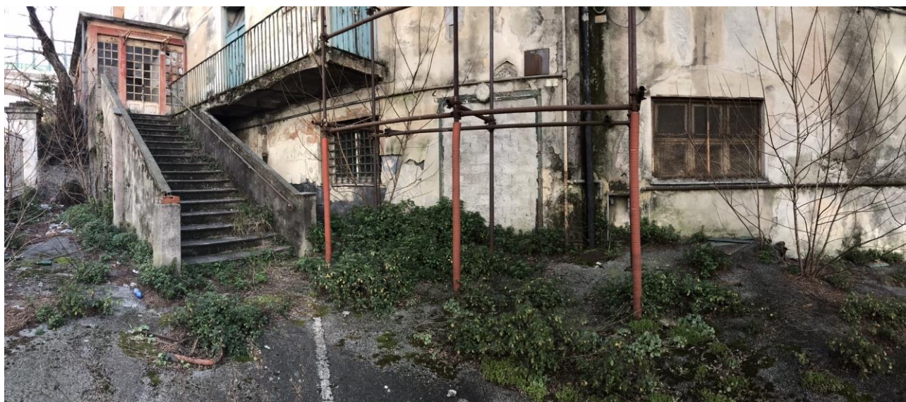
Fig. 18 - 19 Il fianco lungo via Vezzani con la porta tamponata da ripristinare come uscita di sicurezza
