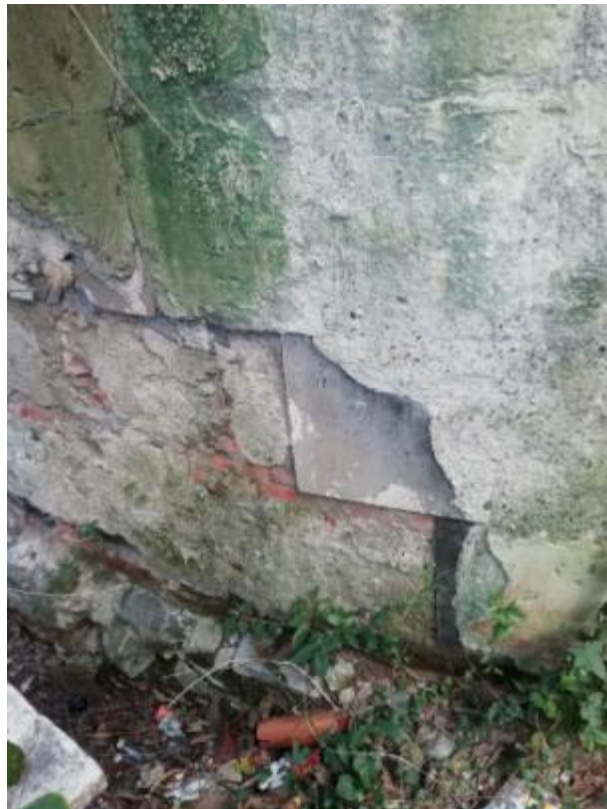
Terreno esterno a diretto contatto con il sistema fondale. Si notano alcune lastre di ardesia inserite sotto l'intonaco per impermeabilizzare la parete nei confronti degli agenti atmosferici esterni
