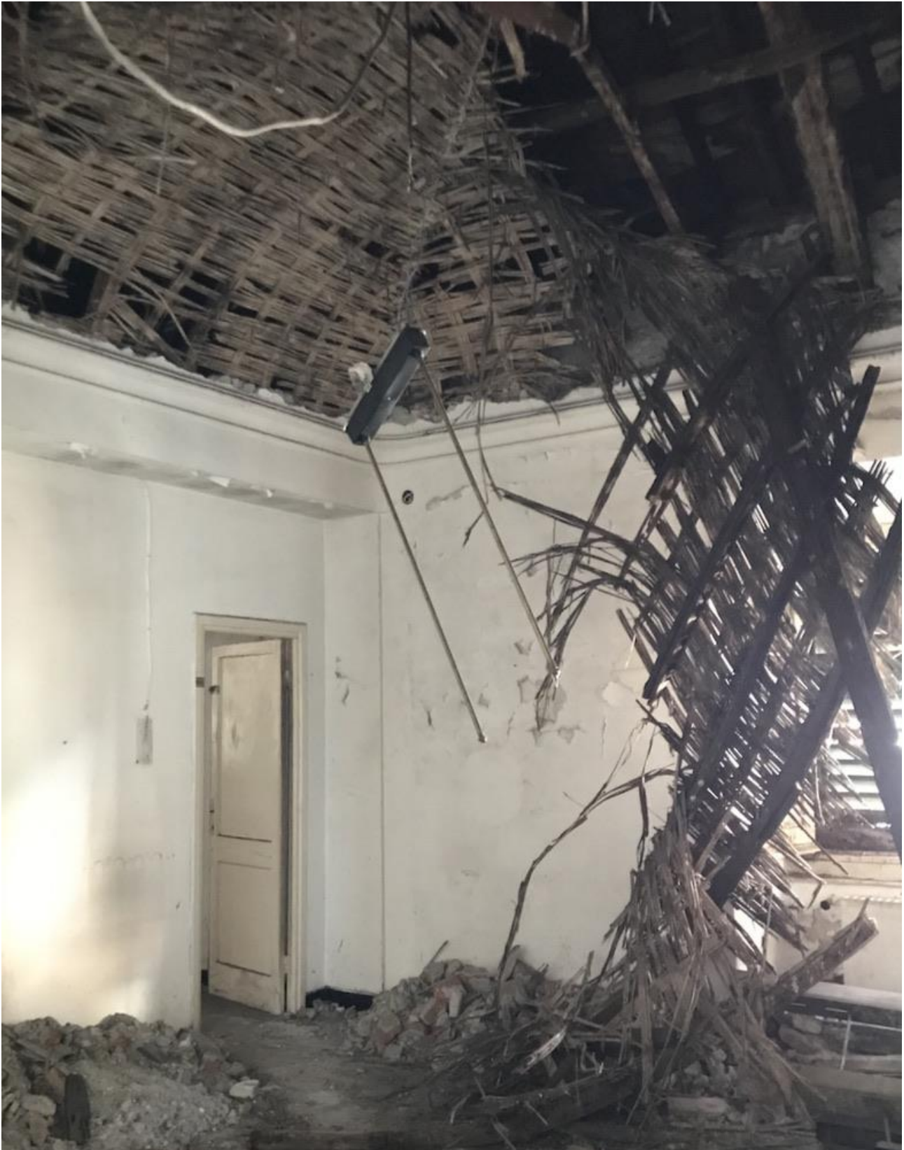
Fig. 16 Il collasso di una volta in canniccio al secondo piano.
