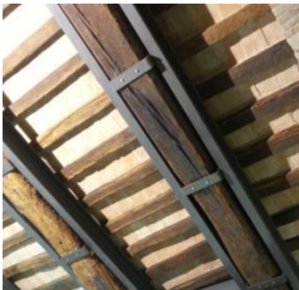
Esempi di rinforzo orditura principale con profili in acciaio accoppiati
