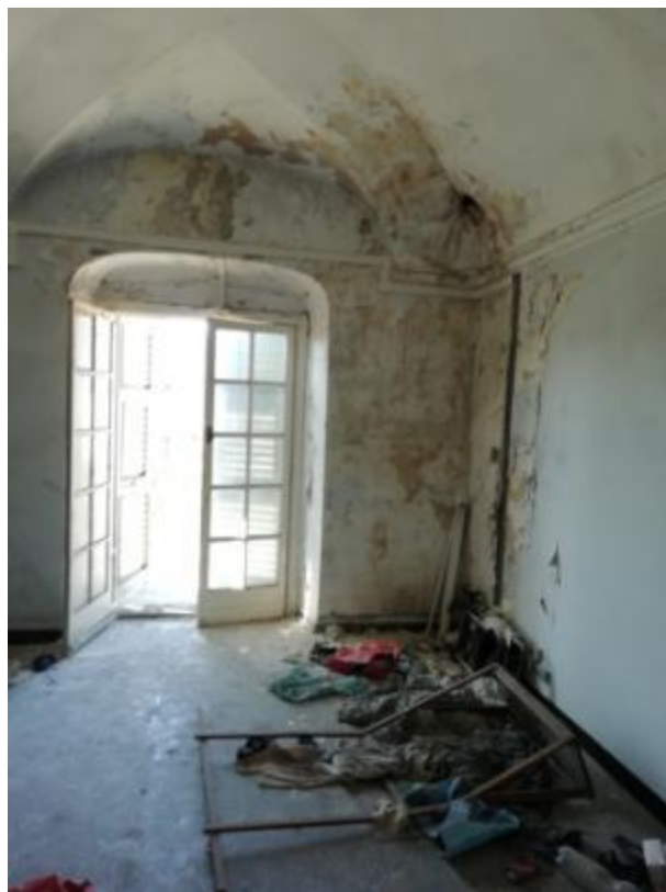
Infiltrazioni che interessano le volte in camorcanna al secondo piano, sia sul fronte Est che su quello Ovest
