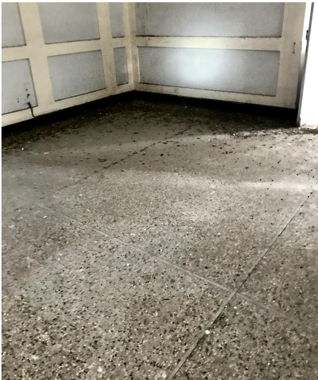
Fig. 12 Pavimentazione in graniglia uniforme, riquadrata da listelli in marmo bianco databile attorno agli anni '30 del '900.
