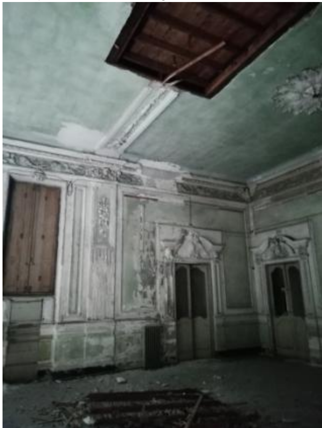
Crollo di porzione del controsoffitto del salone e dettaglio sul grado di danneggiamento delle orditure lignee
