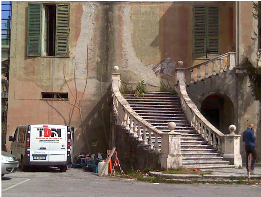
Foto DC_2544 – Facciata principale
