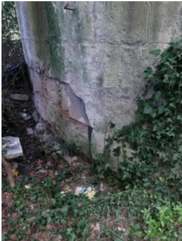
Terreno esterno a diretto contatto con il sistema fondale. Si notano alcune lastre di ardesia inserite sotto l'intonaco per impermeabilizzare la parete nei confronti degli agenti atmosferici esterni
