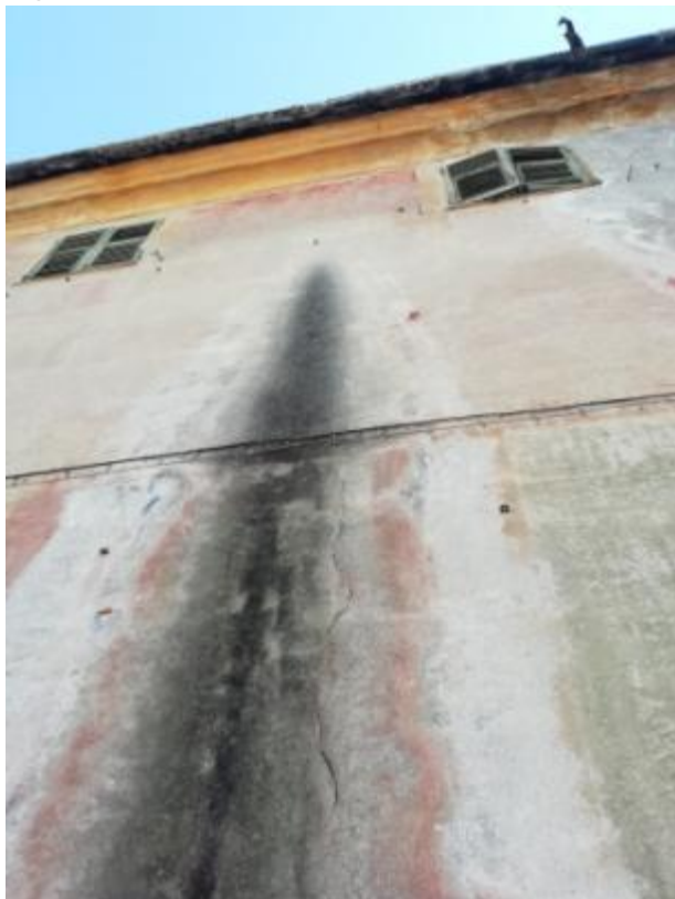
Lesioni sulla facciata Ovest, a ridosso di alcune aree sottoposte a dilavamento
