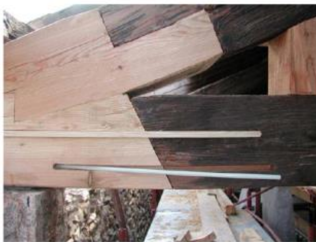
Tipologico intervento di ricostruzione di testata ammalorata
