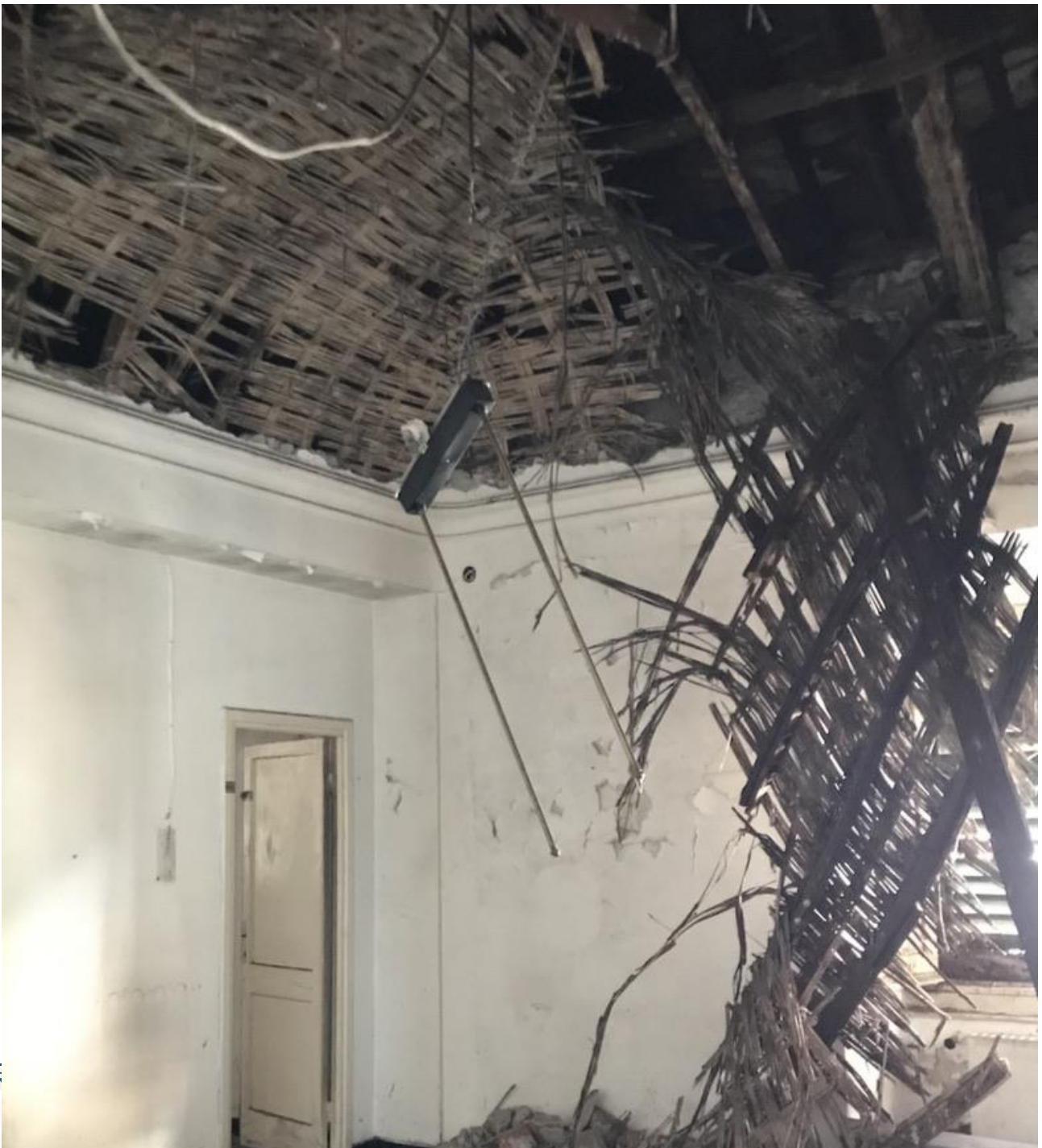
Fig. 15 La 'vasca' a cielo aperto chiusa tra il volume originale della villa ed il salone maggiore settecentesco..
