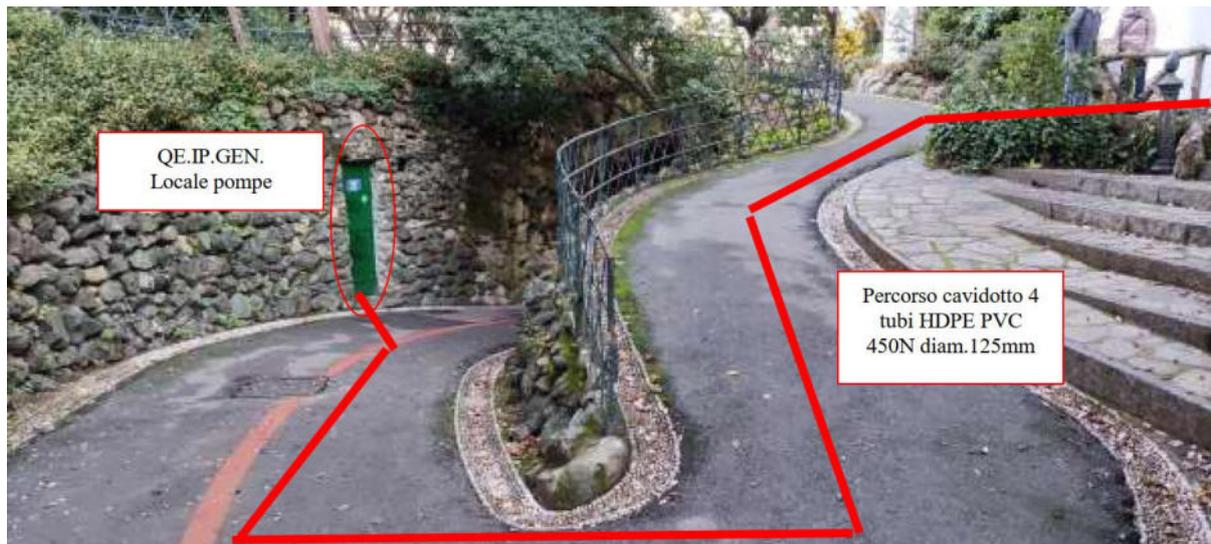
Figura 9 - Percorso cavidotto dal QE.IP.GEN (locale pompe) al nuovo QE.IP01
