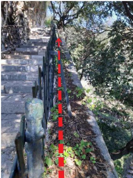
Figura 7 - n°2 tubi corrugati PVC 750N doppia parete Ø40mm posati interrati superficialmente nell'aiuola
