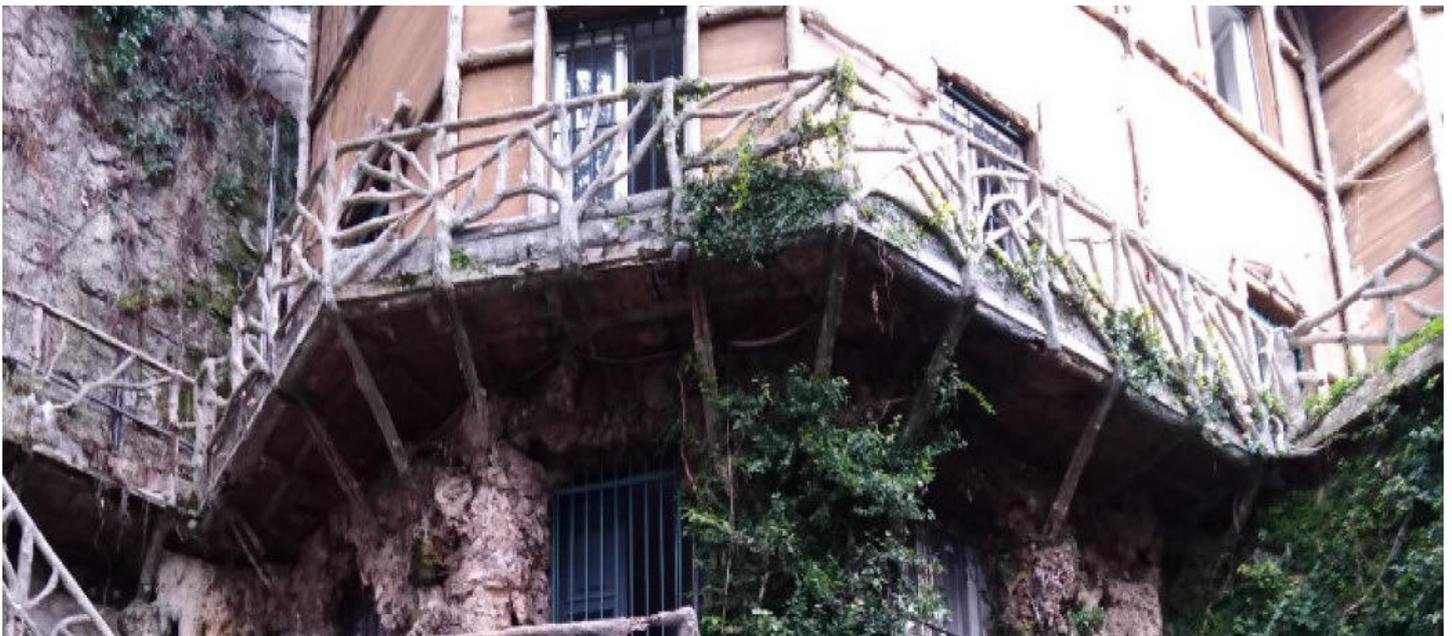
La parte piana di calpestio è invece realizzata in c.a. ed è possibile scorgere l'armatura molto ammalorata in numerosi punti.
