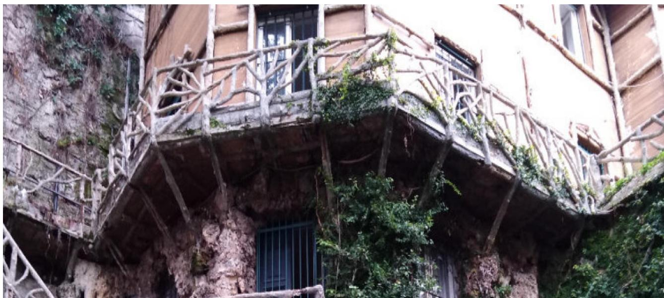
La parte piana di calpestio è invece realizzata in c.a. ed è possibile scorgere l'armatura molto ammalorata in numerosi punti.
