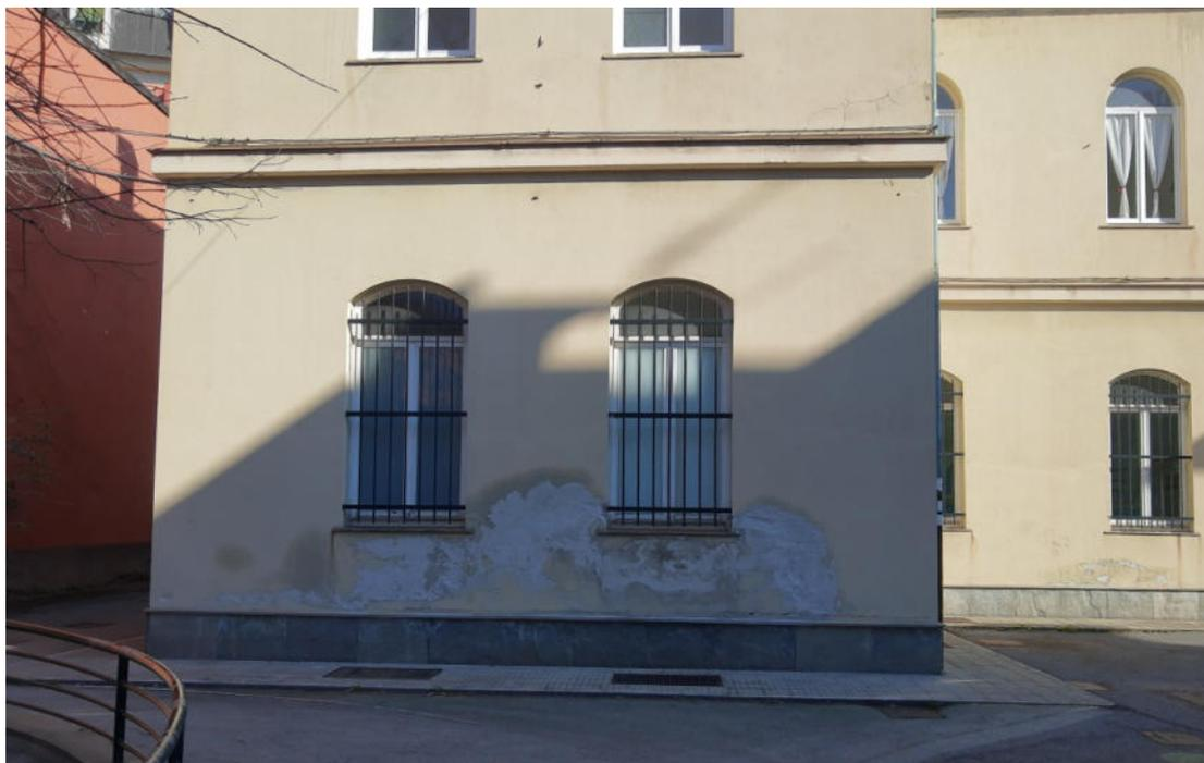
Il piano interrato è quasi interamente composto da un ampio locale aerato, le cui pareti sono direttamente soggette sia all'umidità di risalita sia alle infiltrazioni dirette di acqua piovana dalle aperture affaccianti sulle intercapedini, e quindi in avanzato stato di degrado, con presenza di efflorescenze saline e distacchi.
