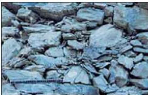
Definizione NORMAL 1/88: degradazione che si manifesta col distacco totale o parziale di parti (scaglie) spesso in corrispondenza di soluzioni di continuità del materiale originario. Le scaglie, costituite generalmente da materiale in apparenza inalterato, hanno forma irregolare e spessore consistente e disomogeneo.
