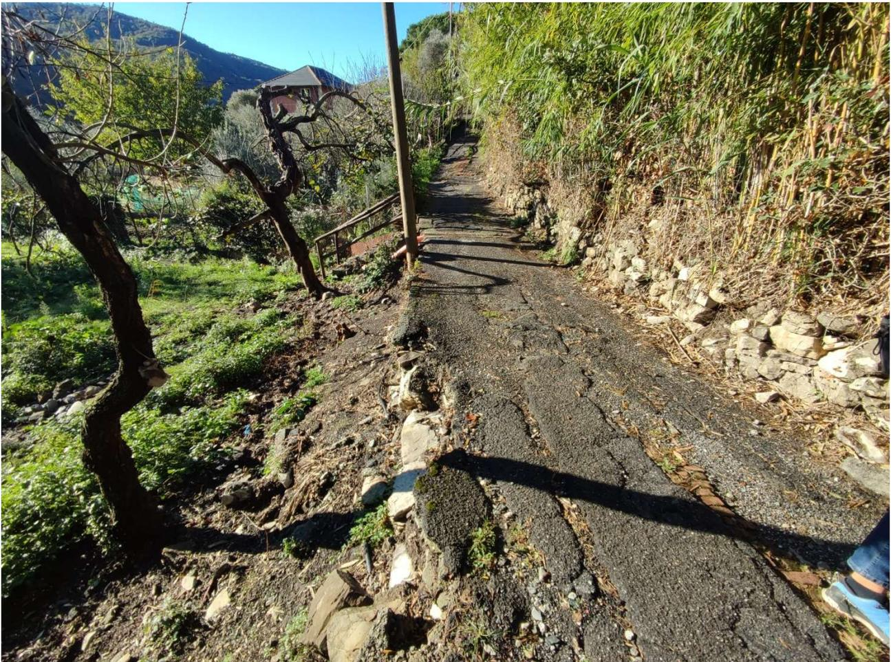
*- Ulteriore porzione di strada carrabile soggetta a franamenti delle strutture di contenimento di valle*
