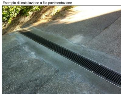
Esempio di installazione a filo pavimentazione
