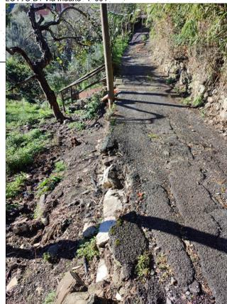
**ZONA DI CRITICITA' N° 1** - Porzione di tramite carrabile con struttura di contenimento a valle ancora in opera, ma attualmente caratterizzata da vistosi fuoriuscimenti della mensola verticale di contenimento e locali spaccamenti sempre del paramento verticale.
