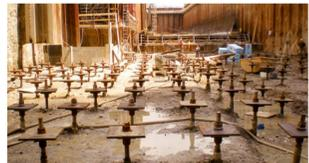
**Chiodature stabilizzazione pavimentazione:**
