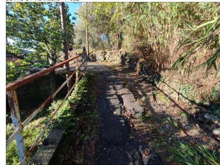
**ZONA DI CRITICITA' N° 2** - Porzione di sede stradale con impluvio di convergenza delle pendenze che dovrà essere oggetto di particolare attenzione durante la realizzazione della piastra armata di supporto al manto carrabile con riferimento allo smaltimento delle acque di ruscellamento.
