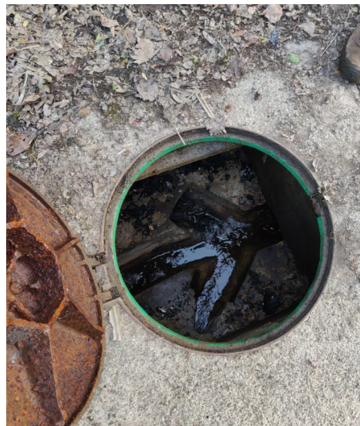
Foto 8 - Foto 9: a sx pozzetto di ispezione della fognatura nera in un angolo del piazzale tra la struttura EX-macelli e la scarpata; a dx pozzetto al centro del piazzale che raccoglie due rami di fognatura nera e li convoglia verso via Mogadiscio.
