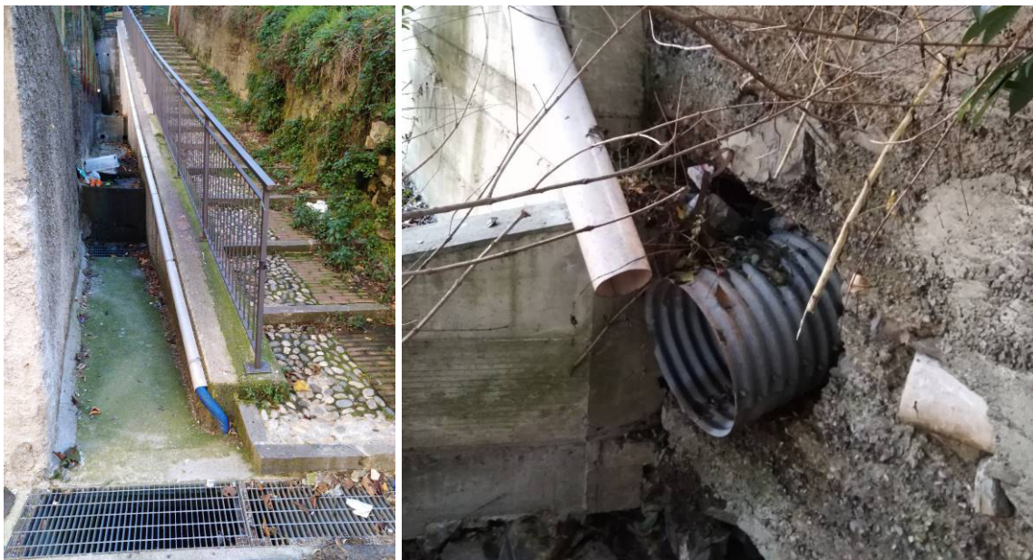
Foto 3 - Foto 4: a sinistra rio Famejano, incanalato in adiacenza all'omonima "mattonata", a monte di Via Terpi; a destra l'uscita della tombinatura in corrispondenza del Civ. 18a , presso la sommità della scarpata oltre a tubazioni secondarie derivanti dai pluviali e drenaggi a tergo delle opere di sostegno.
