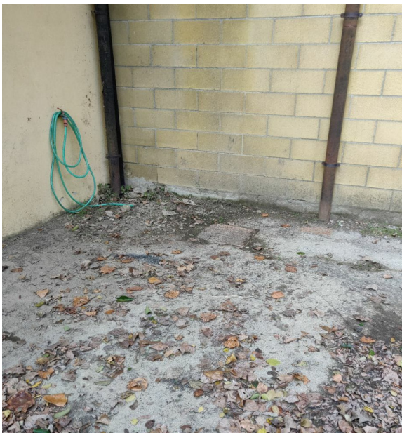
Foto 8 - Foto 9: a sx pozzetto di ispezione della fognatura nera in un angolo del piazzale tra la struttura EX-macelli e la scarpata; a dx pozzetto al centro del piazzale che raccoglie due rami di fognatura nera e li convoglia verso via Mogadiscio.
