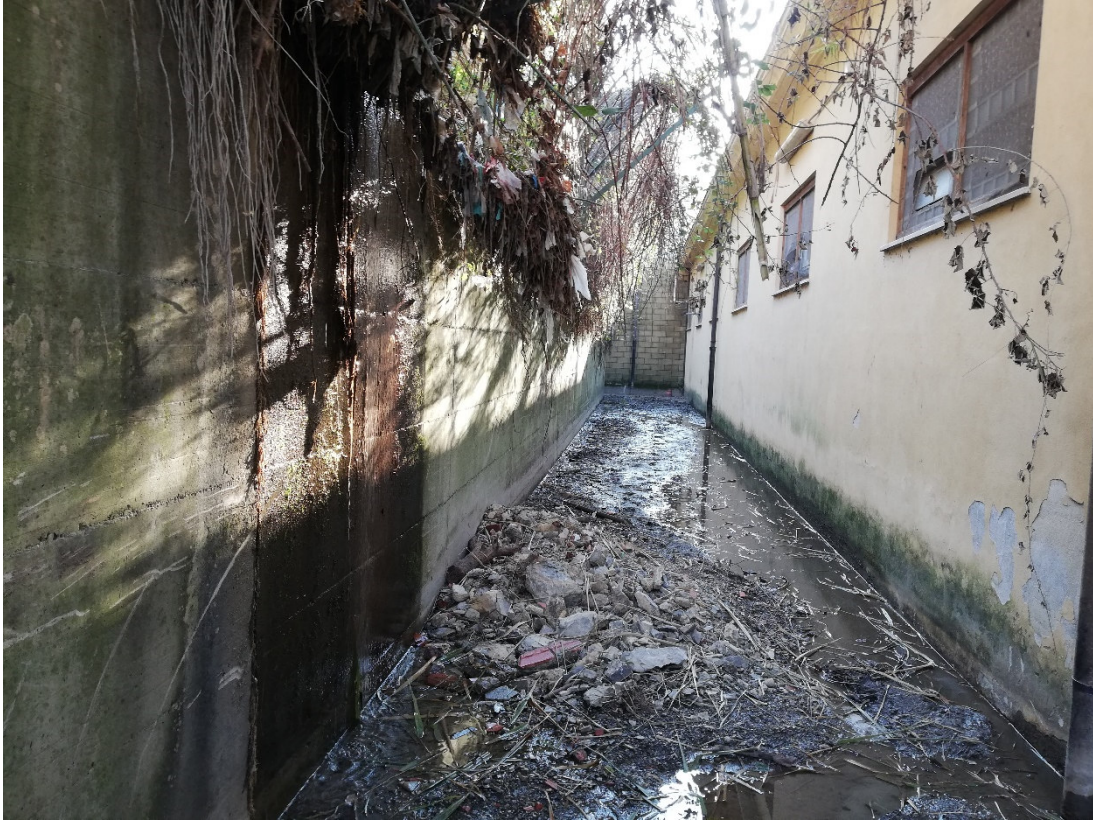
Figura 7: materiale solido in prossimità dei fabbricati (ex macelli)
