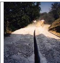
Trattasi dell'esecuzione di rimozione dell'asfalto mediante l'utilizzo di macchina taglia asfalto a disco, dotata di regolazione della profondità di taglio per mezzo dell'abbassamento del disco, ed allontanamento dei materiali di risulta.
