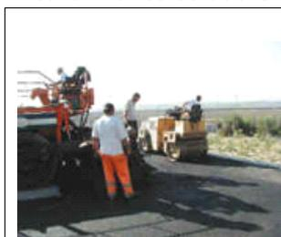
La fase di lavoro prevede la finitura del manto stradale formato da: conglomerato bituminoso (binder) e tappetino, stesi a caldo e di vario spessore. I vari strati sono stesi con vibrofinitrice, previo spandimento di bitume liquido su sottofondo già predisposto.
