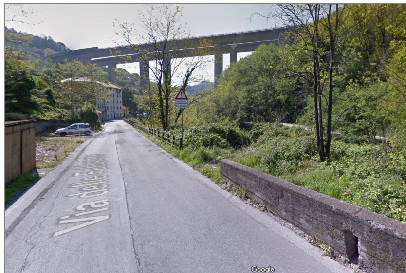
Figura 23_Punto di accesso da sponda sinistra. Sulla sinistra dell'immagine, zona di parcheggio che può rivestire la funzione di area di cantiere.
