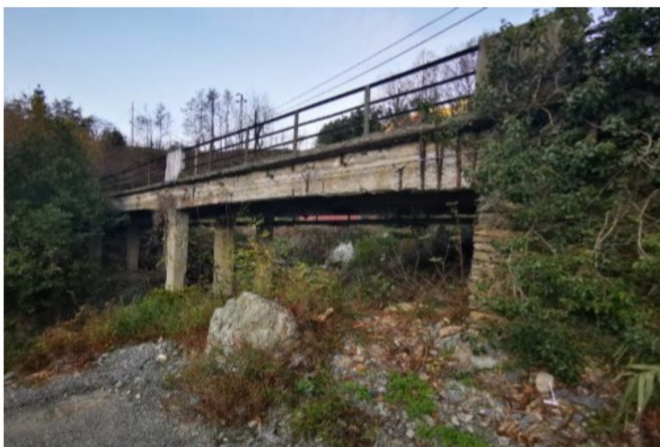
Figura 5: Ponte stato attuale
