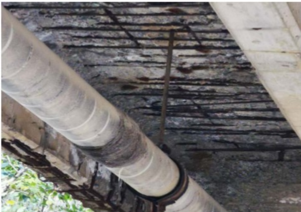
Figura 6: Dettaglio intradosso ponte attuale
