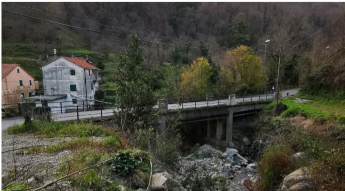
Figura 4: Vista laterale del ponte in esame
