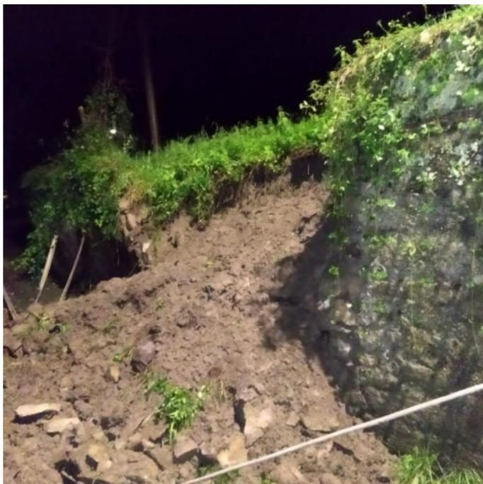
*Foto 5 – Particolare del tratto di muro, oltre la frana, vistosamente fuori piombo.*
