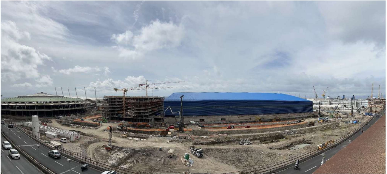
Figura 4-Area del cantiere Waterfront vista da Corso Aurelio Saffi
