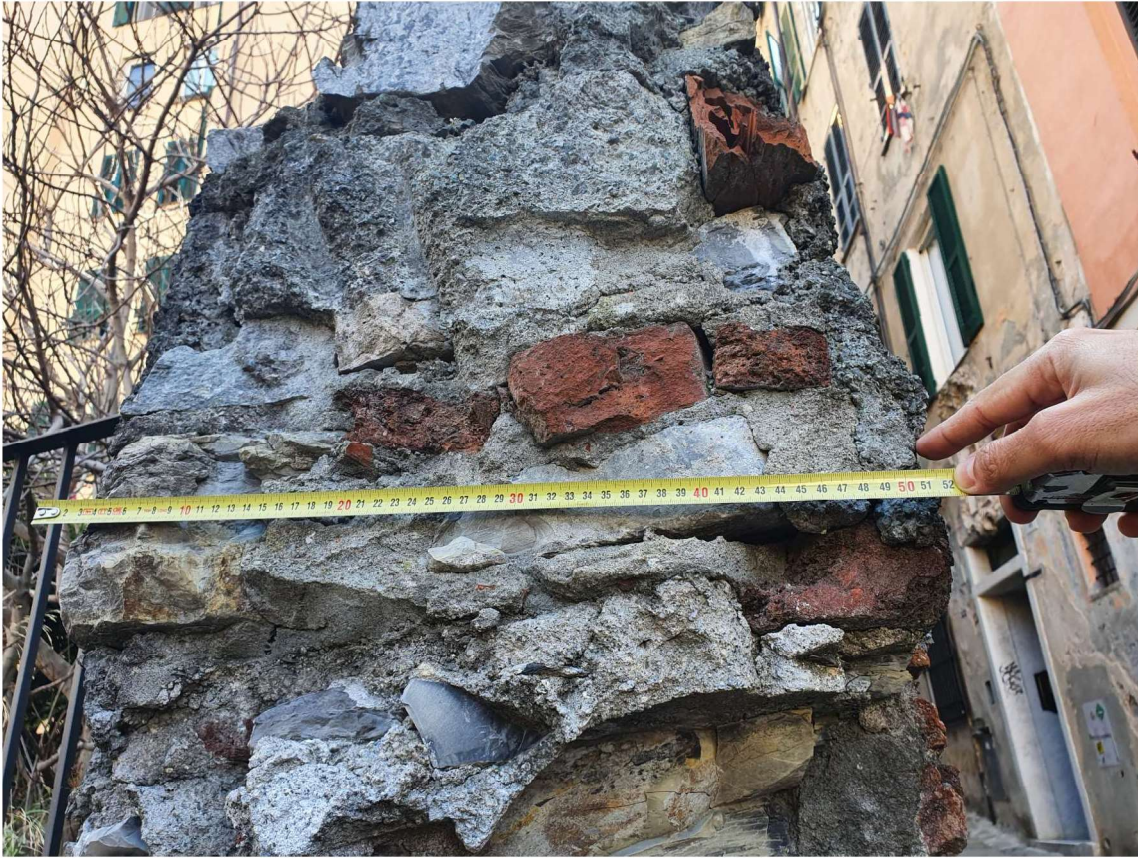
Foto 3 – Misura dello spessore della muratura in testata (circa 50 cm).
