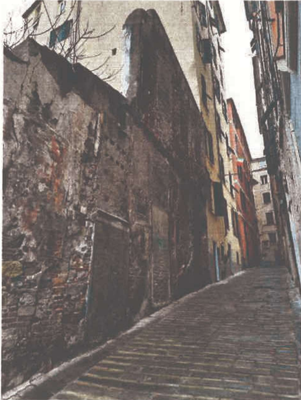
figura 3: Prospetto su strada - Vista da Vico delle Fate della parte alta del muro verso Vico del Dragone
