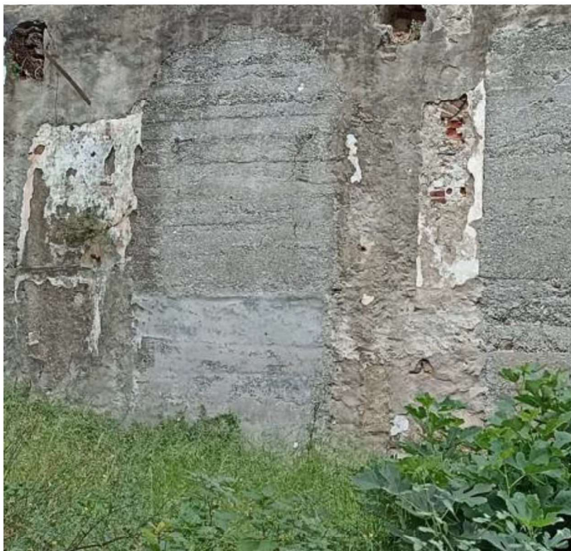
Foto 2 - Rinforzi a contrafforte
