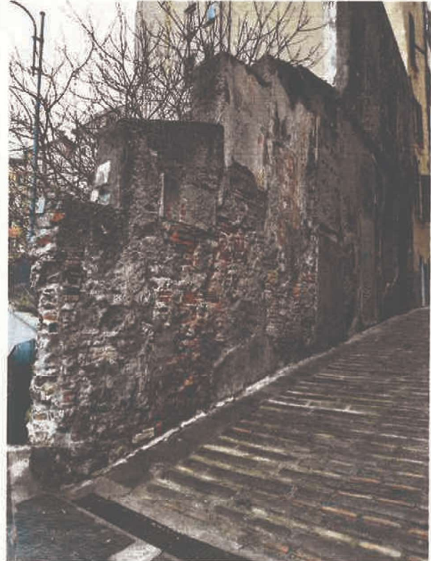
figura 4: Prospetto su strada - Vista da Vico delle Fate della parte bassa del muro verso Vico del Fico
