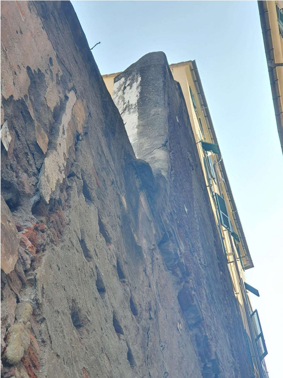
Foto 5 – Dettaglio dell'aggetto della muratura alta eseguita su archetti in mattoni pieni. Si nota lo spessore pari sempre a circa 50 cm anche della muratura alta.
