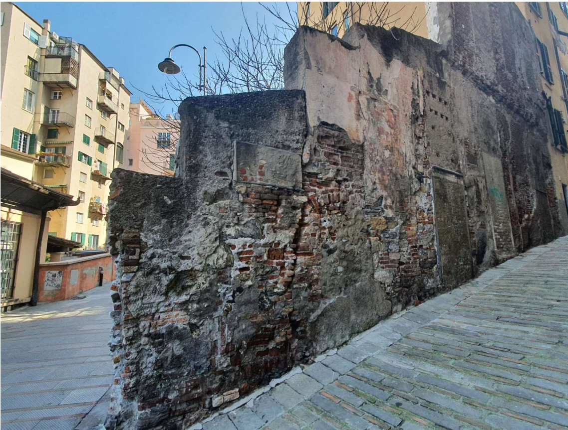
Foto 4 – Vista frontale della muratura lato Vico delle Fate; si osserva la parte bassa e scalettata in primo piano e, a destra, la parte di muratura più alta con la porzione del primo piano aggettante.
