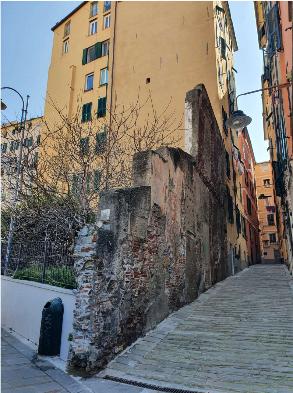
Foto 1 - Vista della muratura lato Vico delle Fate.
