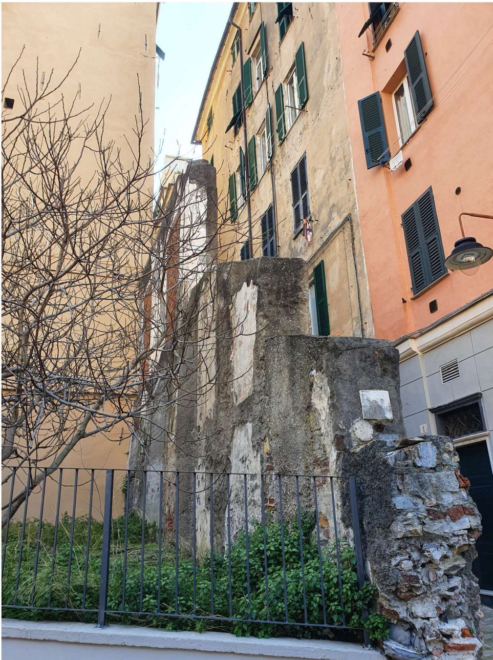
Foto 2 – Vista della muratura lato giardino privato.
