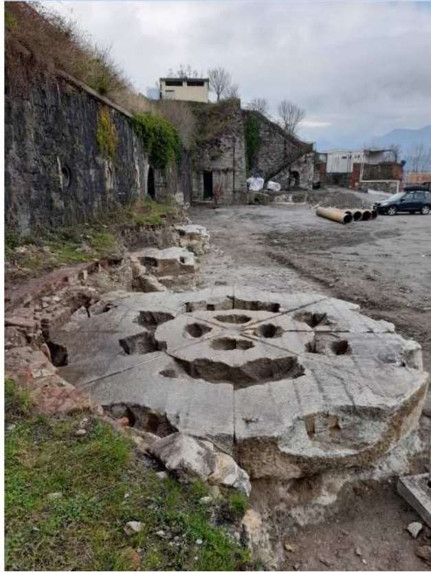
Foto n.ro 11: completamento scavi
