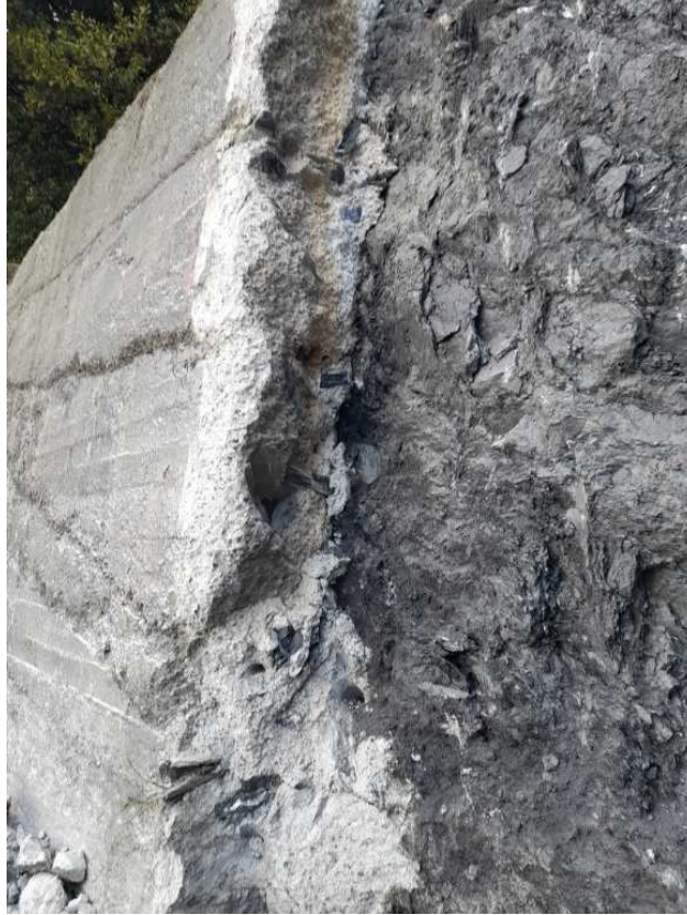
Foto n.ro 15: fronte murario Est
