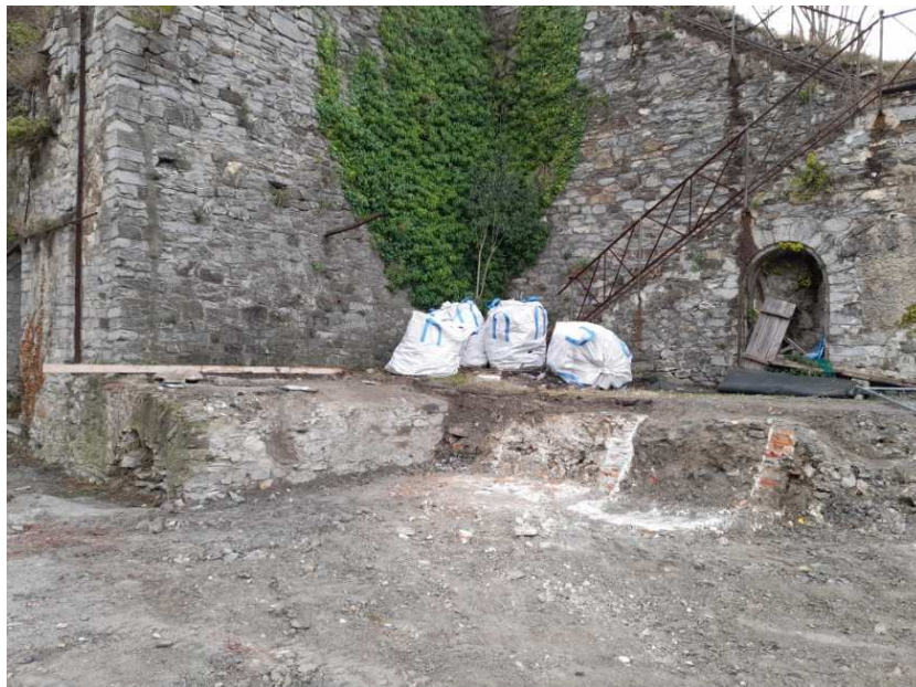
Foto n.ro 12: completamento scavi
