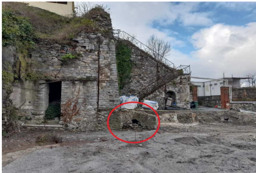
Foto n.ro 4: ritrovamento contrafforte
