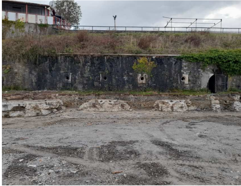
Foto n.ro 8: completamento scavi
