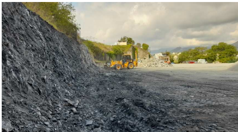
Foto n.ro 1: lavorazioni
