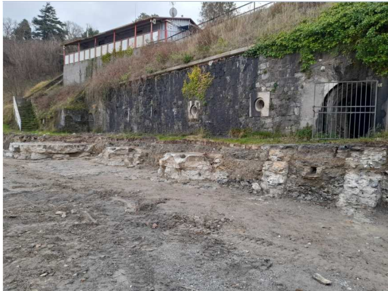
Foto n.ro 9: completamento scavi
