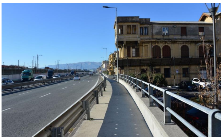
Figura 4 Marciapiede esistente lato nord della carreggiata
