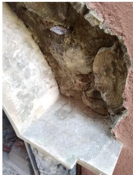
*Rimozione della muratura ammalorata.*
