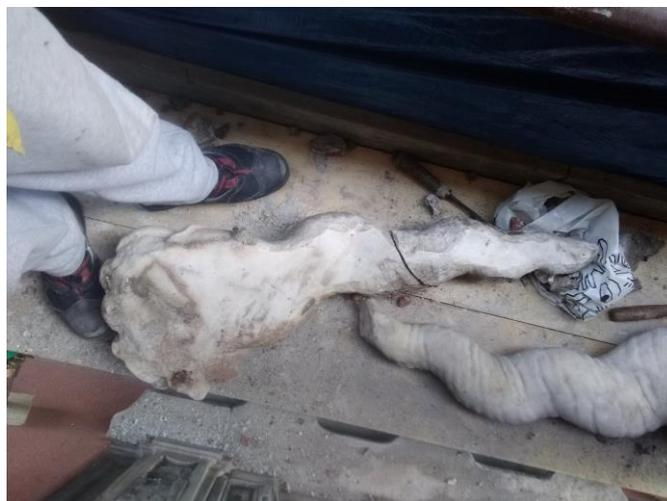
*Cornucopie durante la fase di abbassamento della malta di ricarica in cemento / stato della muratura / cornucopie smontate*
