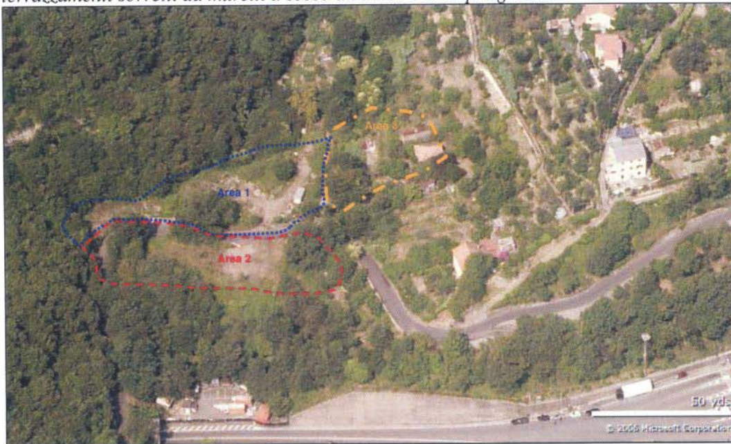
Fig. 8: panoramica area di intervento (vista da nord-est).
