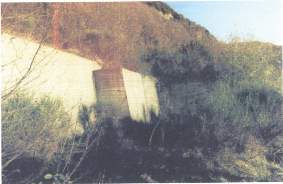
Costruzione edificio sul mappale 644 interrotta nel 1975
