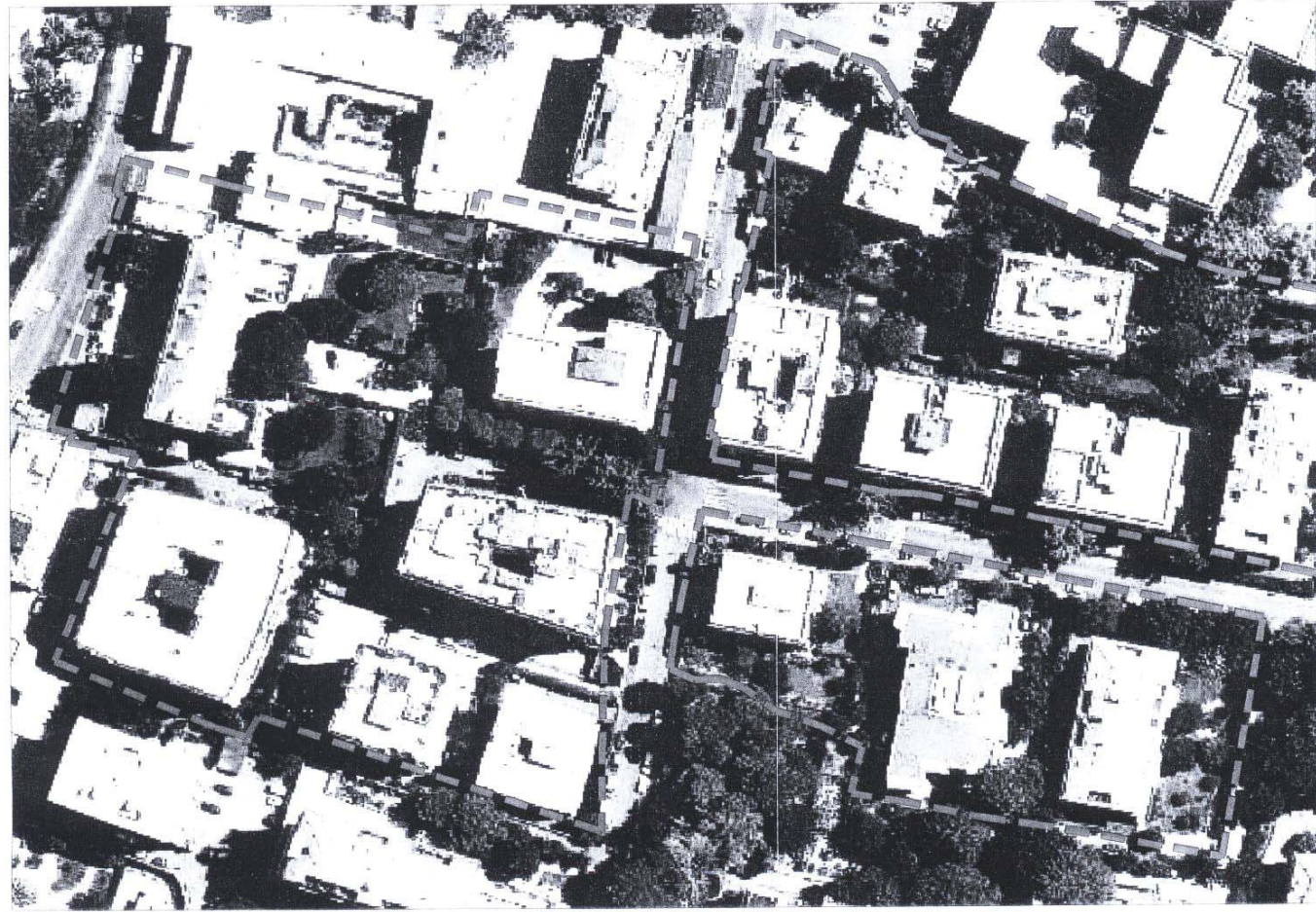
FOTO AEREA DI DETTAGLIO "A"
