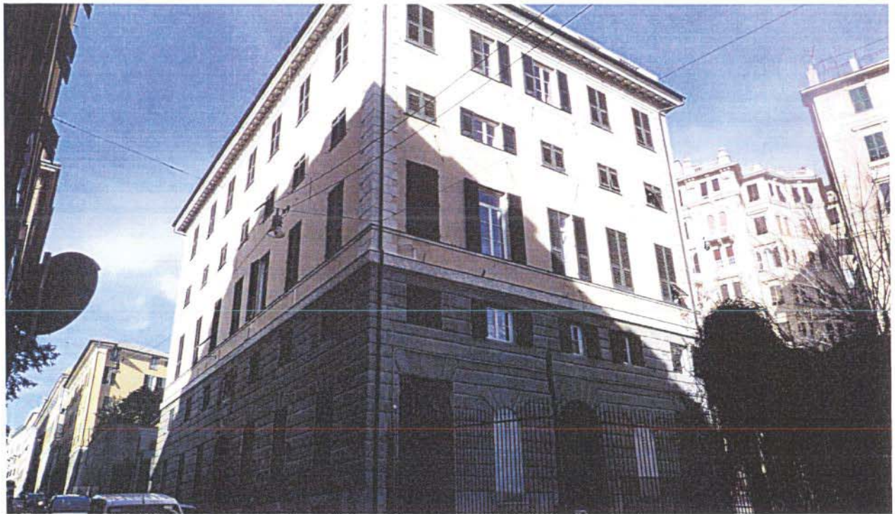
1 - VISTA DA VIA SERRA – PROSPETTI SUD ED EST
