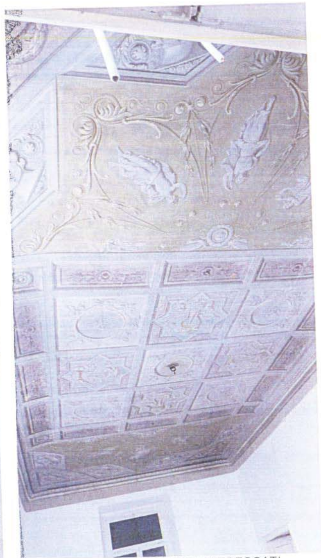
11 - PARTICOLARE SOFFITTI AFFRESCATI
