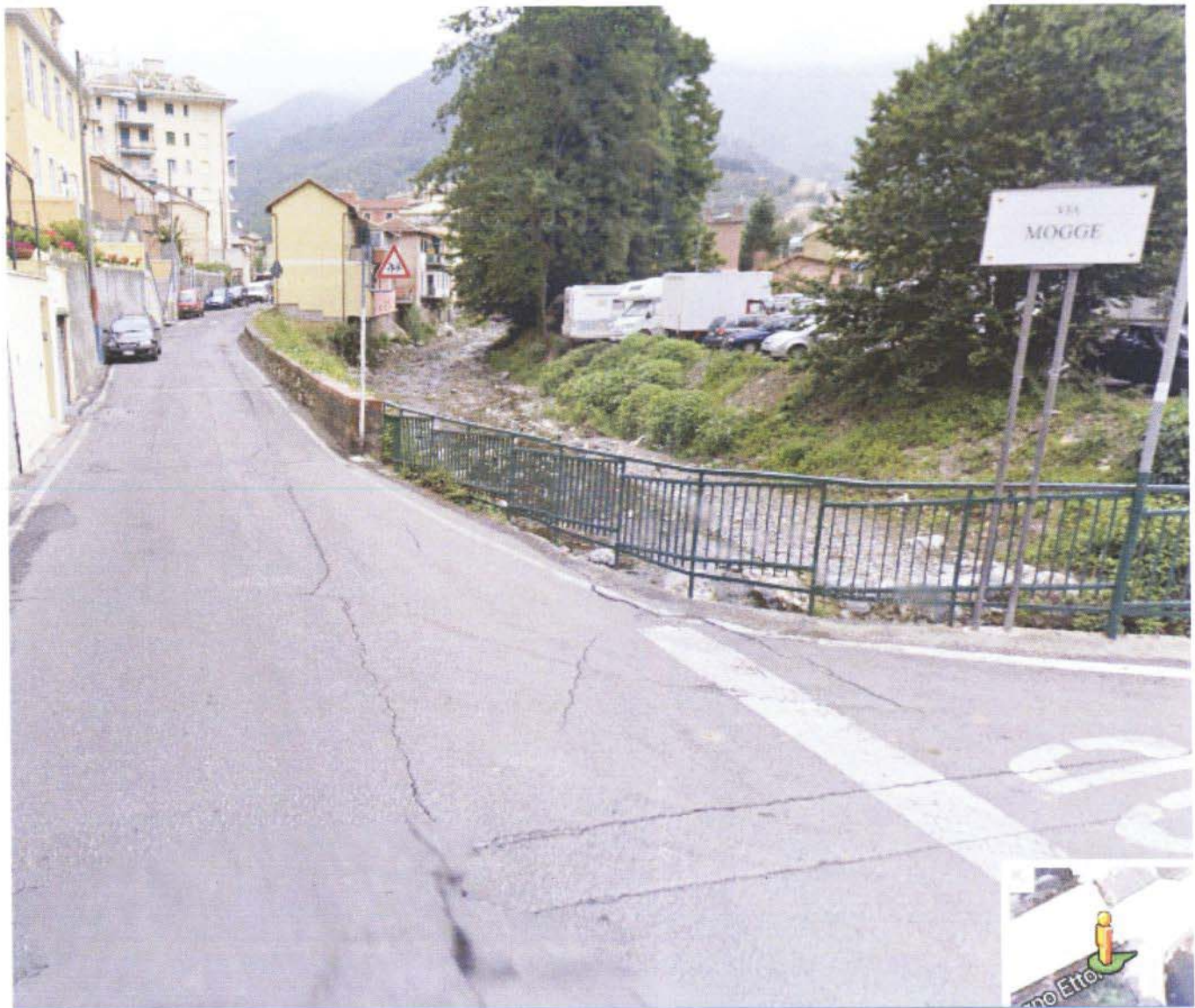
TRA PONTE EX AREA PLINTHOS E VIA ETTORE BISAGNO
