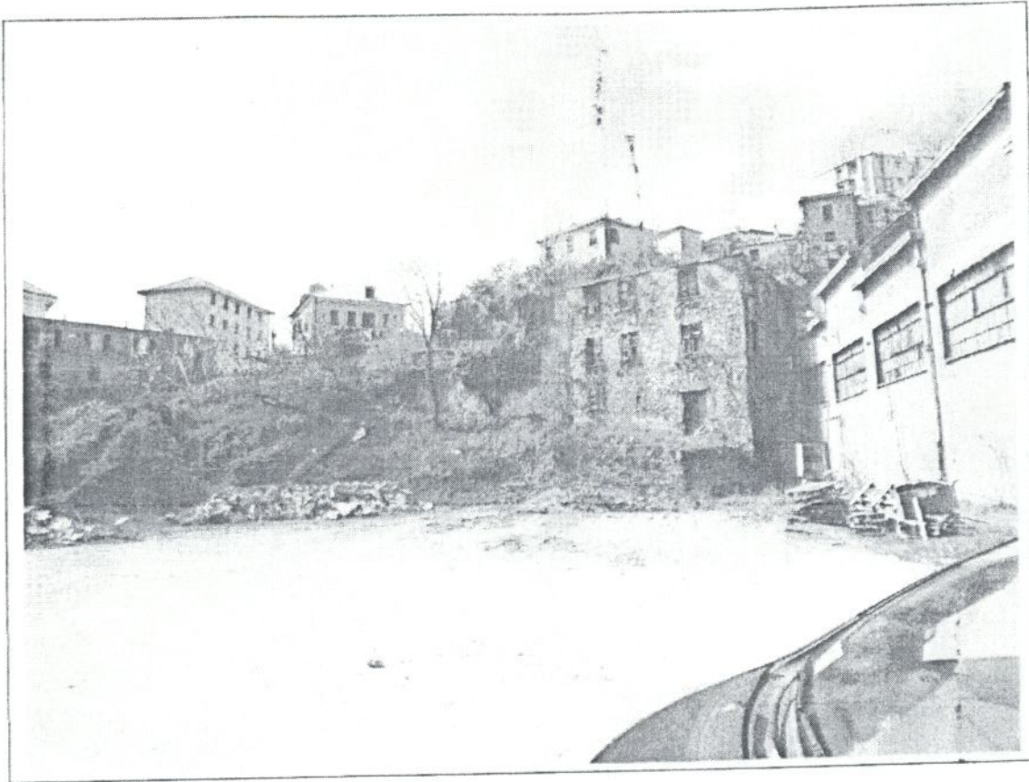
Vista n°2 dalla dell'area cortilizia antistante il capannone e dell'edificio di civile abitazione diruto
