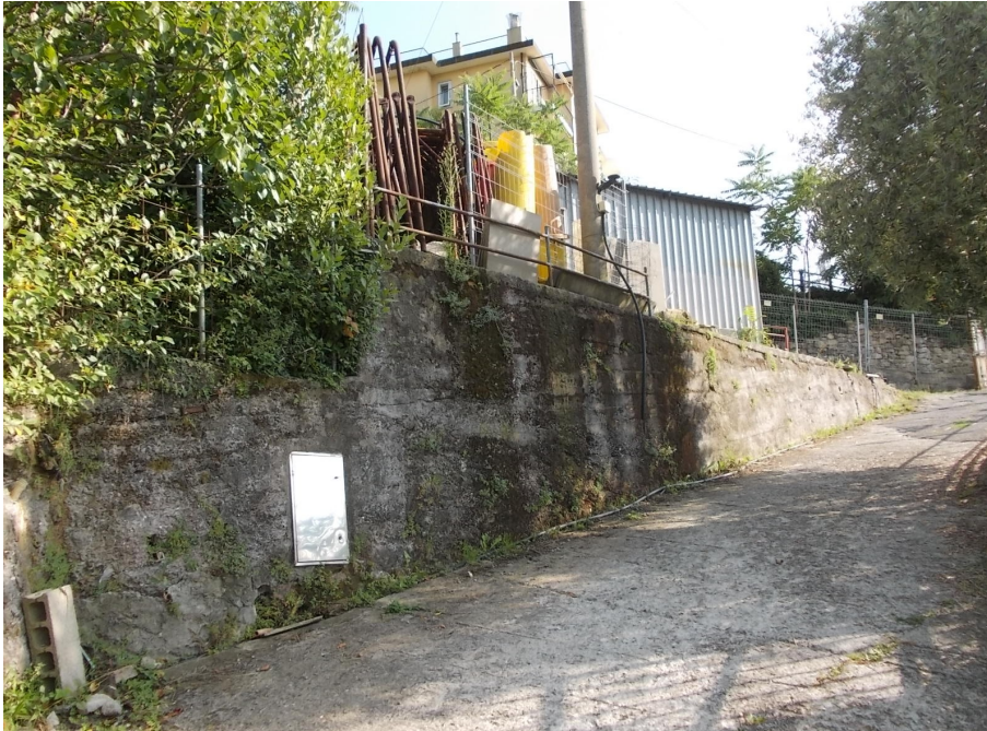
Vista della fascia sistemata da SUD: il muro di sostegno della fascia, realizzato da oltre 30 anni, non presenta alcun fenomeno fessurativo o cinematico
