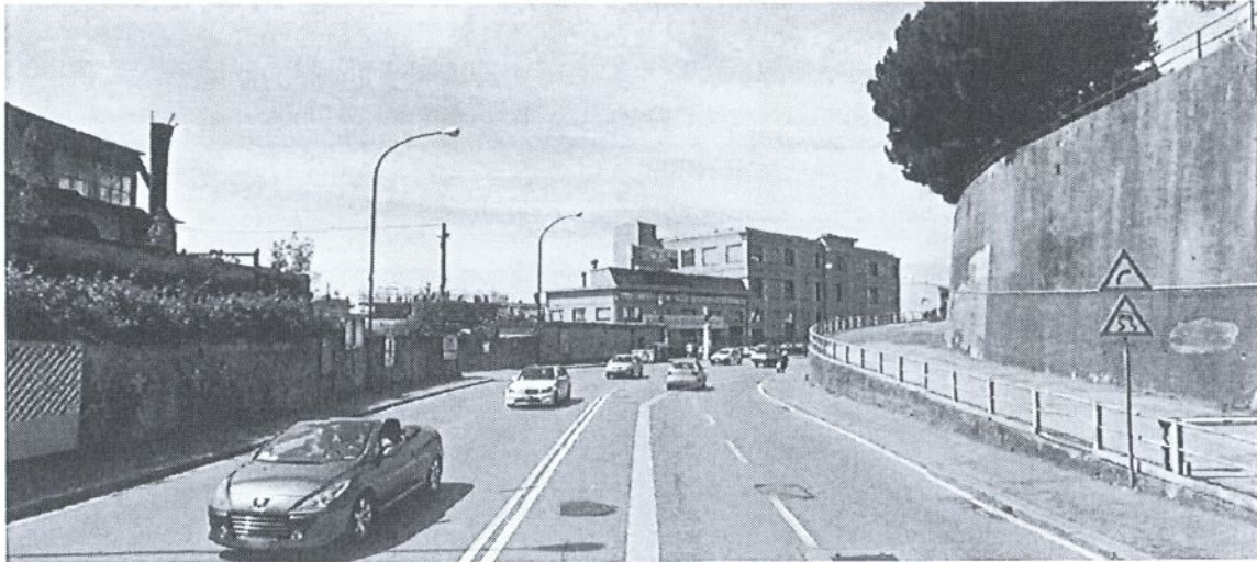
Foto 1 Vista (parziale) da levante dell'area su cui è prevista la realizzazione della rotatoria (sulla sinistra: scorcio dell'edificio ex Fonderie Ansaldo; sulla destra: muro di sostegno del terrapieno dell'insediamento Superba e rampa di accesso all'insediamento; sullo sfondo: edificio di Fabbricazioni Idrauliche).
