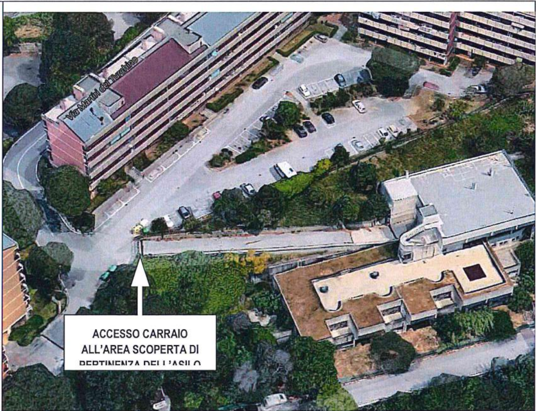
foto aerea del contesto in cui collocata l'opera
