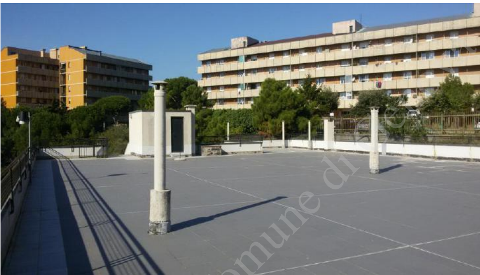
Foto 4b - copertura oggetto di intervento
