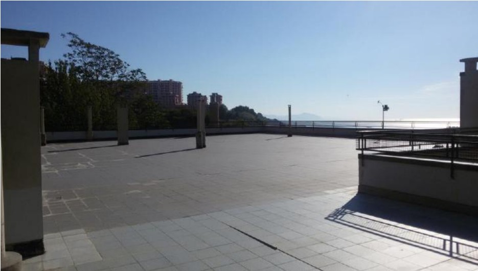
Foto 4a - copertura oggetto di intervento
