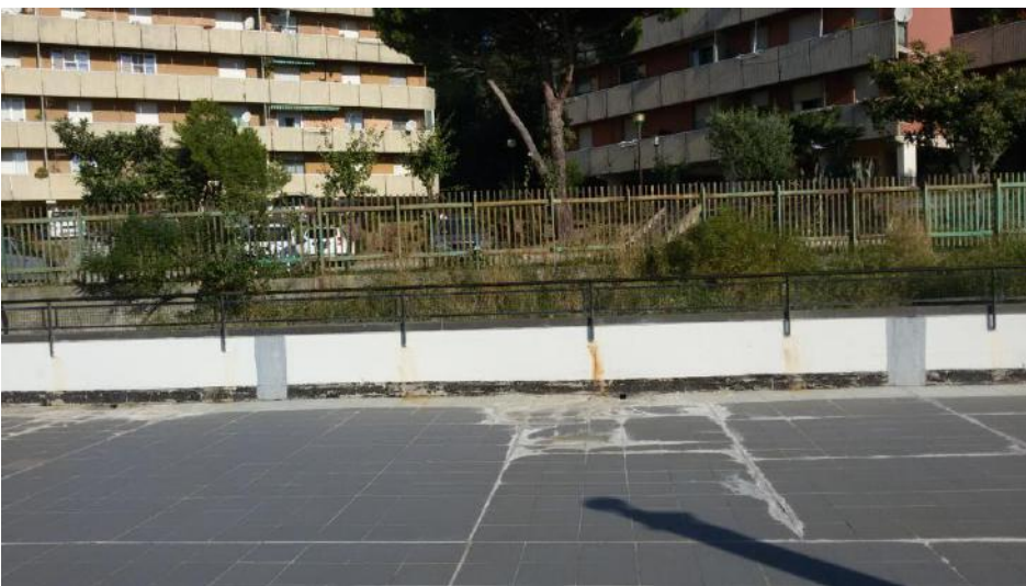
Foto 4c - copertura oggetto di intervento
