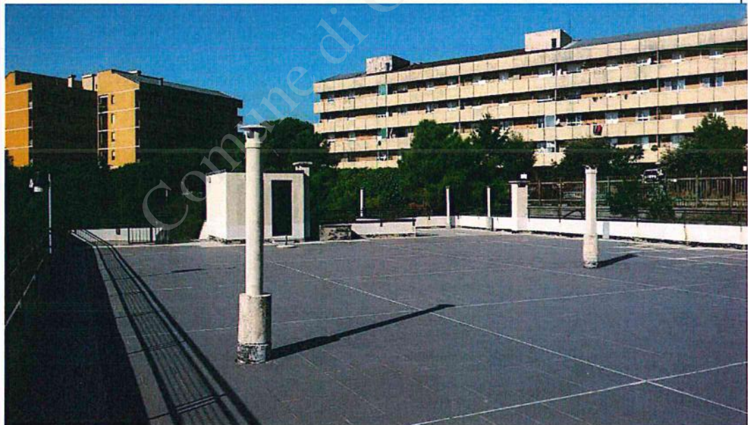
foto della copertura oggetto di intervento
