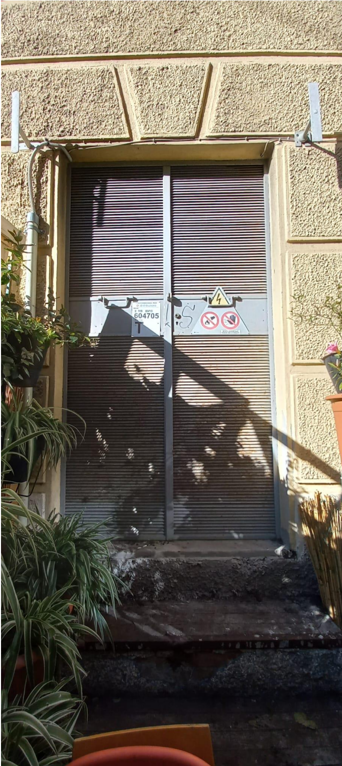
Foto 4: Vista locale e-distribuzione
