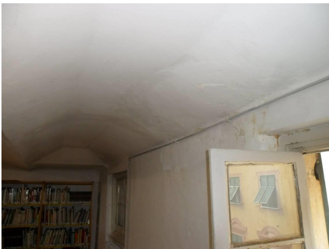
Foto 18 – Dettaglio della zona in corrispondenza del camino non più in funzione, già oggetto di intervento.
