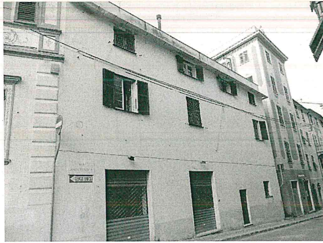
Foto 3 – Fronte su via Marco Sala (nord) con in evidenza l'alto muretto attico
