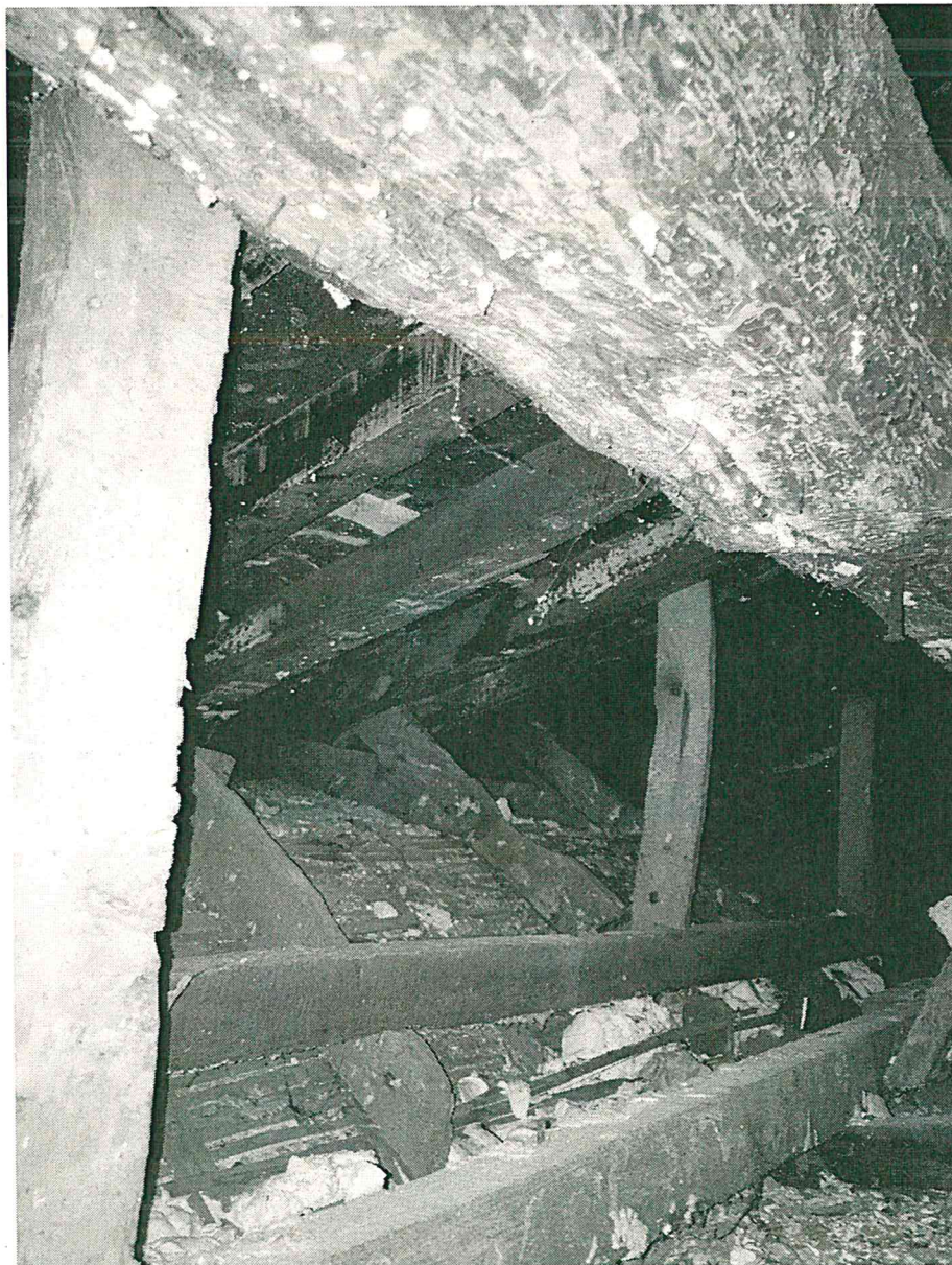
Foto 8 – Vista del sistema di centinatura lignea delle volte in canniccio
