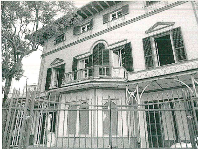
Foto 1 – Il fronte principale di Villa Gropallo (sud), prospiciente l'omonimo parco. Oggetto di intervento è la copertura di un volume laterale posto alla sinistra del corpo di fabbrica principale (indicato dalla freccia in colore rosso).
