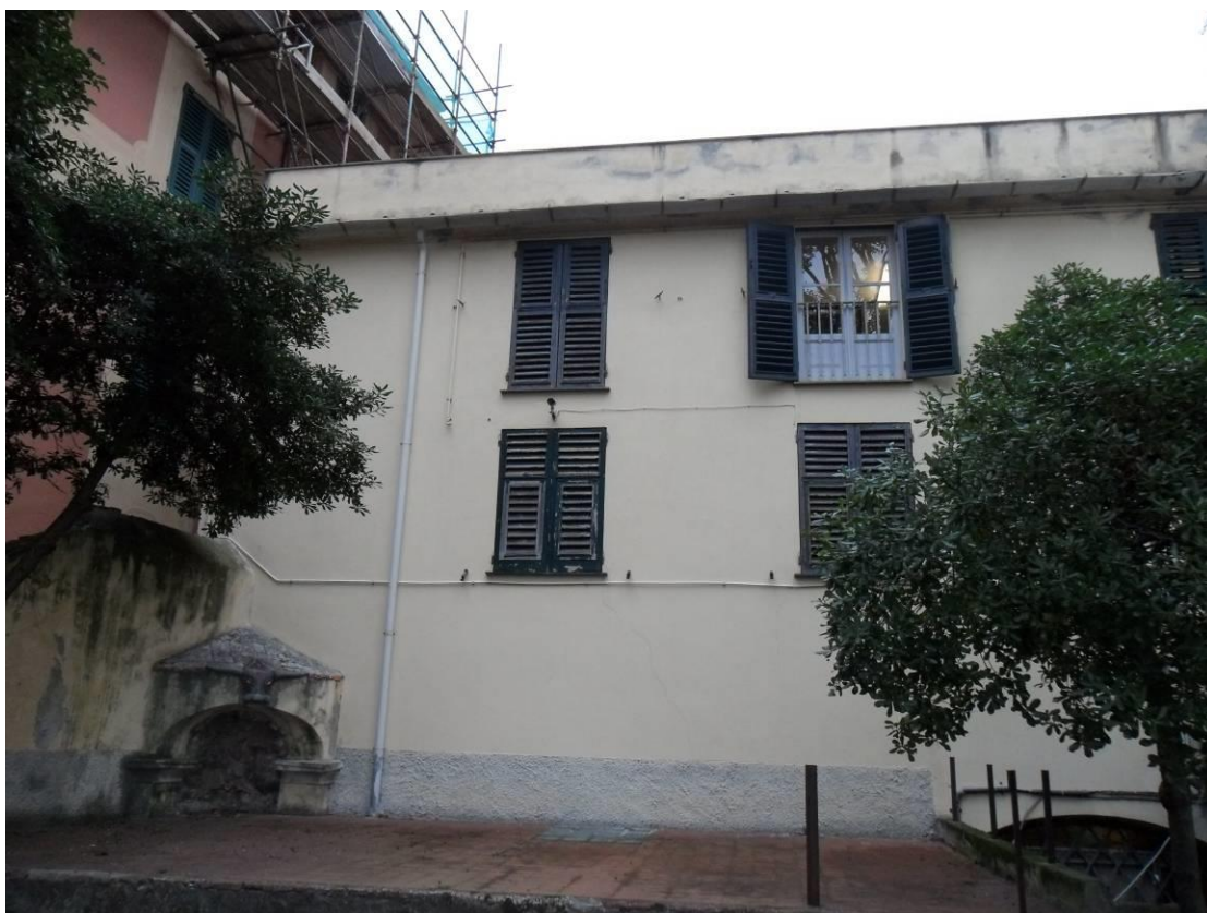
Foto 6 – Prospetto verso il parco (sud)
