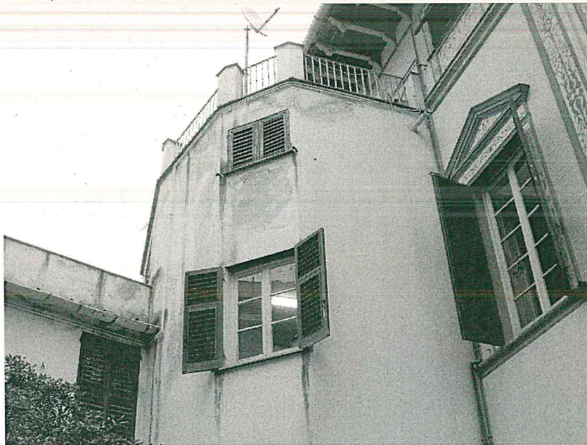
Foto 6 – Corpo emergente – fronte verso il parco
