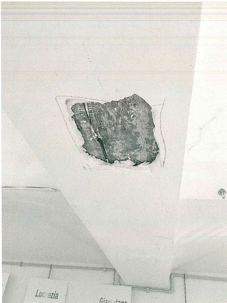
Foto 9 – Vista del punto di indagine n. 4
