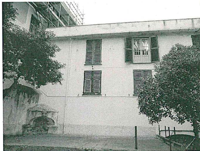
Foto 5 – Prospetto verso il parco (sud)
