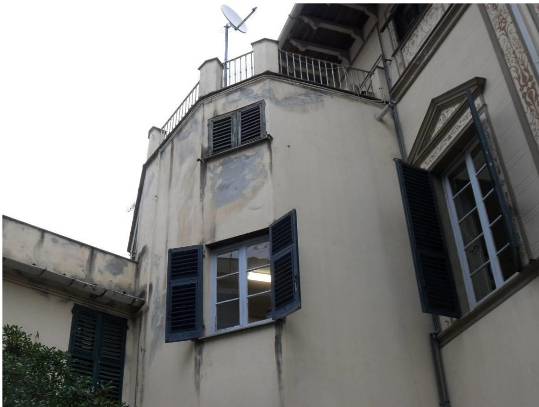
Foto 7 – Corpo emergente – fronte verso il parco
