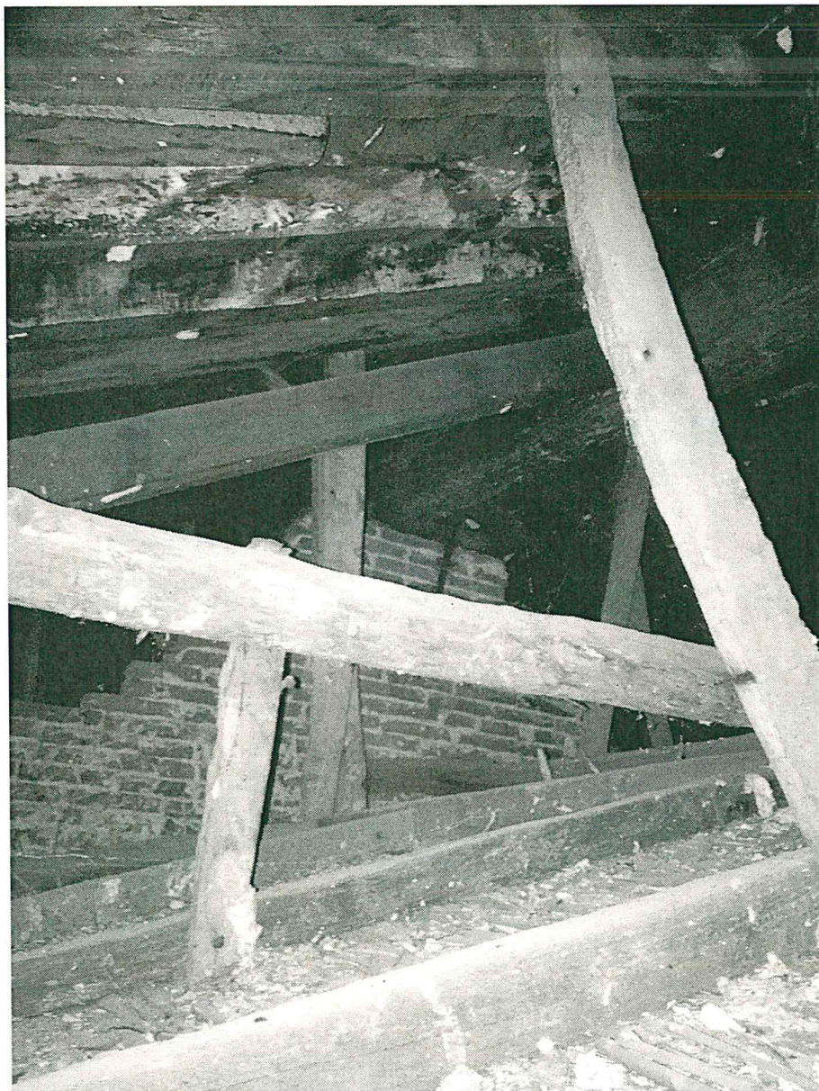
Foto 6 – Vista del muro M che prosegue fino a sorreggere la trave di colmo
