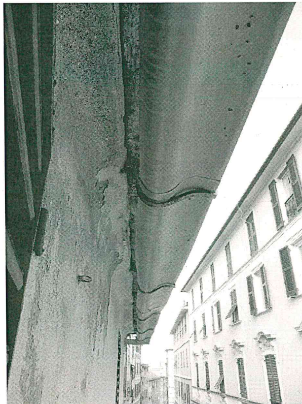
Foto 9 – Fronte su via Marco Sala: dettaglio del canale di gronda e del cornicione.
