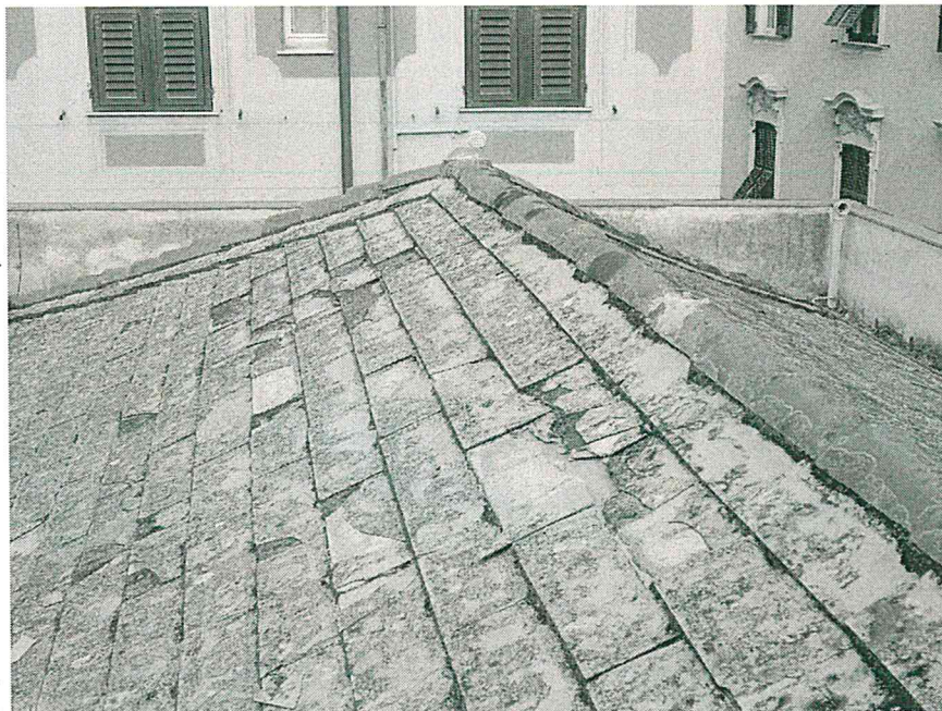
Foto 7 – La copertura a falde oggetto di intervento (manto in lastre di ardesia e colmi in laterizio)
