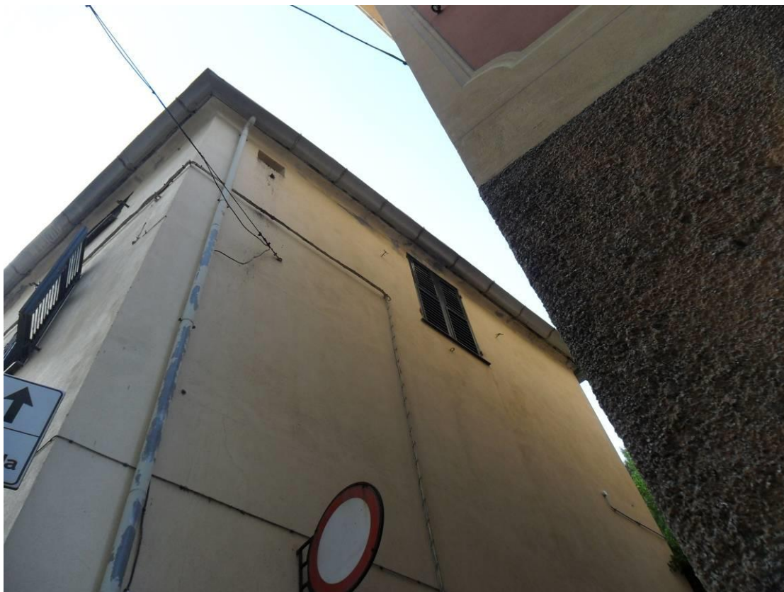
Foto 4 – Prospetto su Viottolo Nicolò Ardizzone (ovest)
