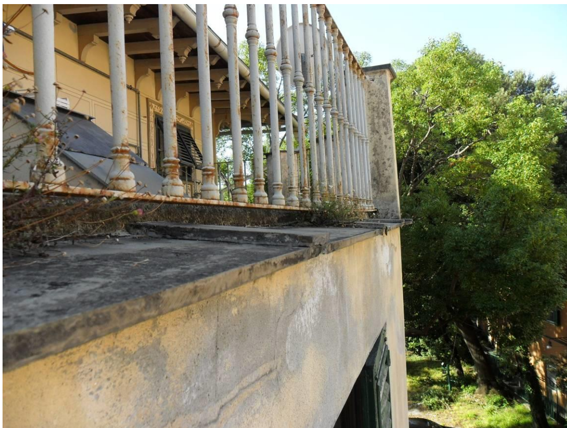
Foto 13 – Corpo emergente con ringhiera in ferro verniciato adiacente alla pavimentazione
