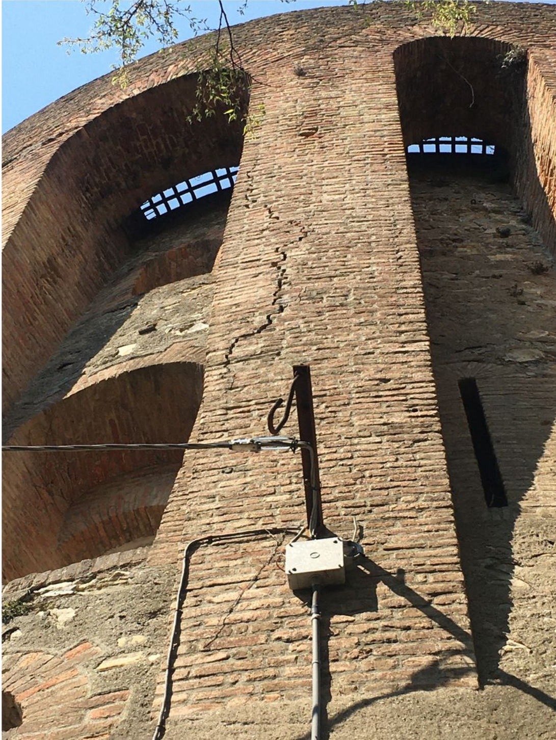
Esempio di lesione verticale
