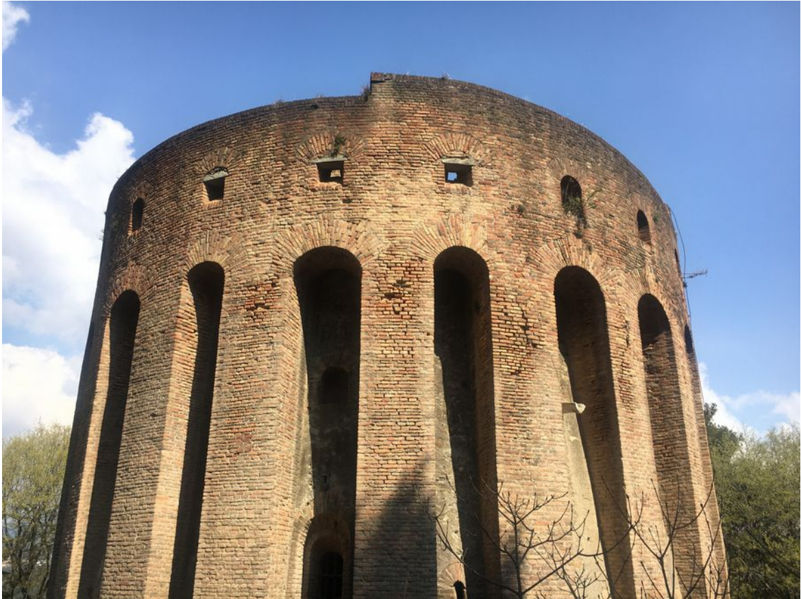
Vista d'insieme lato strada
